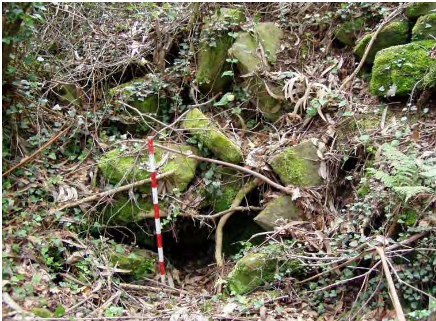
Fig. 79.- Bocamina colapsada. Oles (Villaviciosa, Asturias). Imagen: AMM.
