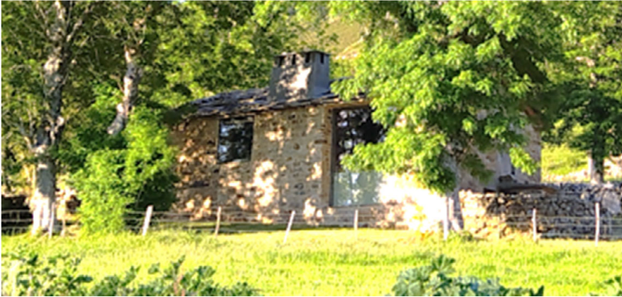
FIGURA 11. Ejemplo de apertura de ventanales no recomendado
