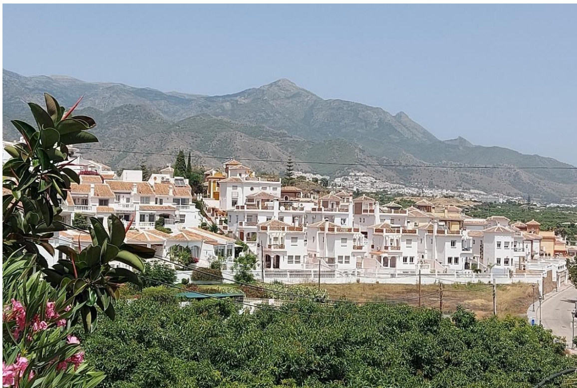
Figura 115. Urbanización Vista del Mar en Torrox-Park a menos de 600 metros del borde costero. Fuente: Fotografía de autor.
