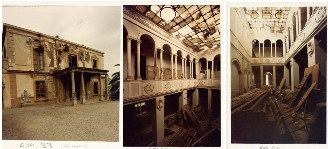
Figura 44. Carmen de los Mártires: estado de ruina y restauración, 1980-1987. Nota: Seguimiento fotográfico para el proceso de restauración del Carmen de los Mártires desde el 1980 al 1987. Fuente: Archivo Municipal de Granada (AMGR), Archivo fotográfico, Ayuntamiento de Granada. Nº registro: 300404. Signatura: 16.003.01. Montaje: Elaboración propia.
