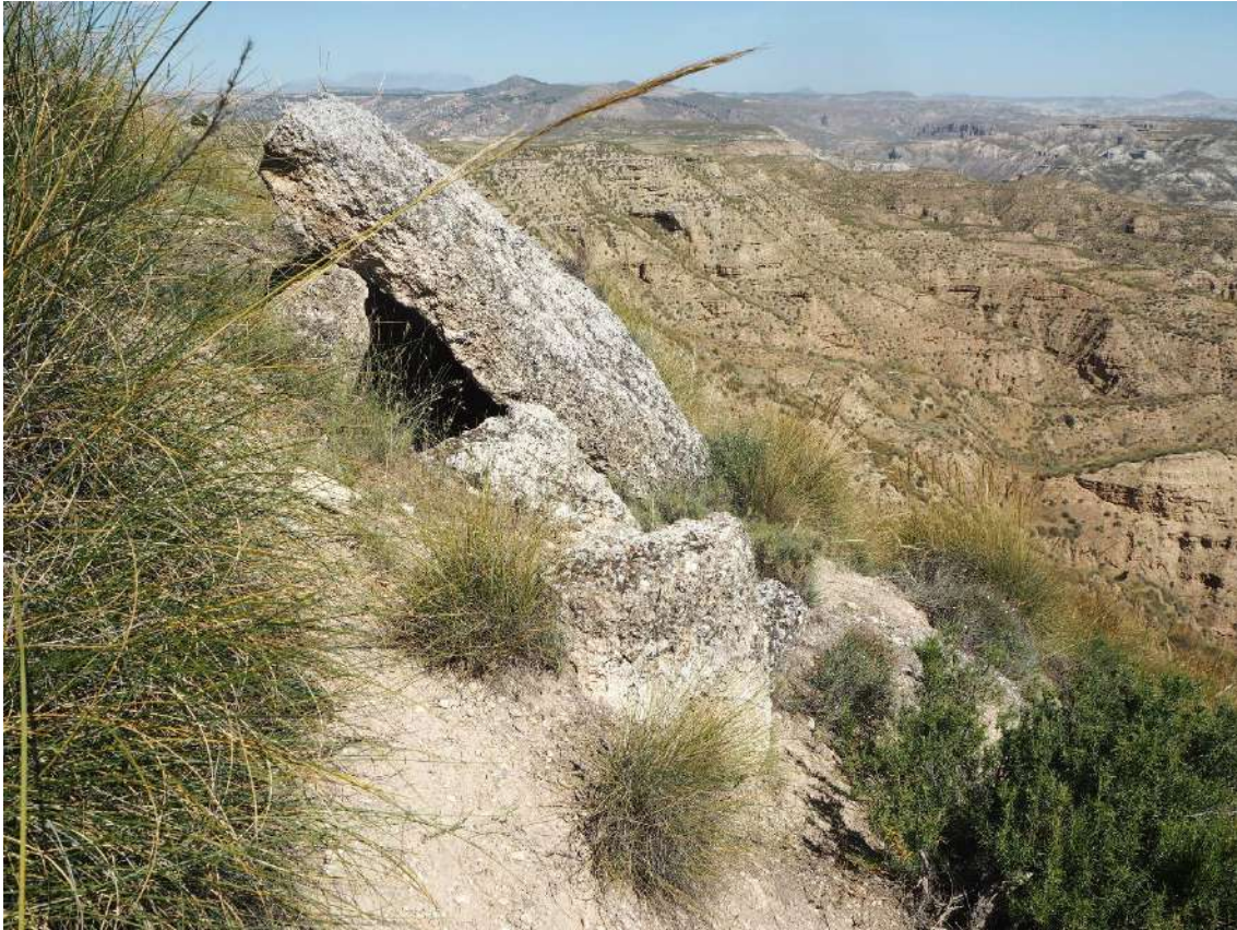
Figura 28. Dolmen La Sabina 15. Se aprecia el deslizamiento de los ortostatos y de la cubierta hacia el barranco. J.A. Bueno.
