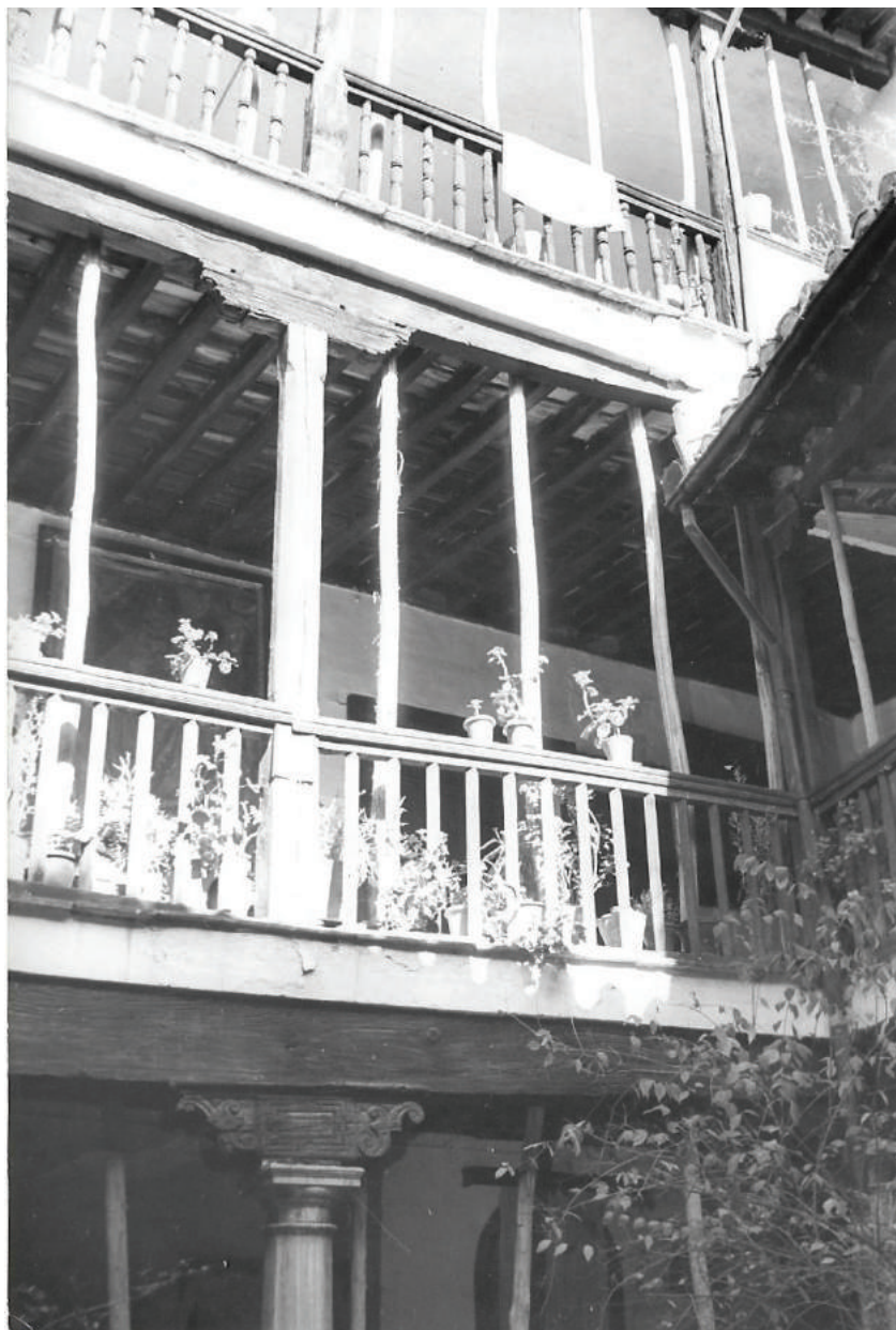
El patio renacentista apuntalado, durante las obras de 1970. Archivo de la Comunidad de Madres Carmelitas de la Antigua Observancia.
