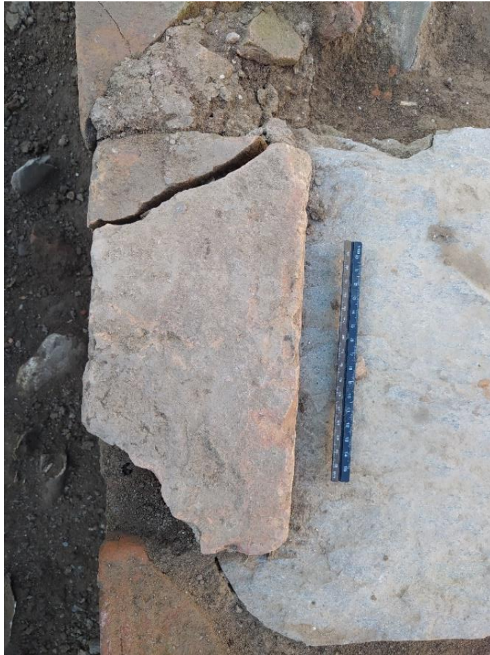
Figura 163 S.A-3 CEF 08 Detalle ladrillo sobre cubierta
