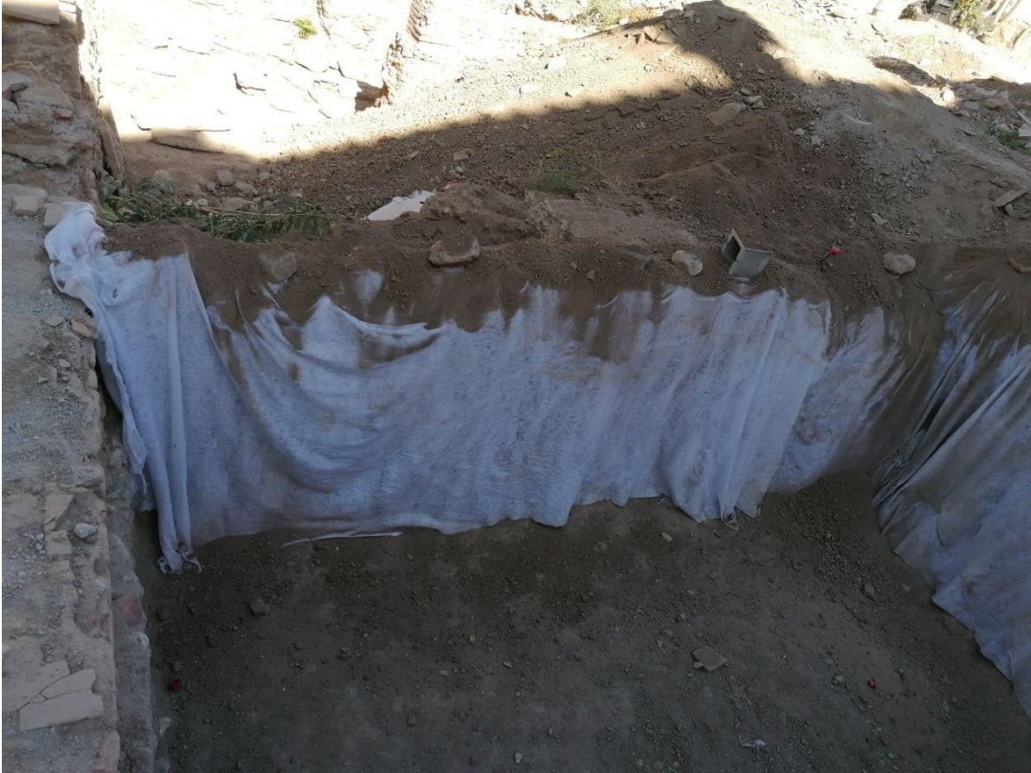
Figura 44 Perfiles cubiertos con geotextil
