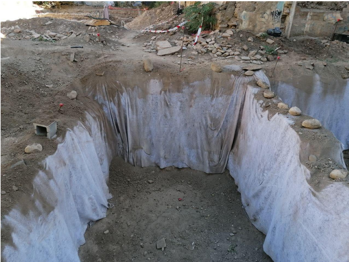
Figura 45 Perfiles cubiertos con geotextil
