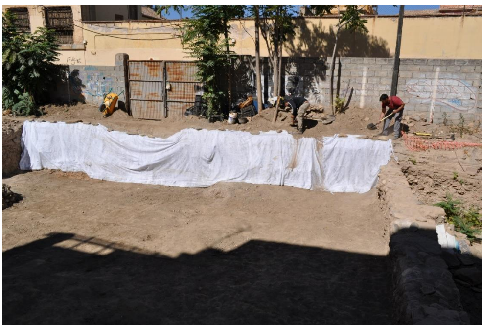
Figura 39 Vista del proceso de cubrimiento de los perfiles con geotextil
