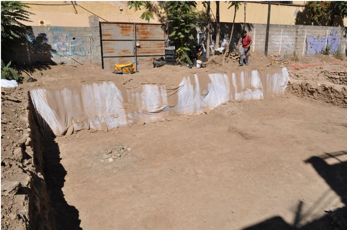
Figura 40 Vista del proceso de cubrimiento de los perfiles con geotextil
