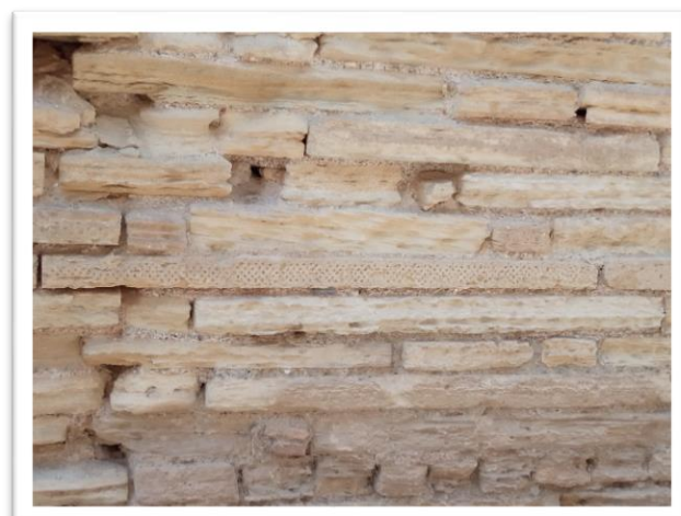
Figura 5 Detalle de los bordillos
