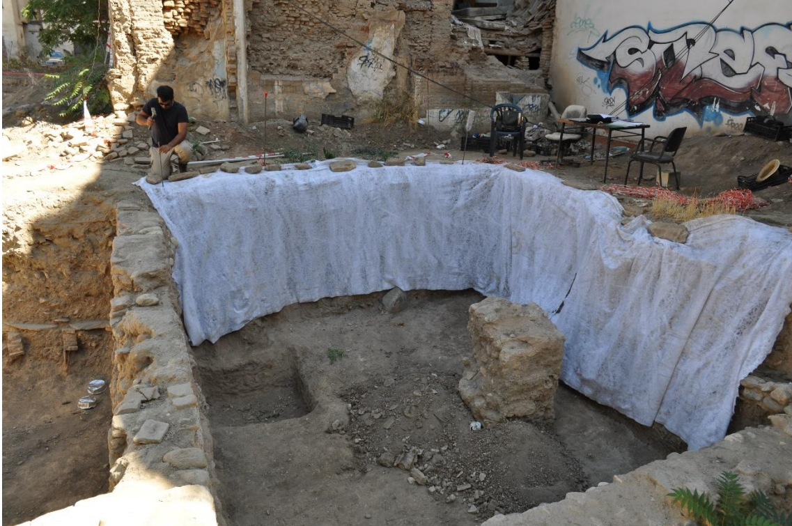
Figura 42 Vista del proceso de cubrimiento de los perfiles con geotextil
