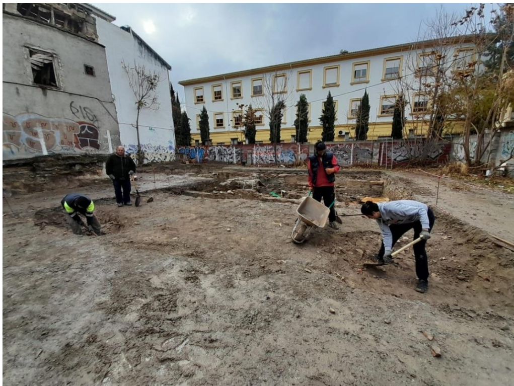
Figura 52 Vista general de las labores de rebaje durante su última ampliación
