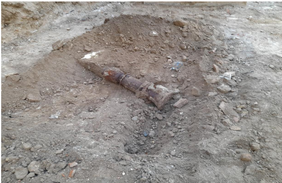
Figura 68 Detalle de pilona localizada durante la retirada de los escombros
