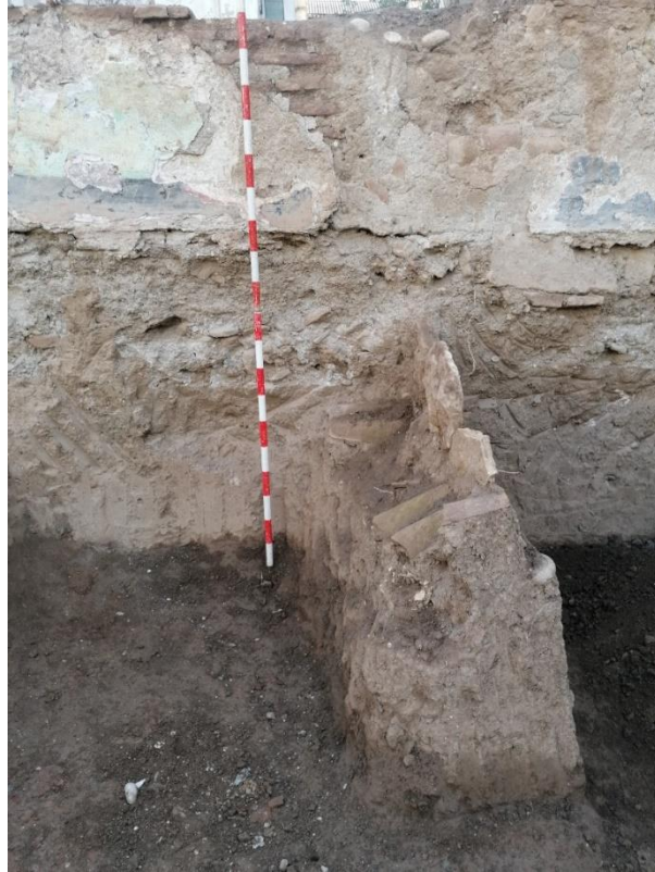
Figura 442 S. A-4 CEF 22 RH 22 Cubierta con parte de murete lateral de complejo superior, en relación con muro de carga
