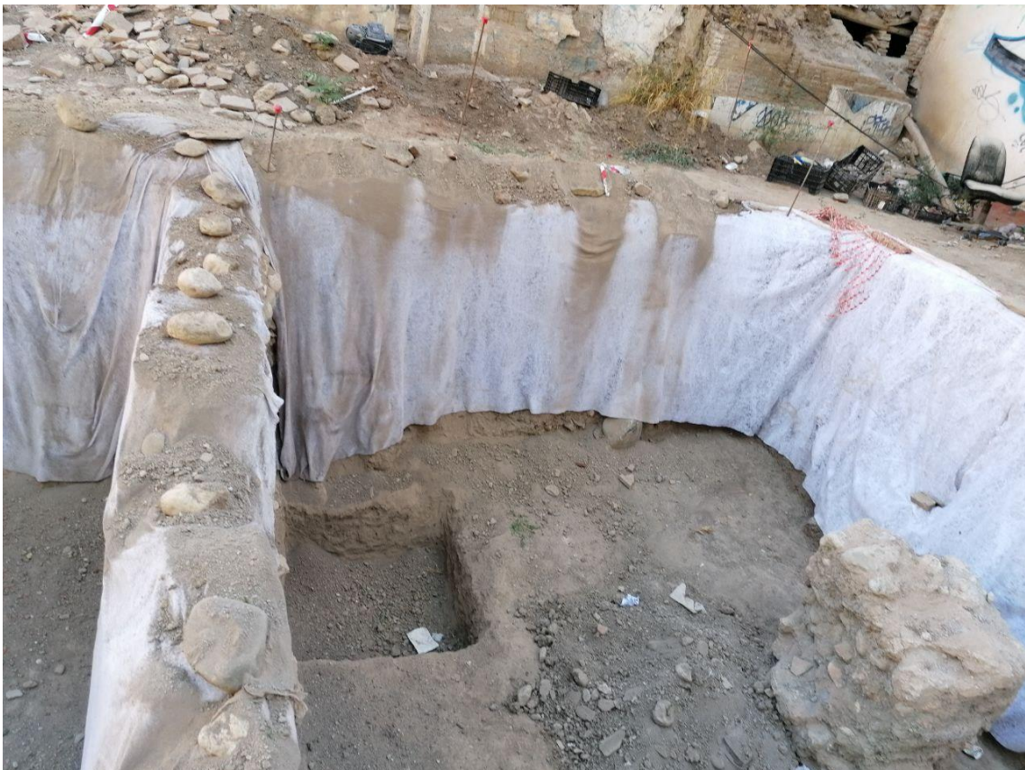
Figura 43 Perfiles cubiertos con geotextil
