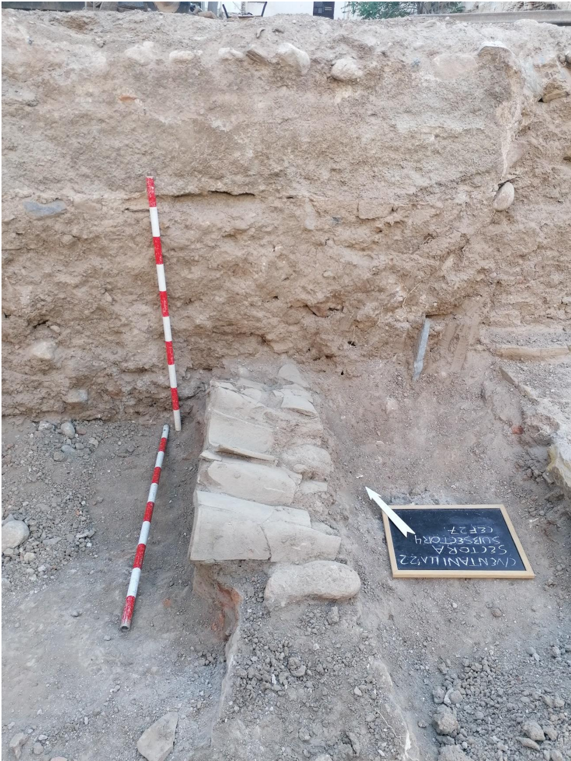
Figura 460 S. A-4 CEF 27 RH 27 Cubierta de tejas en relación con muro de carga
