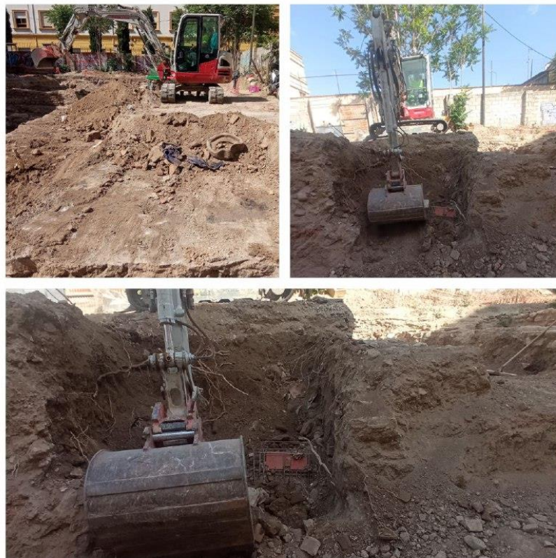
Figura 37 Vistas de la retirada de los escombros
