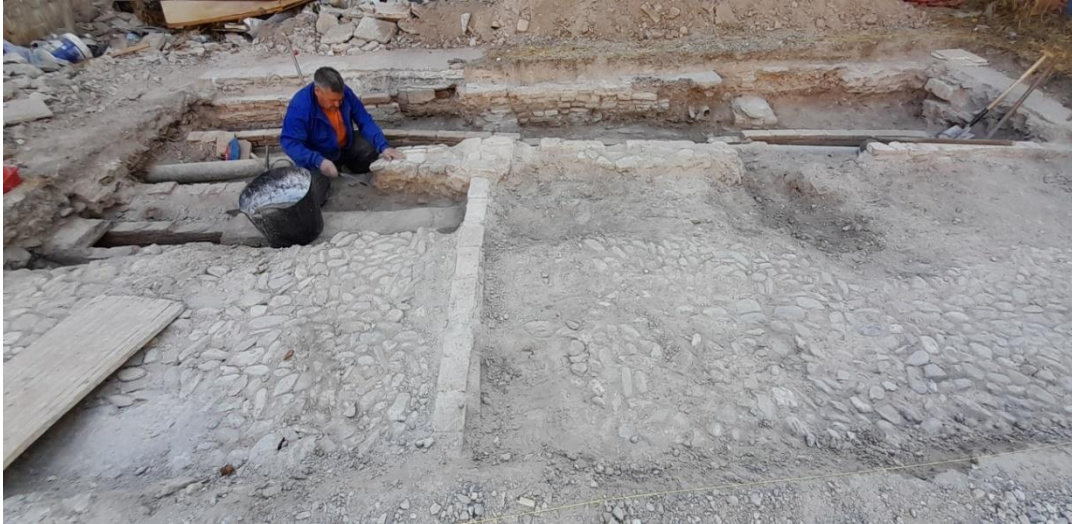
Figura 47 Vista durante las labores de rebaje, vista desde el NE
