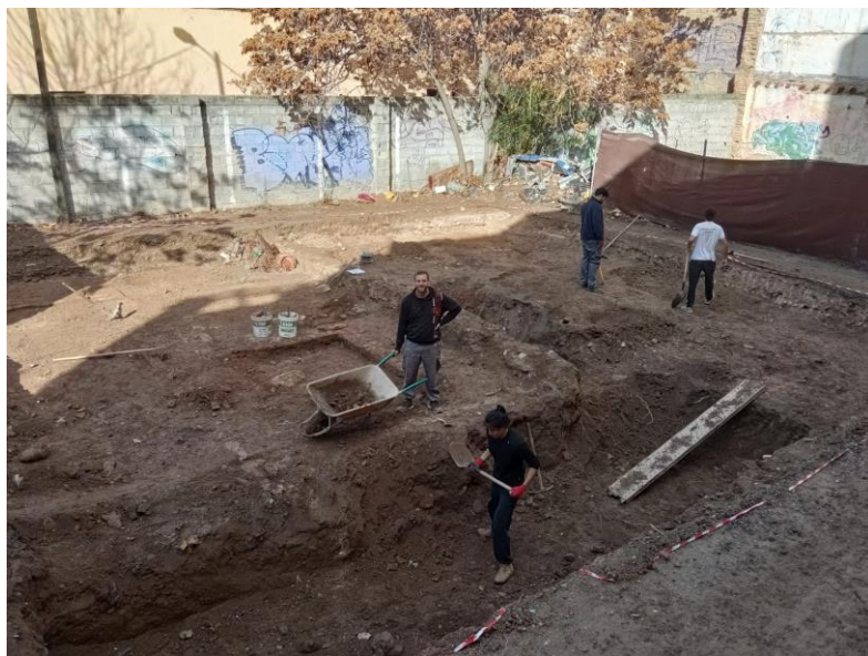
Figura 30 Vista general de las labores de rebaje manual en la fosa de la bolsa de escombros
