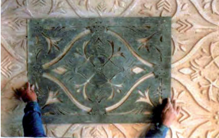
Fig. 10. Plantilla de metal usada para el proceso de esgrafiado. (De la Puente Robles)
