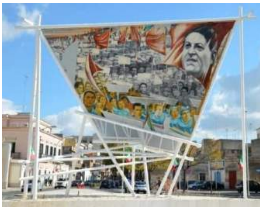
Fig. 456 E.De Conciliis e R. Falciano, Giuseppe di Vittorio e la condizione del mezzogiorno , nueva estructura metálica tras la restauración de 2017.
