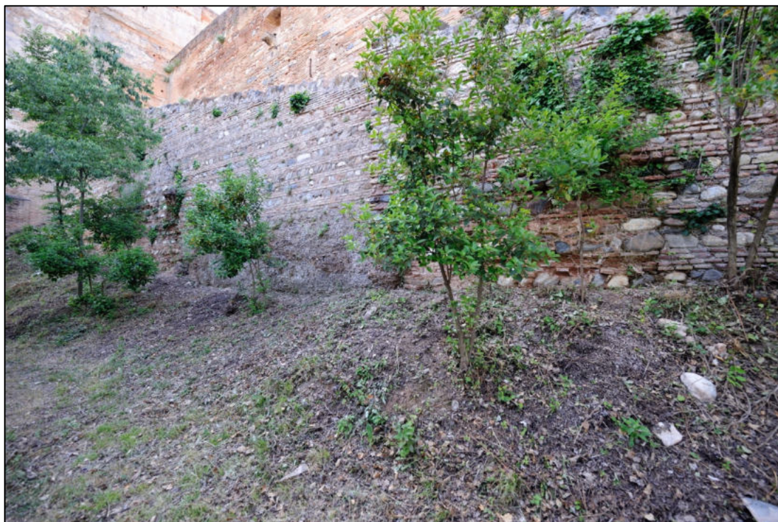
Foto.— Rampa de acceso a la Puerta de las Armas.
