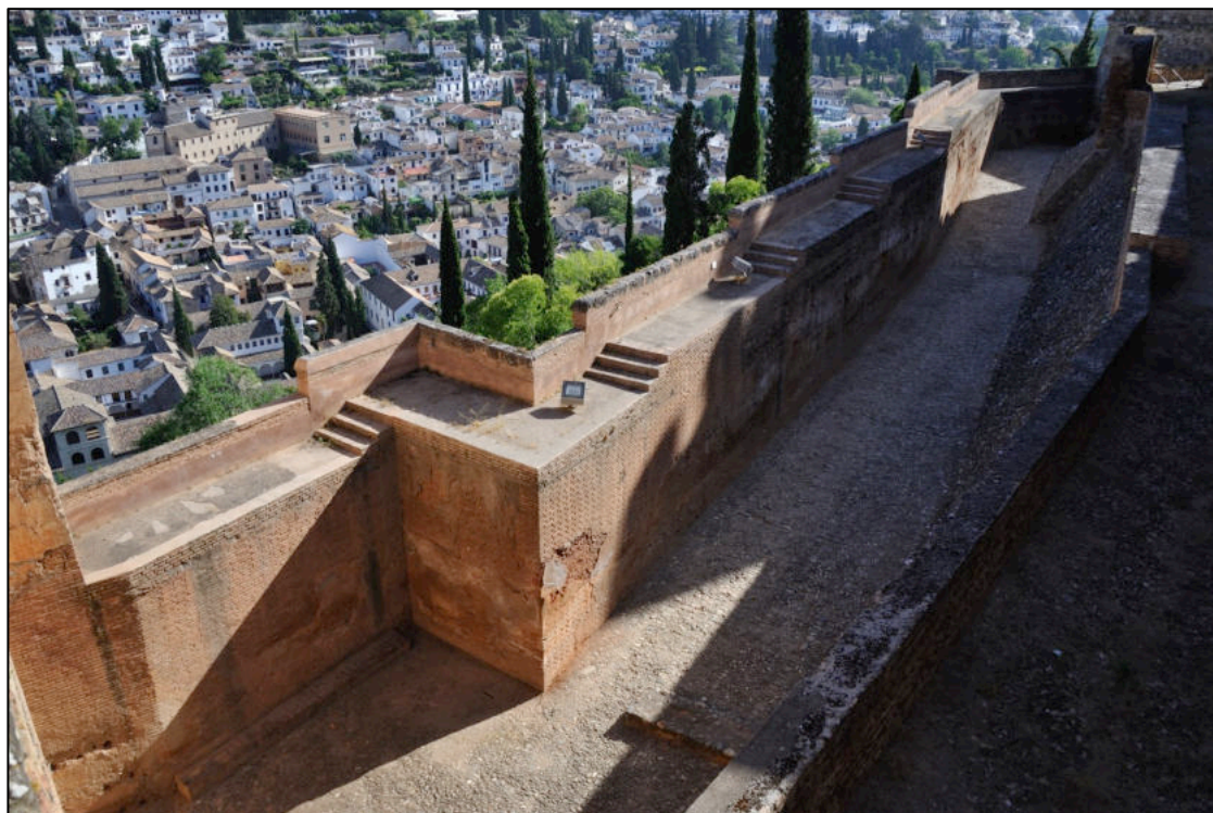
Foto.— Muralla exterior norte.
