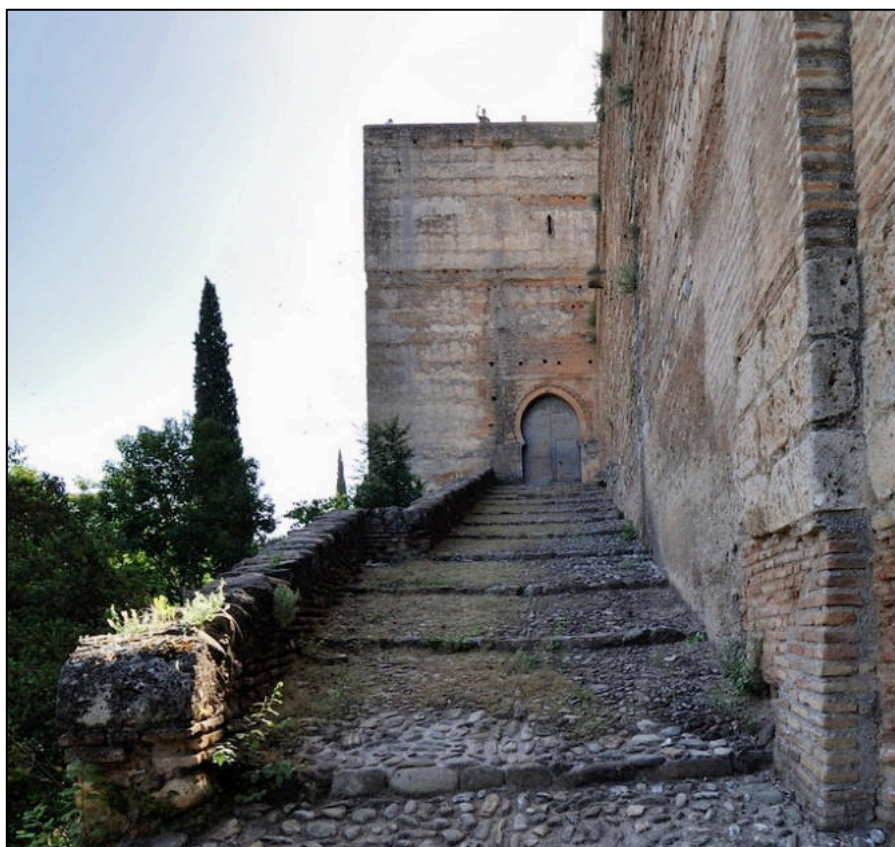
Foto.— Puerta y Torre de las Armas.
