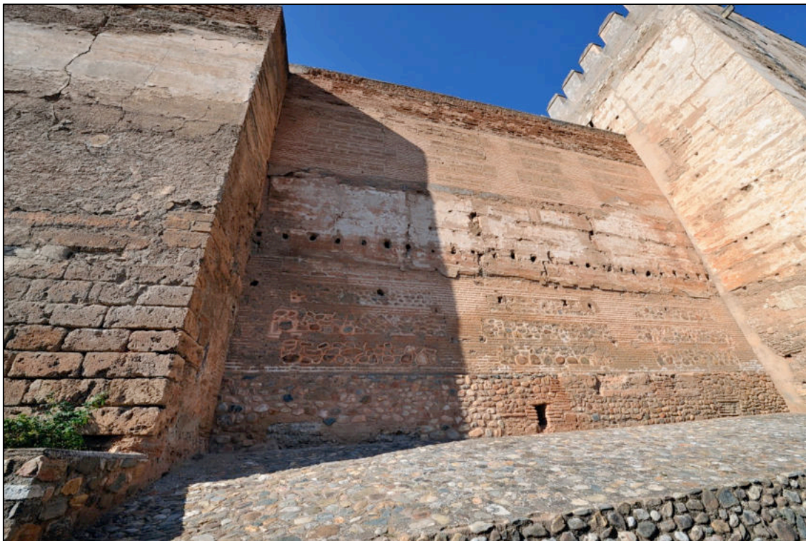
Foto.— Muralla interior este.
