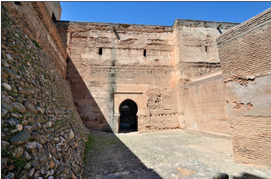
Foto.— Puerta y Torre de las Armas.
