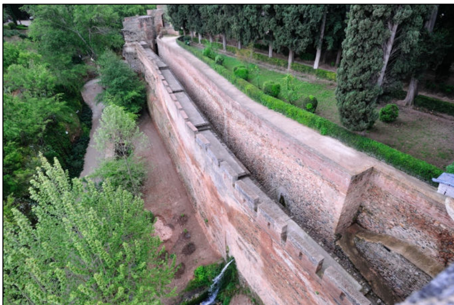
Foto.— Muralla entre las torres de las Infantas y del Cabo de la Carrera.
