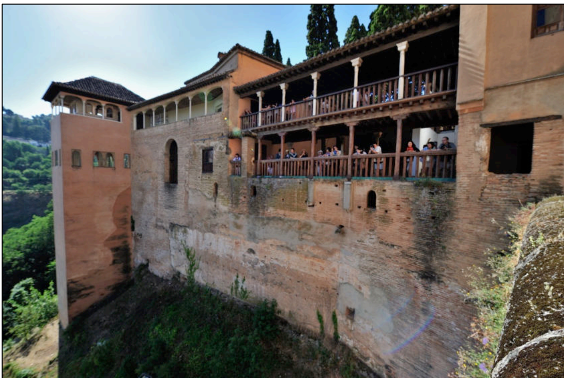
Foto.— Muralla entre la Torre de Comares y el Peinador de la Reina.
