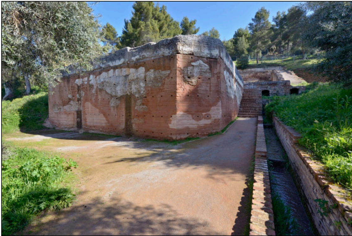
Foto.— Estructuras anexas al Albercón de las Damas.
