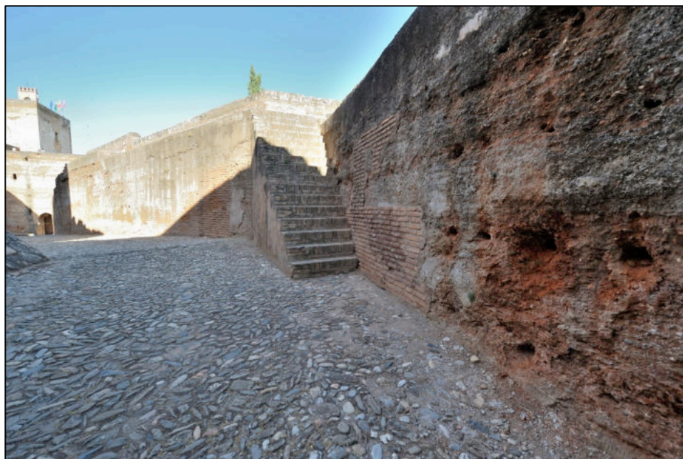
Foto.— Muralla exterior norte.
