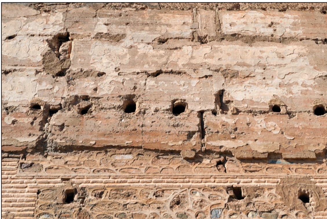
Foto.— Muralla interior este.
