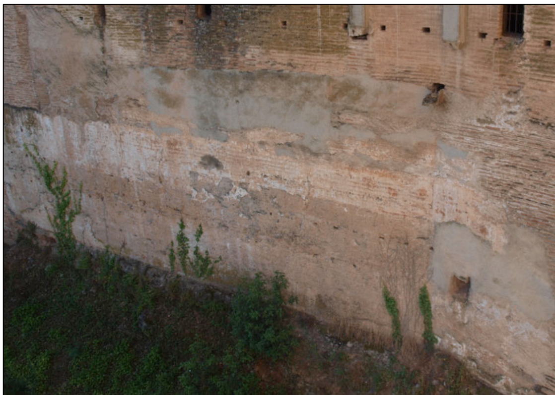
Foto.— Muralla entre la Torre de Comares y el Peinador de la Reina.
