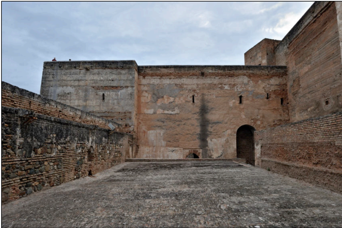
Foto.— Puerta y Torre de las Armas.
