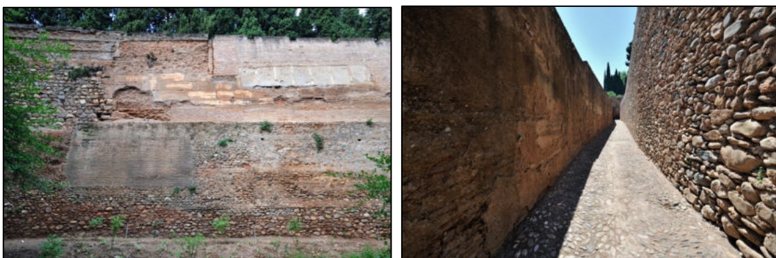
Foto.— Muralla entre las torres de las Infantas y del Cabo de la Carrera.
