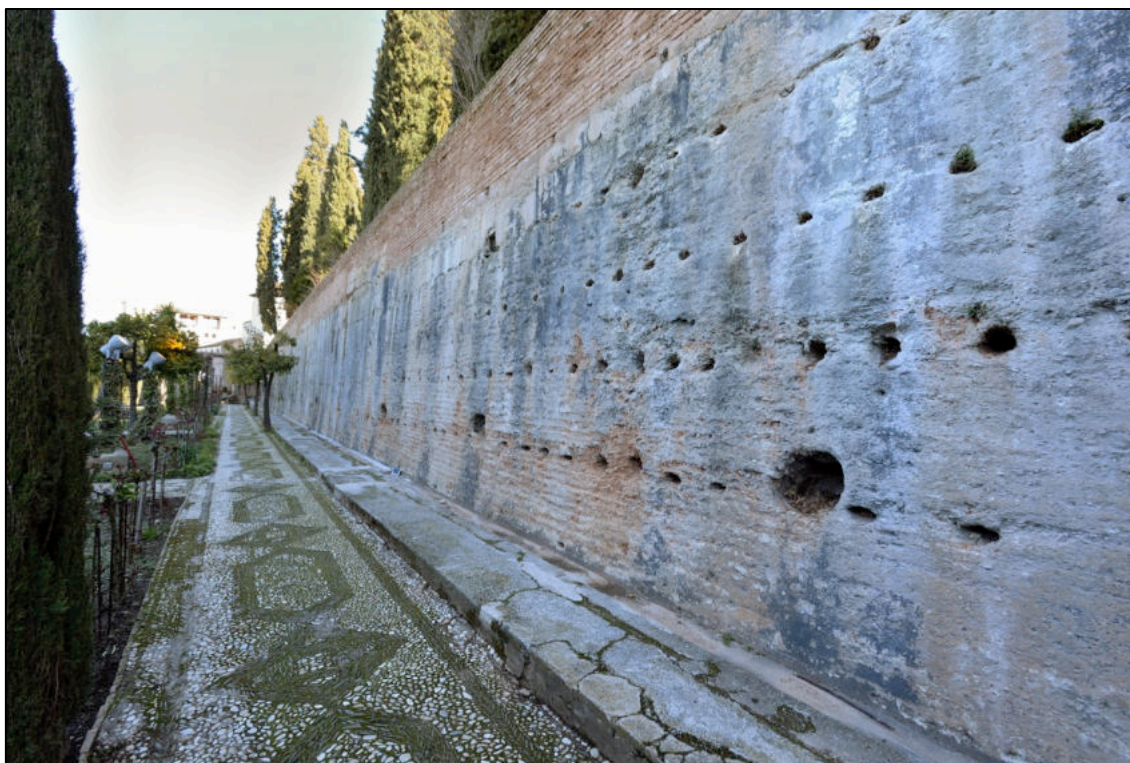
Foto.— Muro que delimita la huerta de la Mercería.
