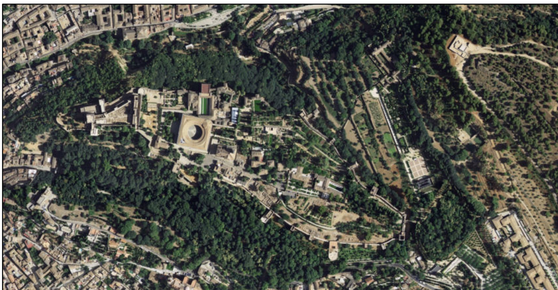
Foto.— Vista general de la Alhambra y el Generalife.
