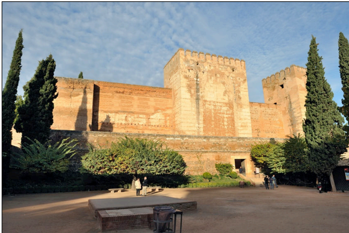
Foto.— Muralla interior este y Torre Quebrada.
