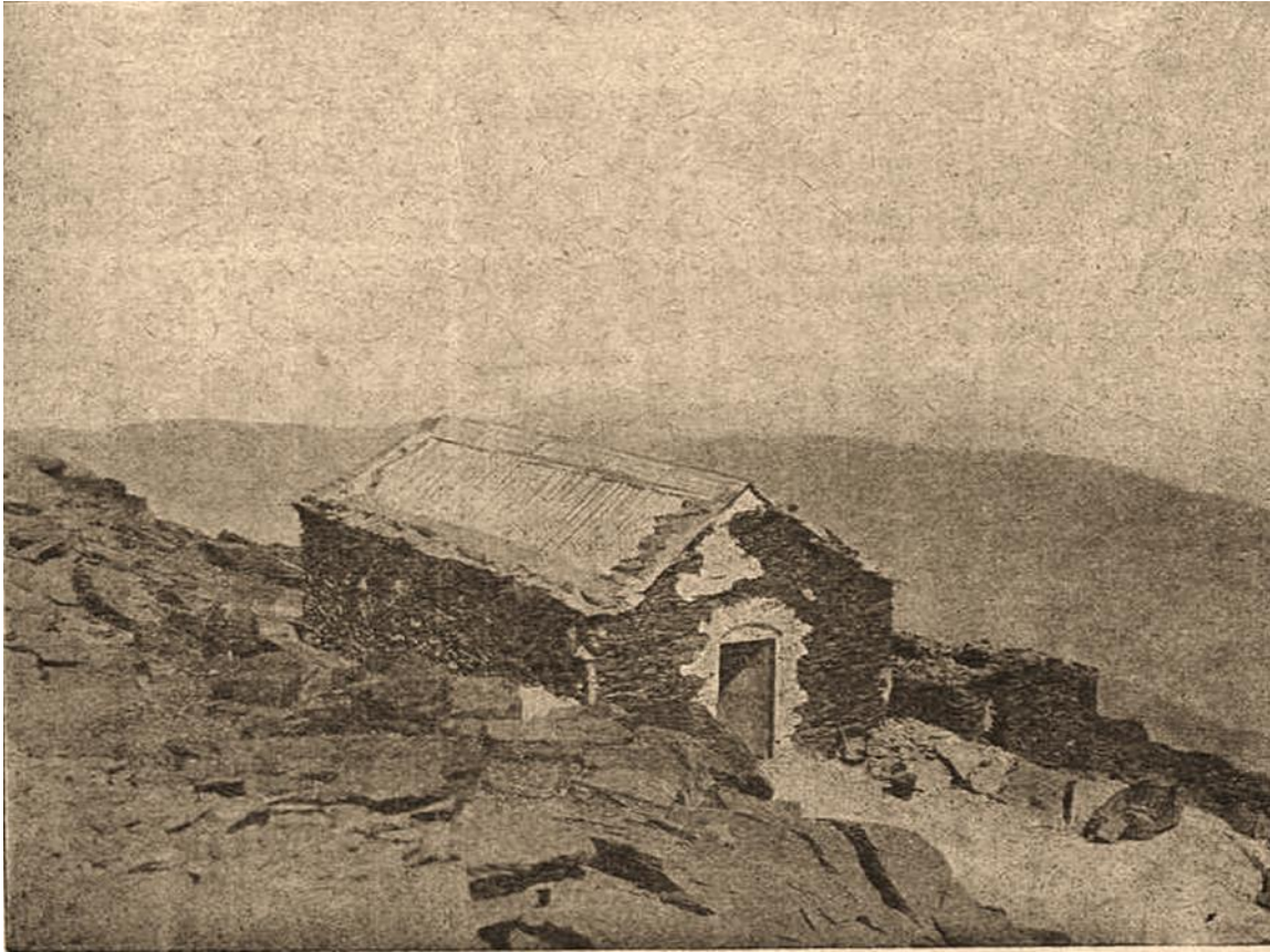
Albergue del vértice Mulhacén, reconstruido en el año 1931; destaca la chapa acanalada colocada en su cubierta. Observaciones Geofísicas en el Cerro de Mulhacén, (1931).
