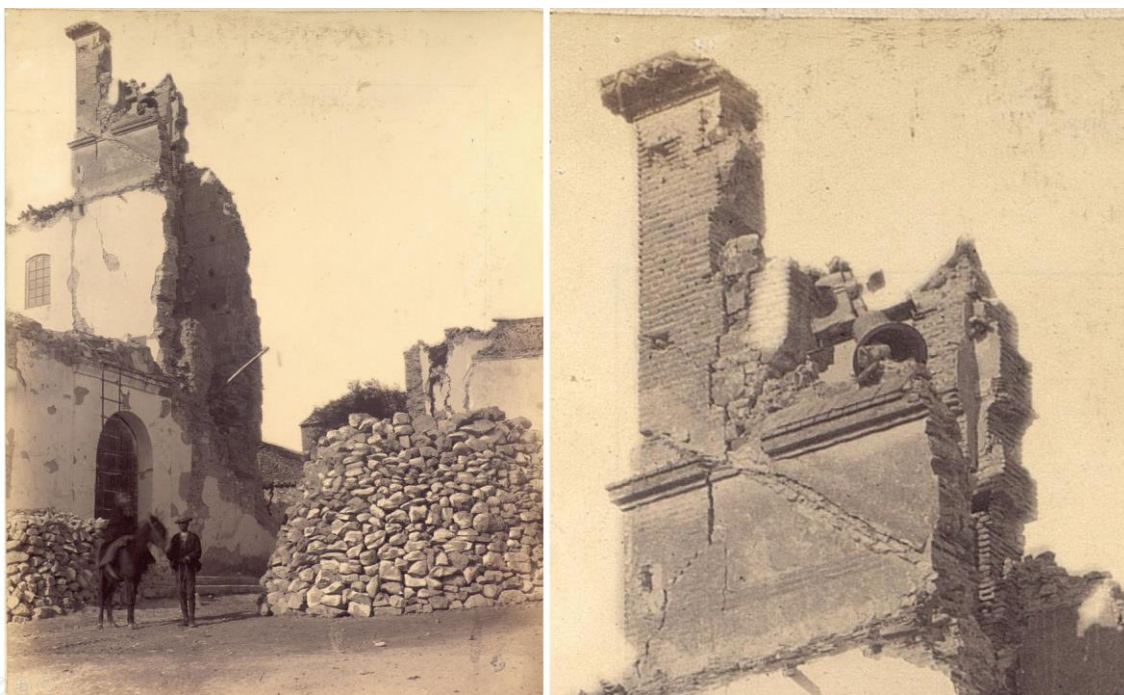
Ruinas de la iglesia de Periana, junto a un detalle de la campana apoyada en los restos del campanario. Fotografía de Etienne- Alfred Esperon y Tisne.
