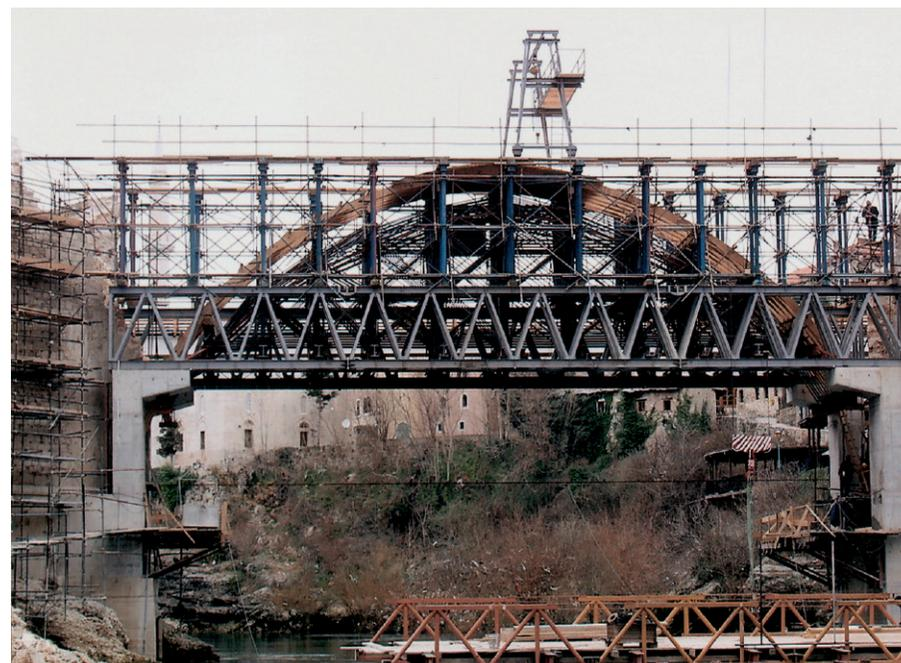
Figura 15. Vista del andamiaje del puente casi acabado (Fuente: Romeo, 2005)
