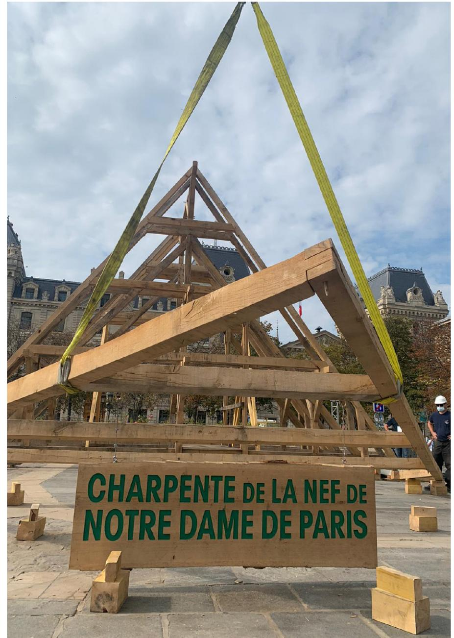
Figura 104. Imagen del nuevo armazón de madera para la cubierta de Notre Dame de París, ejecutado según las técnicas tradicionales (Fuente: <https://www.rebatirnotredamedeparis.fr/>)
