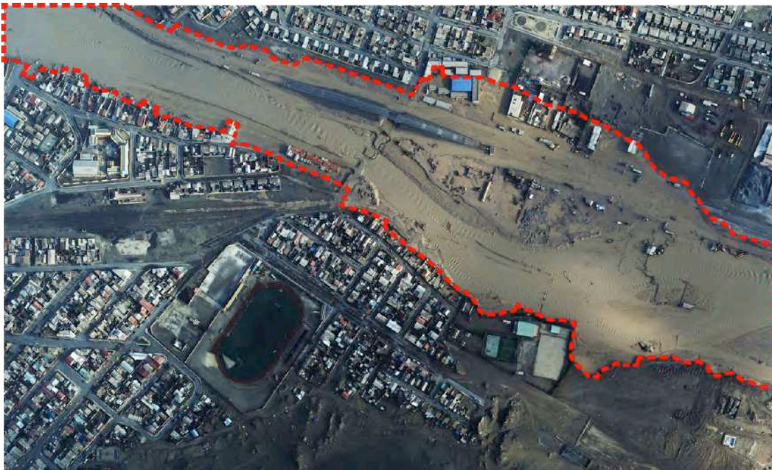
Figura 14. Inundación en acceso oriente de Chañaral.
