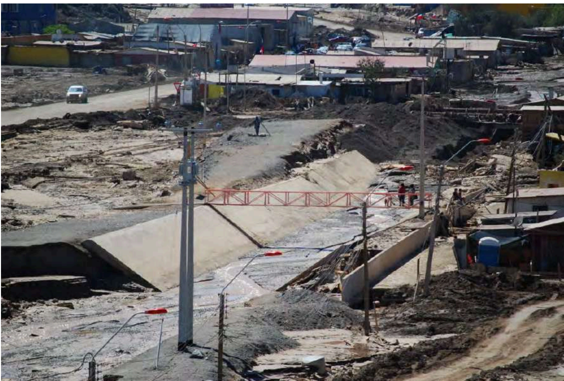
Figura 35. Obra de encauzamiento en la zona urbana de Diego de Almagro. Fuente: Fotografía de Carlos Ovalle.
