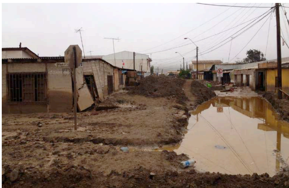
Figura 43. Vista de zonas afectadas en Diego de Almagro, sector al norte del río Salado.
