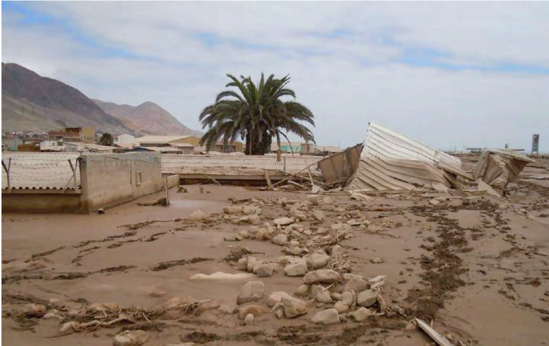
Figura 20. Depósitos de sólidos sobredimensionados.
