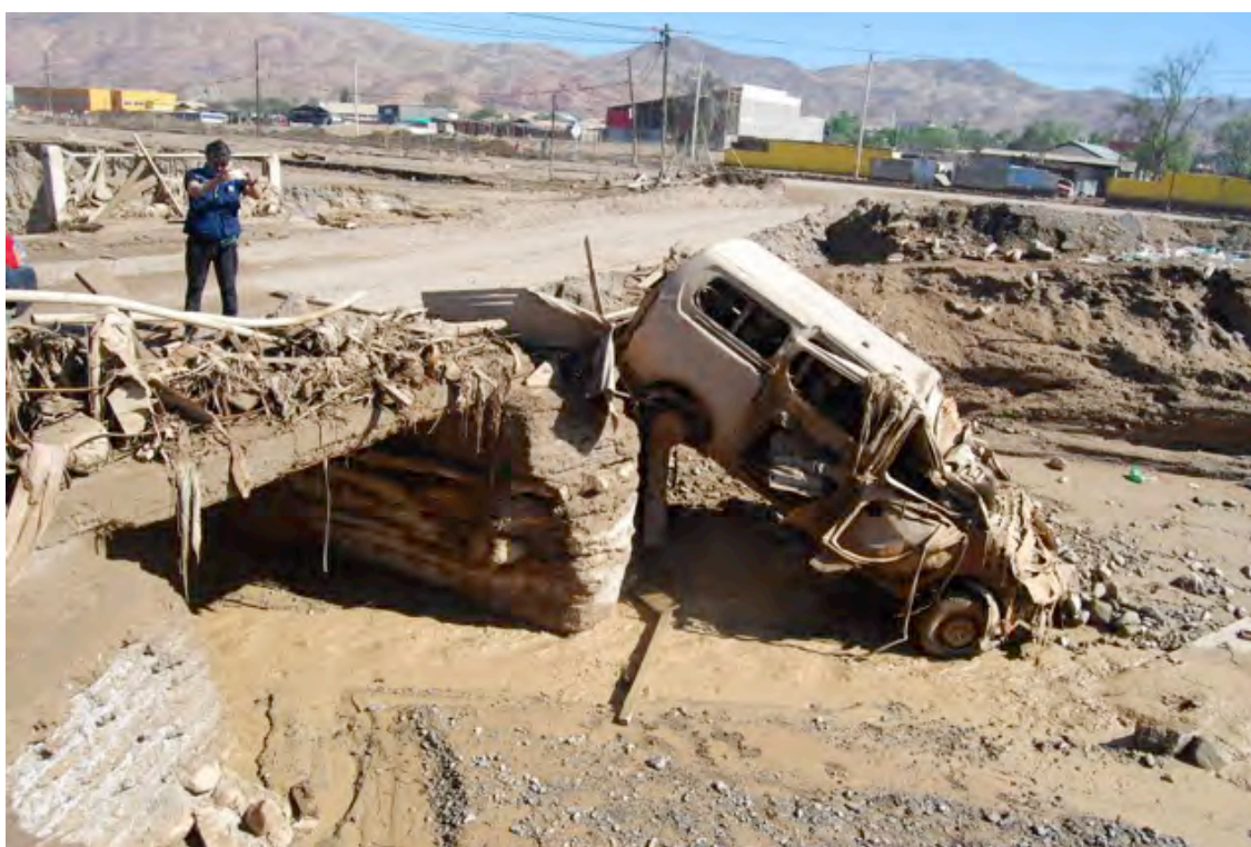
Imágenes 36 y 37. Puente sobre el cauce sobrepasado por el flujo en Diego de Almagro.
