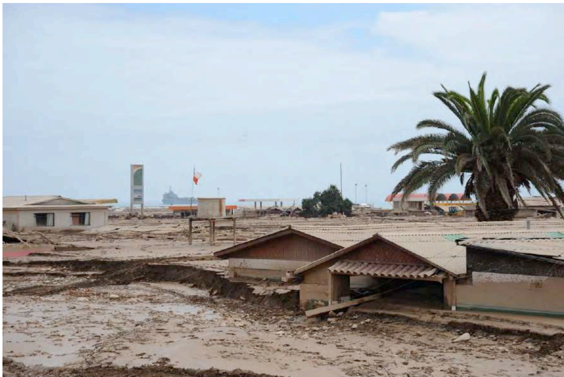
Figura 18. Flujo de aluvional cubriendo casas en la desembocadura del Río Salado.
