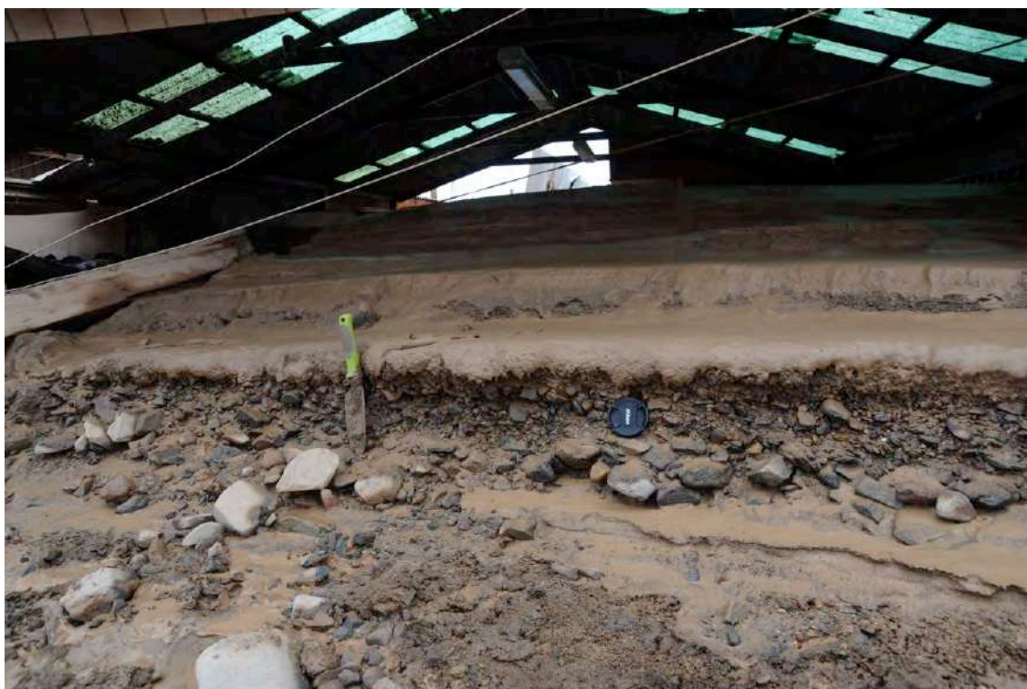
Figura 19. Depósitos de gravas y arenas formando el relleno del interior de una casa habitación.
