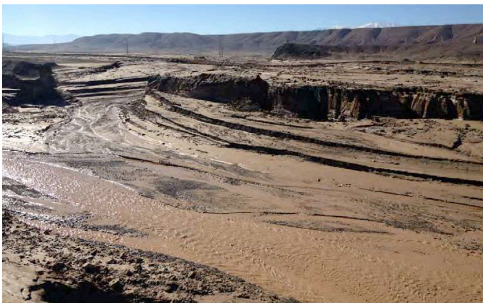
Figura 33. Uno de los brazos principales del cauce, 2 km aguas arriba de Diego de Almagro, en una zona de acopio de relaves que fueron movilizados durante el evento. Fuente: Fotografía de Cristián Escauriaza.
