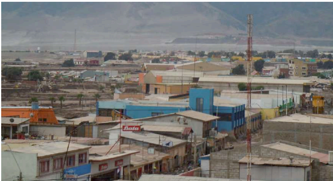
Figura 24. Emplazamiento de municipalidad de Chañaral en zona inundable (edificio azul).
