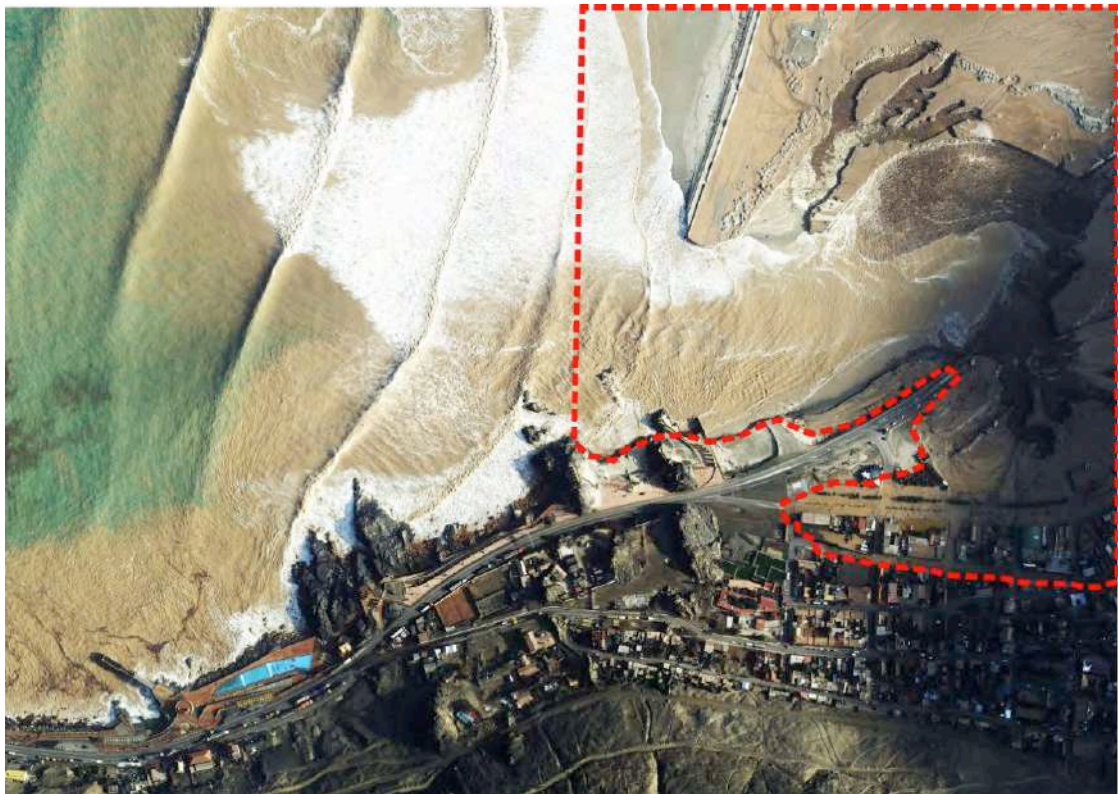
Figura 21. Inundación y socavones en zona centro sur de Chañaral.
