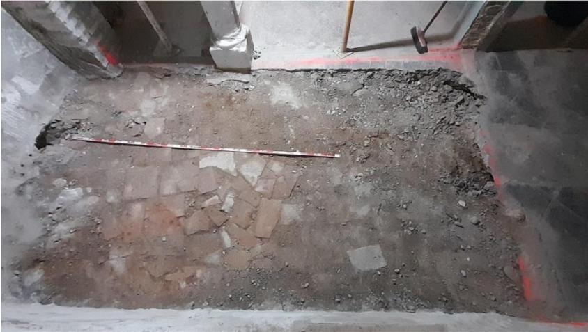
Lam. 5.- Pavimento de fragmentos de ladrillo que sirven de nivelación al suelo de cemento.
