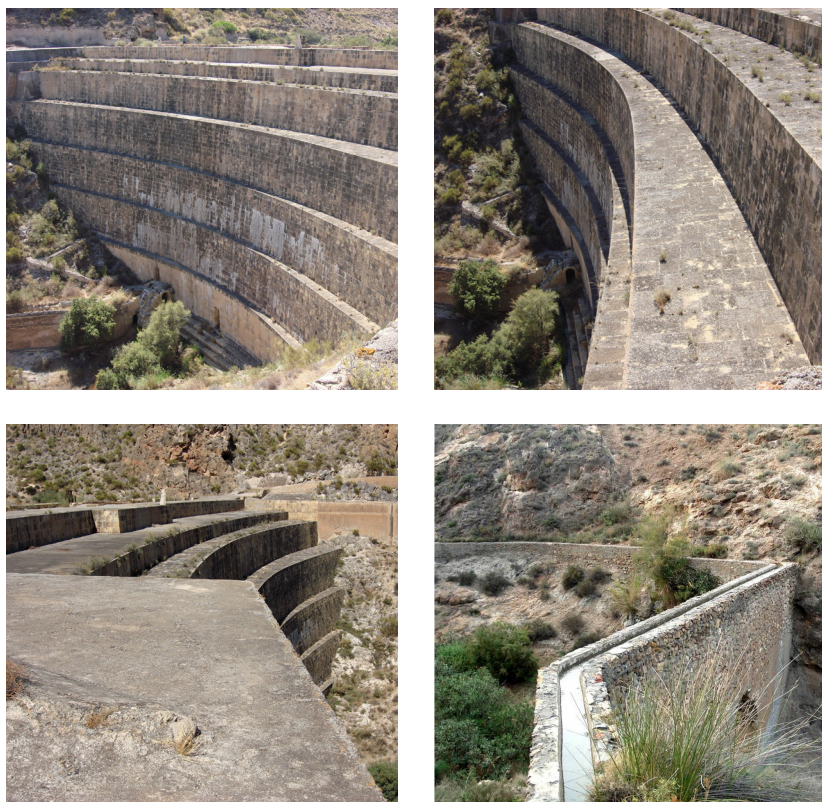
Imagen 17 | Imágenes del muro del pantano de Isabel II de Níjar y de la acequia. Fotos: José Francisco García-Sánchez
