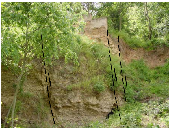
Figura 3: Fallas aflorantes en la ladera N de la Alhambra. Obsérvese como dichas fallas se pueden prolongar hasta roturas de la cerca
