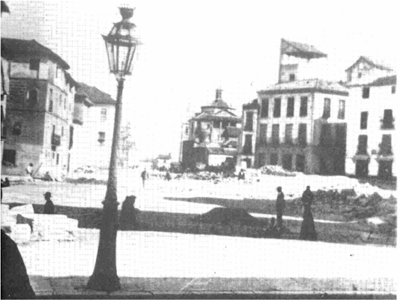
Obras en la calle Zacatín (del archivo de Miguel Jiménez Yanguas).
