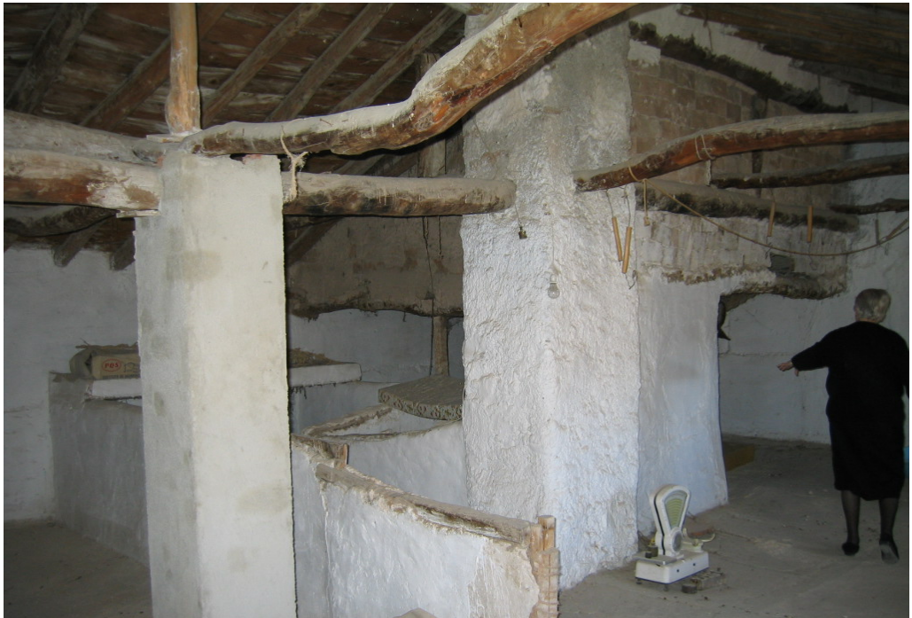
Figura 4: Armaçón de madera de una cubierta. (Fotografía de María del Carmen Vílchez Lara).
