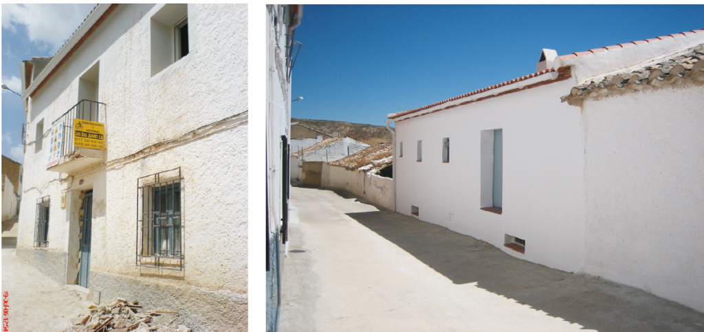
Figura 6: Ejecución de los trabajos y resultados. (Fotografías de María del Carmen Vílchez Lara).
