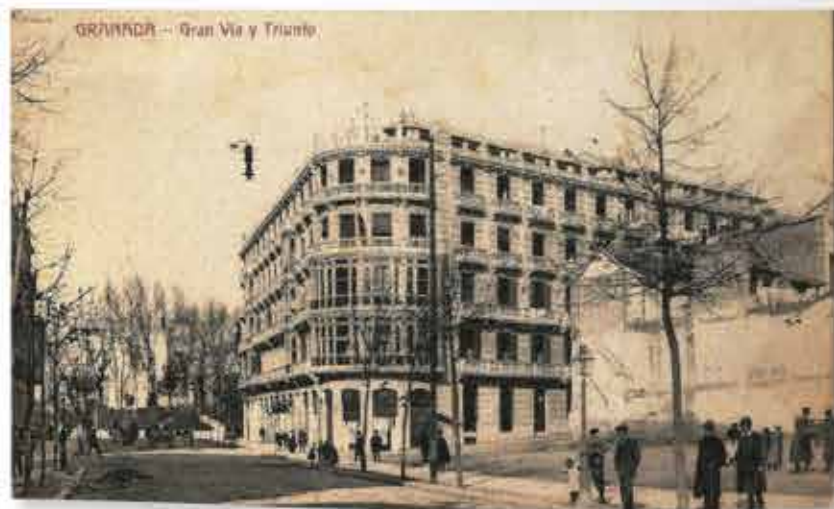
32311. Vista del edificio El Americano en los números 52 y 54 de la Gran Vía. (1912). A su derecha, los solares del 49 al 56 del parcelario original, agrupados por los herederos de Manuel Rodríguez Acosta para la futura construcción de lo que fuera el Palacio Müller, mantiene su perímetro sin vallar. La instantánea pudo tomarse en torno a 1913-1914.
