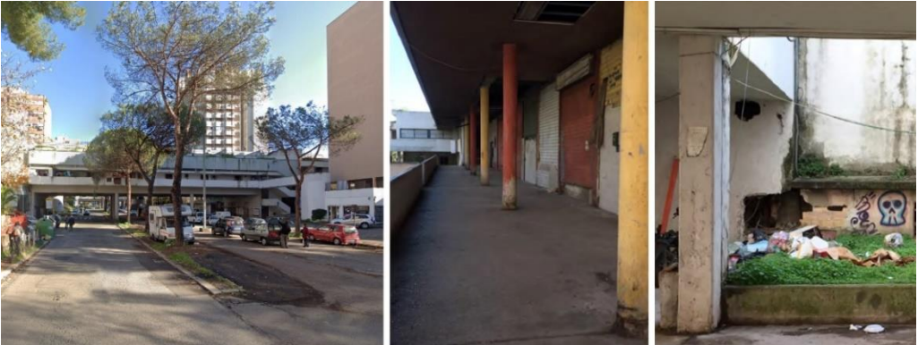
Figura 6: Veronica Strippoli, Patchwork de fotografías del estado de degradación y de abandono de los “Puentes” , 2020. (Raffaele Giannitelli).
