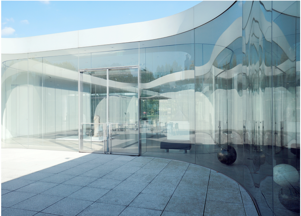
Figura 4: SANAA, Pabellón del Vidrio del Museo de Arte de Toledo en Ohio, EE.UU. (2001-2006); patio ( https://flic.kr/p/fQ3RwE ).
