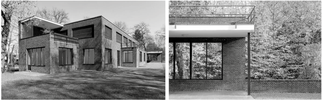
Figura 2: Casa Esters. Porche del comedor y vista exterior de la casa con la terraza superior (Alamy stock photo).
