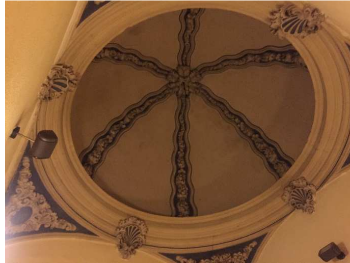
Cúpula del hueco de escalera en segunda planta
