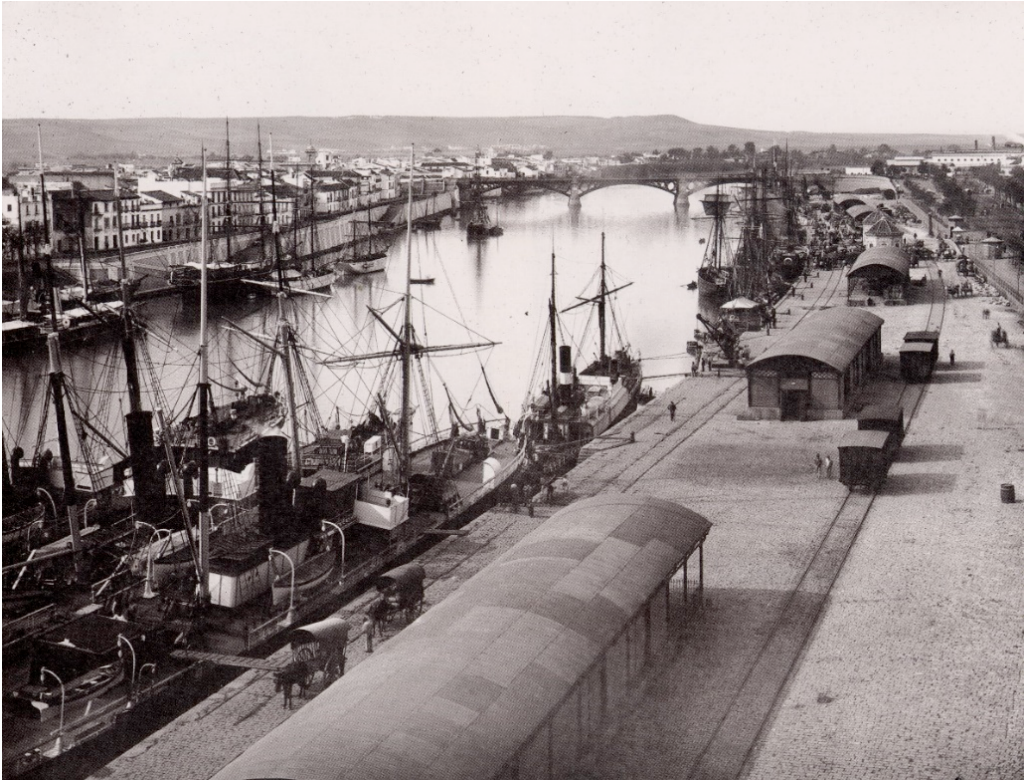
Figura 2. Panorámica de los muelles del Arenal tras la intervención de Pastor y Landero. 1890 ca. (Archivo de la Autoridad Portuaria de Sevilla).
