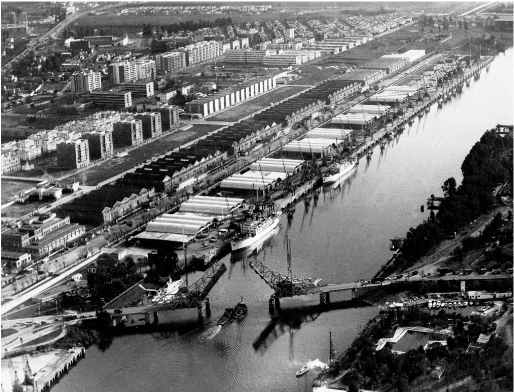
Figura 5: El muelle de Tablada a comienzos de los años setenta; en primer término, el “puente de hierro” (Archivo de la Autoridad Portuaria de Sevilla).
