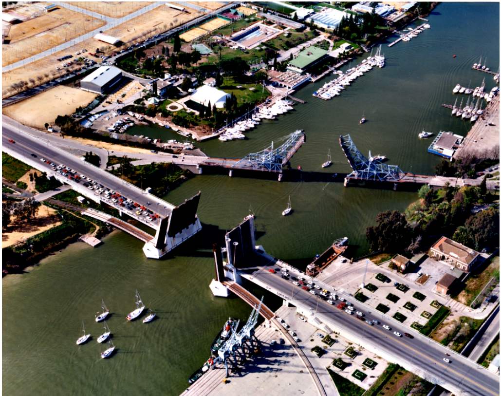
Figura 6: El puente de Delicias y el puente de Alfonso XIII, 1996 (Archivo de la Autoridad Portuaria de Sevilla).
