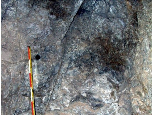
fig. 538.- Agujero del barrenado para la dinamita, posición republicana Cortijo de la Humosa. Fidel Baena.
