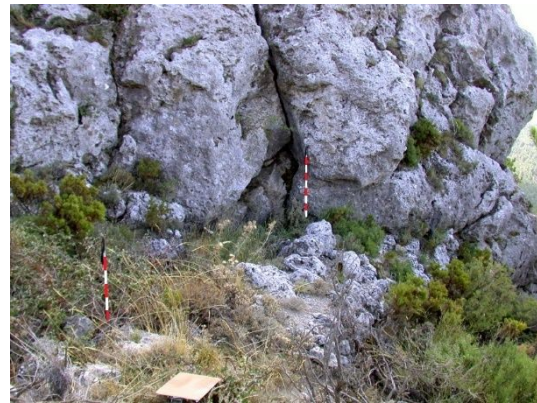
fig. 590.- Restos del muro parapeto de la posición republicana Torre 297. Fidel Baena.
