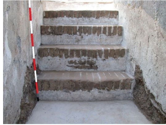
fig. 166.- Escalera interior de uno de los albergues del campamento rebelde “Cuartel de José Antonio”, construidas con un aparejo a sardinel de ladrillos macizos. Fidel Baena.
