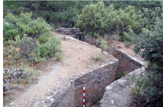
fig. 140.- Trinchera de comunicación construida con un forrado interior de hormigón, posición rebelde "Los Pocicos". Fidel Baena.
