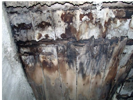
fig. 153.- Restos del encofrado de madera en el techo del albergue contra artillería de la posición rebelde "Alonso" 27. Fidel Baena.
