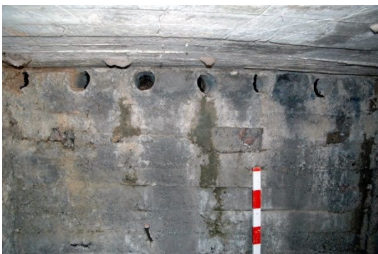
fig. 156.- Impronta del encofrado de madera sobre el hormigón de paredes y techo de la estructura habitacional de la posición rebelde "Derecha del Pino". Fidel Baena.
