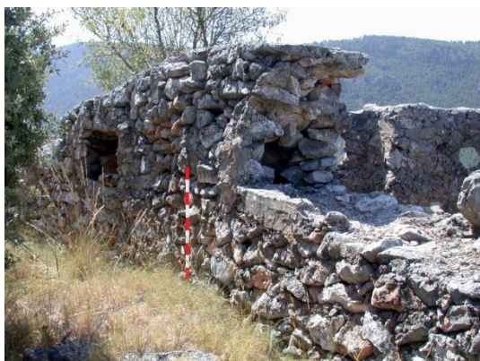
fig. 304.- Muro parapeto Oeste de la posición rebelde "Portichuelo". Fidel Baena.
