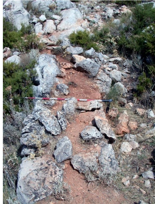
fig. 798.- Muro parapeto de mampostería a dos hojas relleno de tierra, posición republicana Los Asperones. Fidel Baena.
