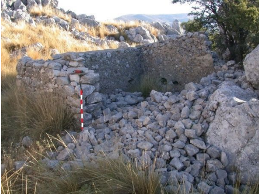
fig. 475.- Estructura habitacional, posición republicana Observatorio del Peñón de la Mata. Fidel Baena.
