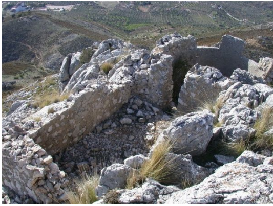
fig. 194.- Puesto de observación con espacio habitacional asociado, posición rebelde “Cruz de Cogollos”.
