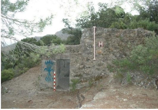
fig. 90.- Albergue contra artillería con un espesor de cubierta (H) superior al metro, en la posición rebelde “Los Pocicos”. Fidel Baena.
