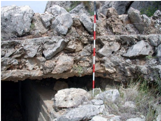
fig. 159.- Cubierta del albergue contra artillería de la posición rebelde “El Pilón”, se observan las dos capas de hormigón y rocas sobre las desaparecidas capas de rollizos. Fidel Baena.
