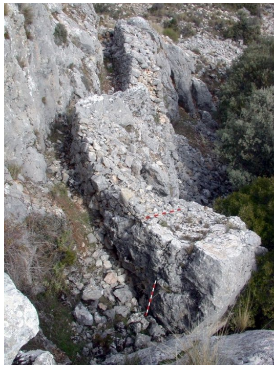
fig. 508.- Muro parapeto Sur de acceso a un puesto de tiro, posición republicana Collado San Agustín. Fidel Baena.
