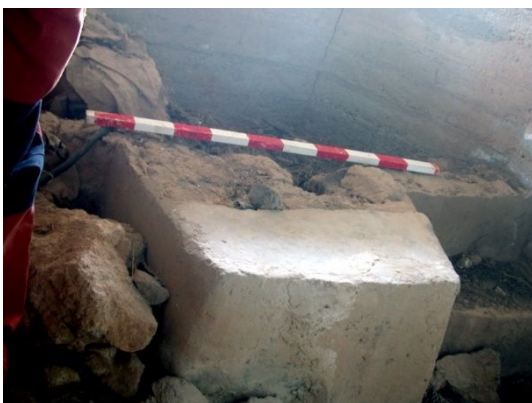
fig. 395.- Bancada de hormigón para el emplazamiento de la ametralladora en el nido de la posición rebelde “Puerto Lobo”. Fidel Baena.
