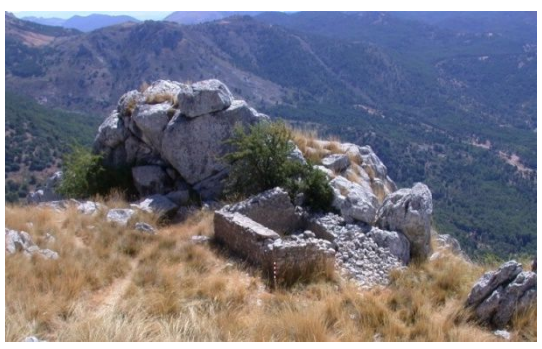
fig.78.- Estructura habitacional de construcción emergente, en la posición republicana Observatorio Peñón de la Mata. Fidel Baena.
