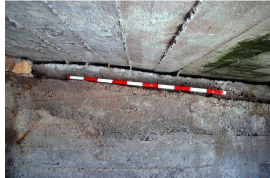
fig. 155.- Impronta del encofrado de madera sobre el hormigón de la cubierta de la estructura habitacional de la posición rebelde "Derecha del Pino". Fidel Baena.
