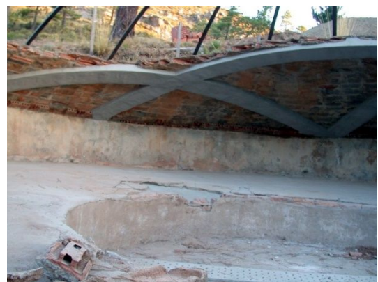
fig. 376.- Refuerzo de la cúpula de uno de los albergues circulares en el campamento rebelde "Cuartel de José Antonio", con la intervención de 2019. Fidel Baena.
