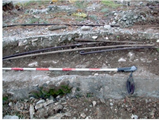
fig. 368.- Armadura de barras de acero liso en el zuncho perimetral de apoyo de la cúpula de los albergues circulares del campamento rebelde “Cuartel de José Antonio”. Fidel Baena.
