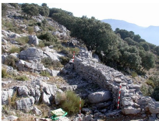
fig. 519.- Muro parapeto Noroeste, posición republicana Cresta 1. Fidel Baena.
