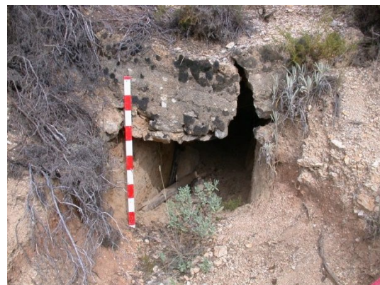
fig. 275.- Acceso Oeste al albergue contra artillería de la posición rebelde "Cerro Pelado". Fidel Baena.
