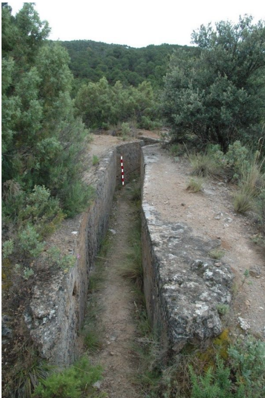
fig. 61.- Trinchera construida con un forrado interior de hormigón, en la posición rebelde "Los Pocicos". Fidel Baena.
