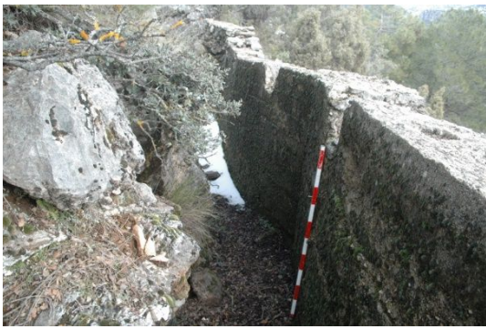
fig. 65.- Muro parapeto almenado, en la posición rebelde “Cueva del Gato”. Fidel Baena.
