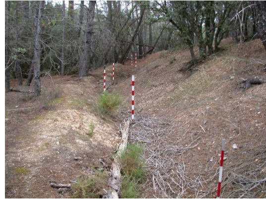
fig. 173.- Restos de un ramal de trinchera excavada en tierra, con el habitual trazado quebrado y el parapeto de tierra hacia la parte más baja del terreno, posición republicana Chorreras 15. Fidel Baena.
