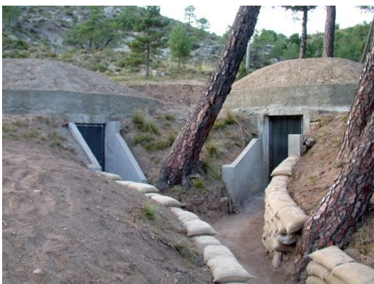
fig. 375.- Vista de dos de los albergues circulares y de su entorno en el campamento rebelde "Cuartel de José Antonio", tras la intervención de 2019. Fidel Baena.
