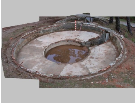
fig. 371.- Albergue circular del campamento rebelde "Cuartel de José Antonio", tras la fase de limpieza en la intervención de 2019. Fidel Baena.
