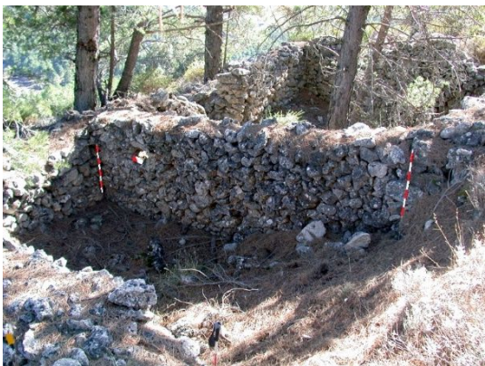
fig. 135.- Muro medianero entre estructuras habitacionales, construido de mampostería en seco, posición republicana “Toriles 2”. Fidel Baena.
