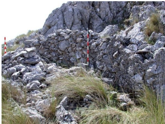
fig. 196.- Muro parapeto Norte de la posición rebelde "El Pilon". Fidel Baena.
