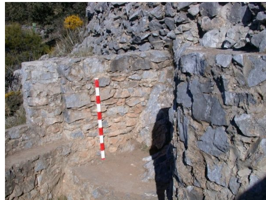
fig. 128.- Muro de un puesto de tiro, construido de mampostería con mortero de cemento, posición rebelde Maullo "T1". Fidel Baena.
