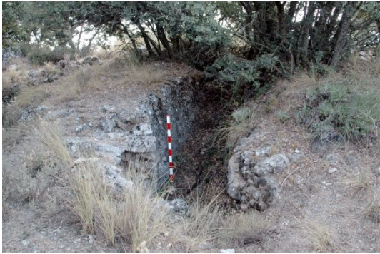
fig. 238.- Trincherá forrada de mampostería en la posición rebelde "Garay". Fidel Baena.
