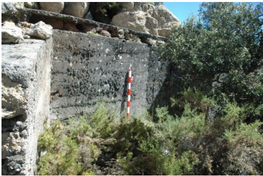
fig. 251.- Interior de la estructura habitacional de la posición rebelde “Avanzadilla de Garay”. Fidel Baena.
