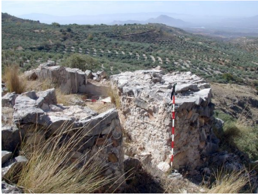
fig. 129.- Nido de ametralladora, construido con muros de mampostería y mortero de cal, posición Cerro de la Hoz. Fidel Baena.
