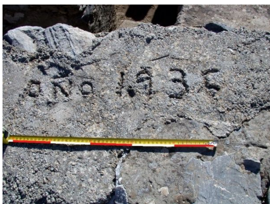
fig. 396.- Falso histórico grabado sobre el mortero de cemento de una restauración de la posición rebelde Maullo “T1”. Fidel Baena.
