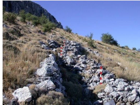
fig. 470.- Trinchera Noreste con muro sobre el parapeto y en el espaldar, posición republicana Flanco Norte del Peñón de la Mata. Fidel Baena.
