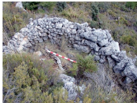
fig. 280.- Muro parapeto Norte de la posición rebelde "Cerro del Pino". Fidel Baena.
