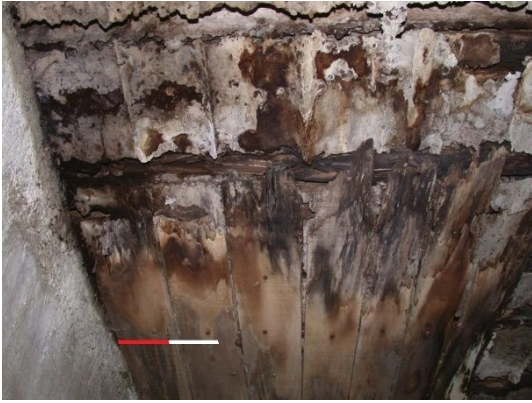
fig. 336.- Restos del encofrado de madera en el techo del albergue contra artillería, posición "Alonso" 27. Fidel Baena.
