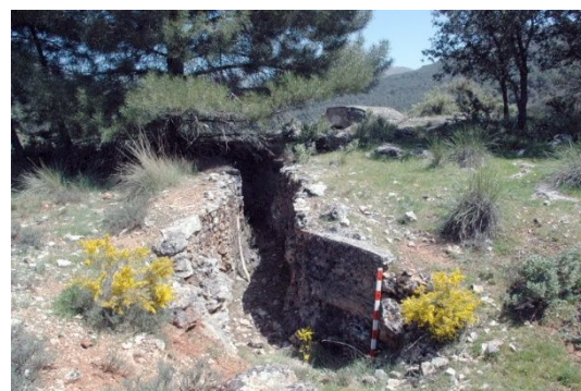
fig. 287.- Trinchera con revestimiento interior, posición rebelde “Derecha del Pino”. Fidel Baena.
