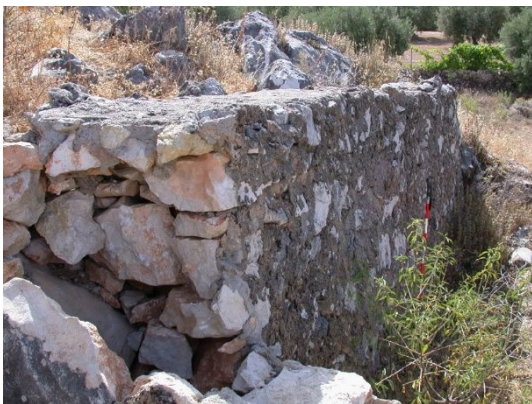
fig. 131.- Muro de una estructura habitacional, construido de mampostería en seco y rejuntado con mortero de cemento, posición rebelde “Cogollos”. Fidel Baena
