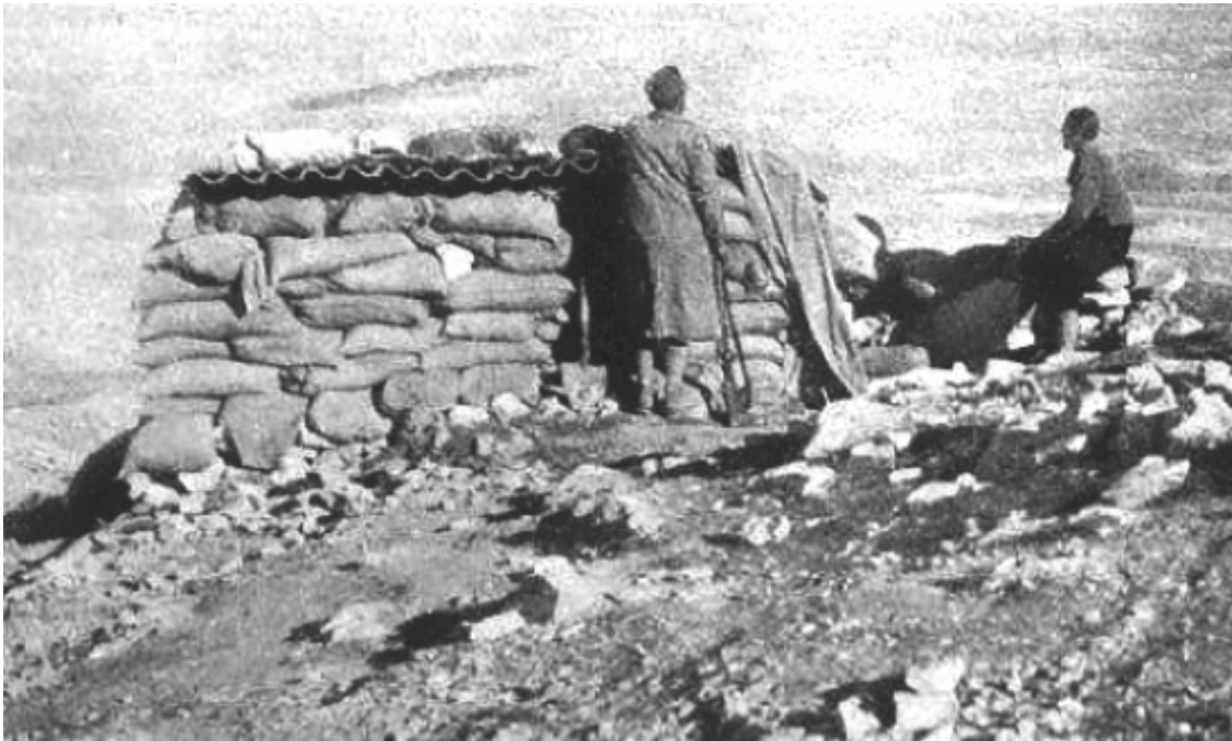
fig. 149.- Estructura habitacional construida con sacos terreros y cubierta con chapa ondulada de fibrocemento (Arévalo, 2005, p. 216).
