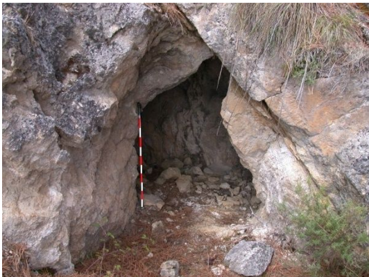
fig. 536.- Albergue contra artillería excavado en galería aprovechando un abrigo natural, posición republicana Cortijo de la Humosa. Fidel Baena.
