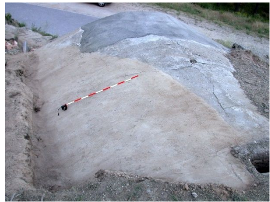
fig. 374.- Trasdós de la bóveda del albergue de mando del campamento rebelde "Cuartel de José Antonio", durante la intervención de 2019. Fidel Baena.
