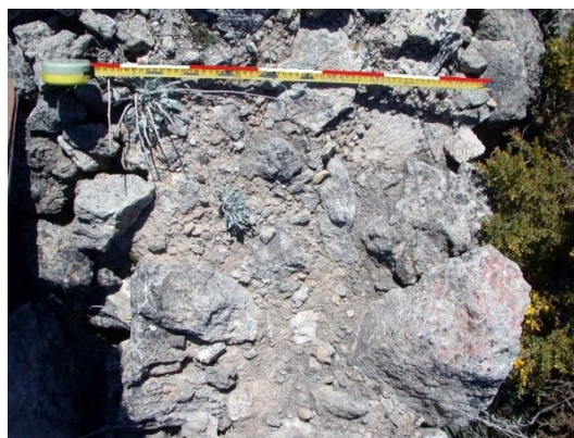
fig. 562.- Detalle del muro de mampostería con mortero de tierra, yacimiento republicano Campamento del Tambor. Fidel Baena.
