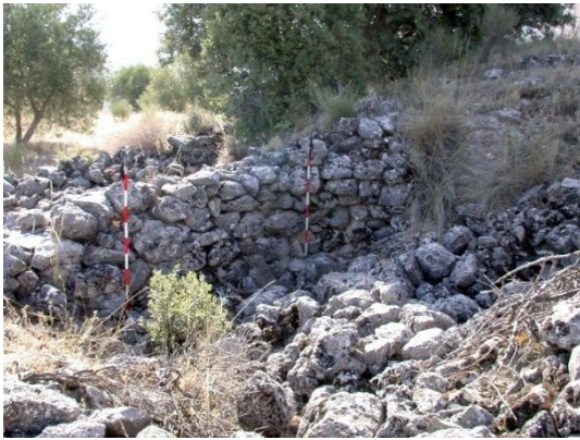
fig. 125.- Muro de mampostería en seco de una estructura habitacional, posición republicana Canteras 3. Fidel Baena.
