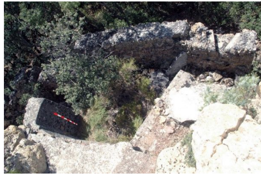
fig. 250.- Estructura habitacional con la cubierta desaparecida, posición rebelde “Avanzadilla de Garay”. Fidel Baena.
