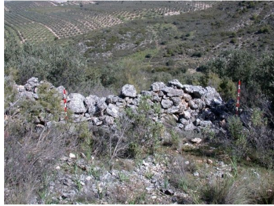
fig. 436.- Restos del muro parapeto Norte de la posición republicana "Atalaya de Deifontes" I. Fidel Baena.
