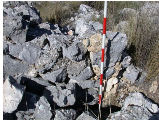
fig. 193.- Restos de muro de mampostería en seco rejuntada de mortero de cemento en la posición rebelde "Cruz de Cogollos". Fidel Baena.
