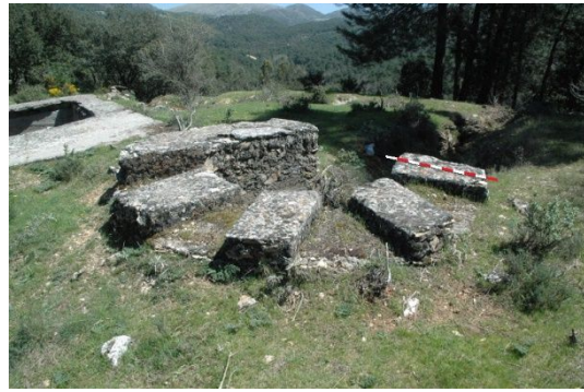
fig. 289.- Puesto de tiro soterrado con merlones sobre el parapeto, posición rebelde “Derecha del Pino”. Fidel Baena.
