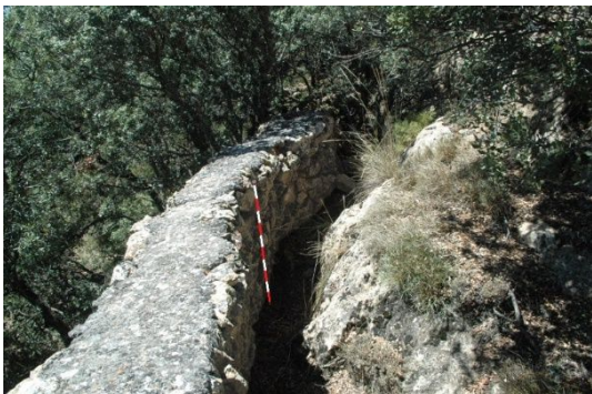
fig. 247.- Muro parapeto de la posición rebelde "Avanzadilla de Garay". Fidel Baena.
