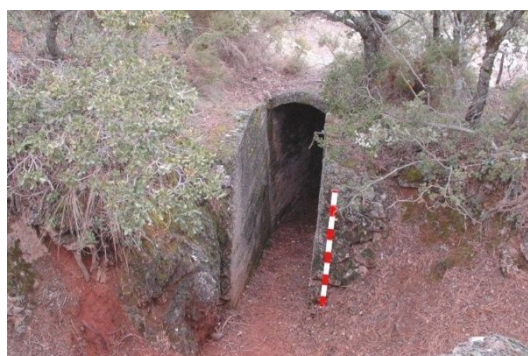
fig. 168.- Trinchera de comunicación cubierta con bóveda de hormigón, posición rebelde “Alonso” 26. Fidel Baena.
