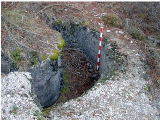
fig. 141.- Puesto de tiro de media luna o "corchete", construido con un forrado interior de hormigón, posición rebelde "Alonso" 27. Fidel Baena.
