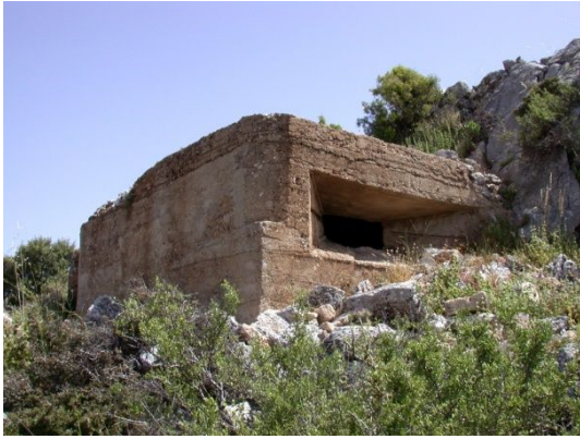
fig. 145.- Nido de ametralladora, construido con hormigón de cal y cemento portland, posición Atalaya 4. Fidel Baena.
