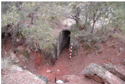
fig. 64.- Trinchera cubierta con bóveda de hormigón formando una galería, en la posición rebelde "Alonso" ANG/R026. Fidel Baena.
