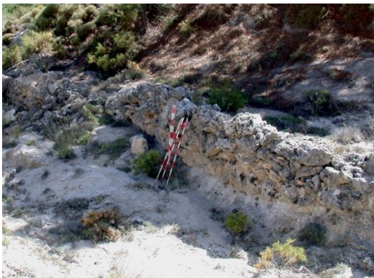
fig. 127.- Muro parapeto de mampostería con mortero de tierra, posición republicana Cortijo de la Humosa. Fidel Baena.
