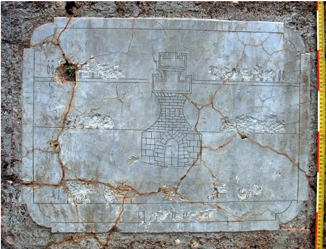
fig. 200.- Placa de cemento Portland realizada in situ sobre la fachada del albergue contra artillería de la posición rebelde "El Pílon". Fidel Baena.
