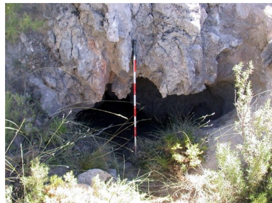
fig. 610.- Albergue contra artillería Norte, acceso Norte, posición republicana Avanzada de las Minas. Fidel Baena.
