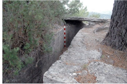
fig. 234.- Restos de la cubierta sobre un ramal de trinchera de la posición rebelde “Los Pocicos”. Fidel Baena.
