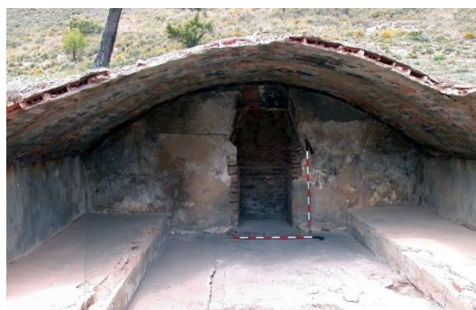
fig. 366.- Albergue de mando del campamento rebelde "Cuartel de José Antonio", durante la fase de limpieza en la intervención de 2019. Fidel Baena.
