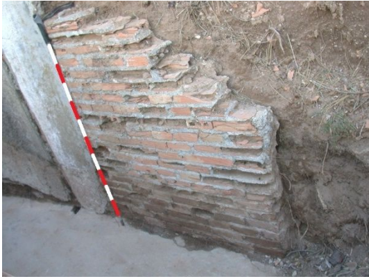
fig. 165.- Muro de contención a la entrada de uno de los albergues del campamento rebelde “Cuartel de José Antonio”, construido aparejado a medio pie con los ladrillos de hueco sencillo que sobraron de la construcción de las cúpulas. Fidel Baena.
