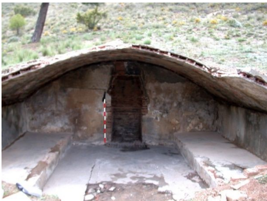
fig. 163.- Bóveda del albergue del mando del campamento rebelde “Cuartel de José Antonio”, construida tabicada con doble hoja de ladrillo de hueco sencillo. Fidel Baena.
