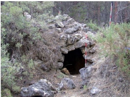
fig. 642.- Albergue contra artillería construido soterrado, posición republicana El Caldero. Fidel Baena.
