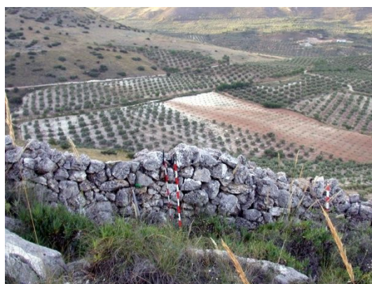
fig. 445.- Muros parapeto de comunicación, posición republicana Atalaya 2. Fidel Baena.
