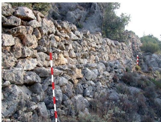
fig. 819.- Exterior del muro parapeto de la posición republicana Chorreras 12. Fidel Baena.
