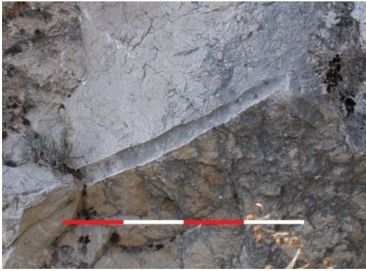
fig. 172.- Huella del barrenado para la construcción del atrincheramiento mediante el dinamitado de la roca, posición republicana Collado de San Agustín. Fidel Baena.
