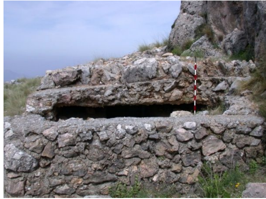
fig. 91.- Albergue contra artillería con la cubierta construida mediante dos primeras capas de rollizos de madera, en la posición rebelde “El Pílon”. Fidel Baena.
