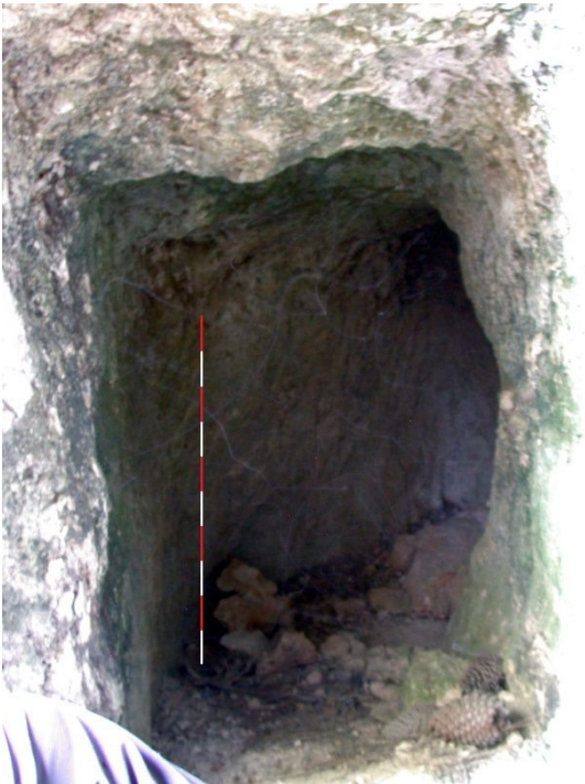
fig. 623.- Albergue contra artillería excavado en galería, posición republicana Derecha de las Colmenas. Fidel Baena.
