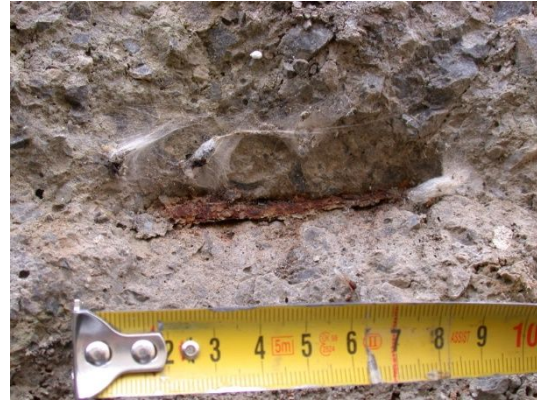
fig. 144.- Armadura del muro divisorio de la estructura habitacional de la posición rebelde "Alonso" 27. Fidel Baena.
