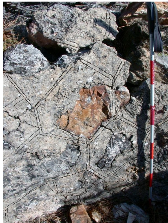
fig. 132.- Muro de un puesto de tiro, construido de mampostería en seco y rejuntado con mortero de cemento con motivo decorativo simulando un despiece poligonal, posición rebelde Fuente de Güevéjar. Fidel Baena.
