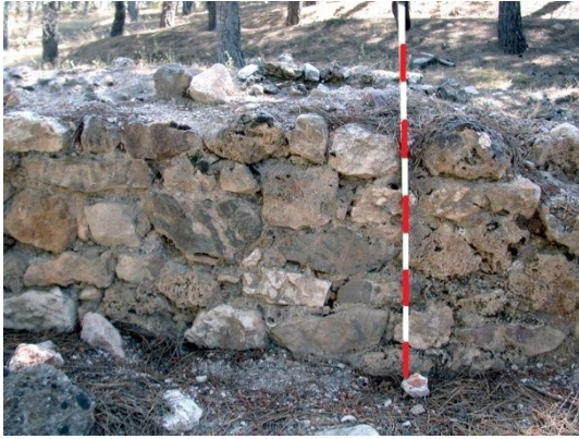
fig. 839.- Muro del horno de pan del cortijo Nuevo (2020). Fidel Baena.
