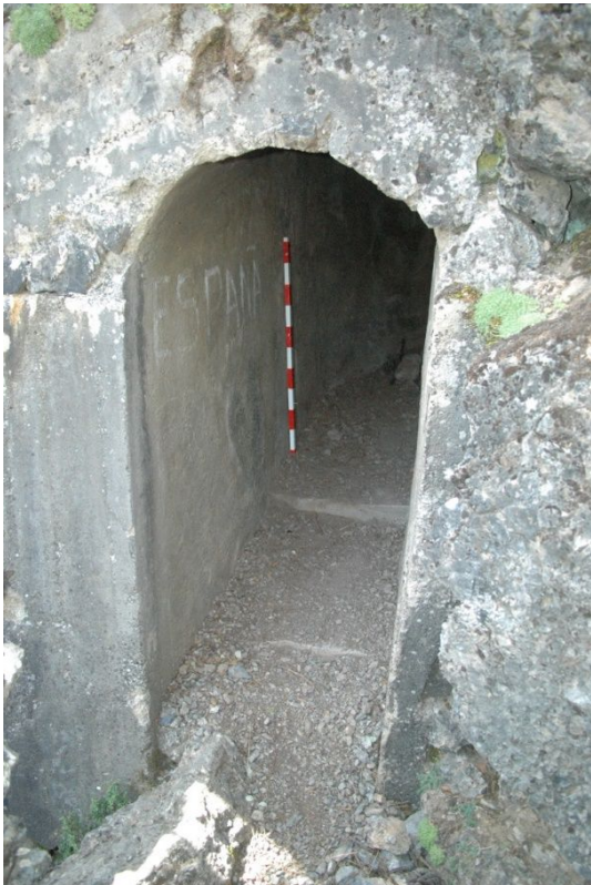
fig. 94.- Acceso al albergue contra artillería en la posición rebelde “Cerro del Cura”. Fidel Baena.
