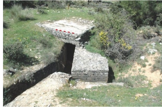
fig. 175.- Estructura habitacional soterrada de la posición rebelde “Derecha del Pino”. Fidel Baena.
