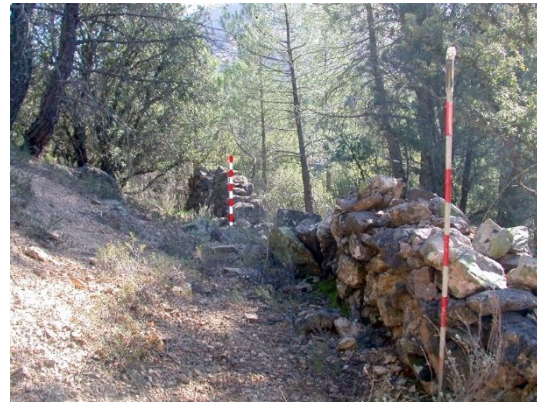
fig. 829.- Muro parapeto de la posición republicana Chorreras 14. Fidel Baena.
