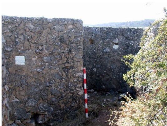
fig. 124.- Muro parapeto de mampostería rejuntada con mortero de cemento, posición rebelde “Portichuelo”. Fidel Baena.
