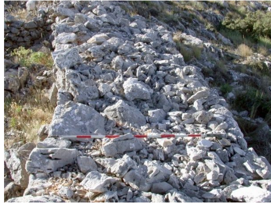
fig. 707.- Muro parapeto, posición republicana “Cerro de los Conejos”. Fidel Baena.
