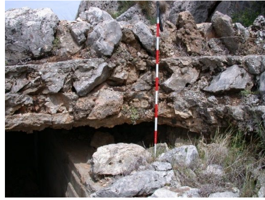
fig. 199.- Sección de la cubierta del albergue contra artillería de la posición rebelde "El Pílon". Fidel Baena.
