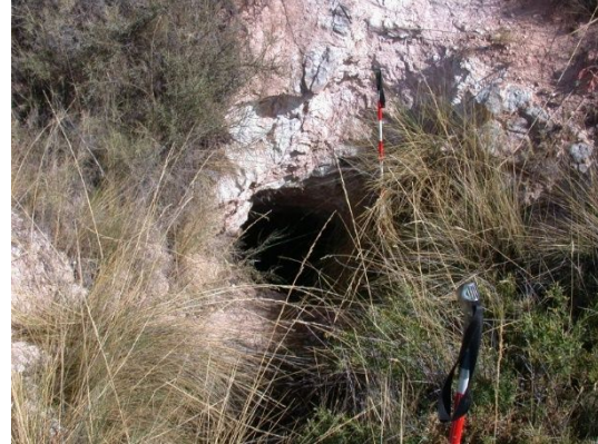
fig. 456.- Albergue contra artillería excavado en galería, posición republicana Camino de Deifontes. Fidel Baena.
