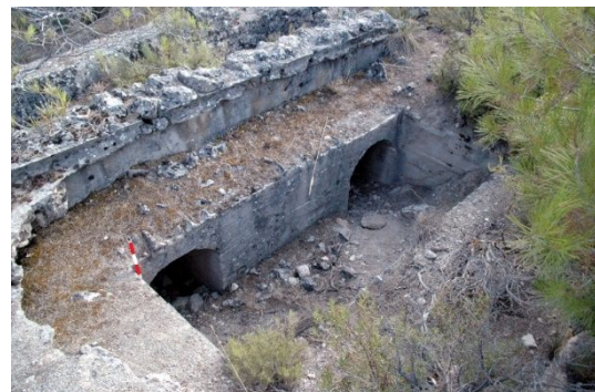
fig. 142.- Albergue contra artillería, construido con muros de hormigón y rocas, posición rebelde "Los Toriles". Fidel Baena.
