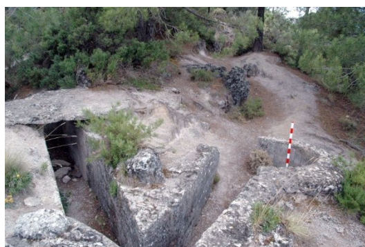
fig. 170.- Restos de la cubierta de hormigón sobre uno de los ramales de trinchera de la posición rebelde “Los Pocicos”. Fidel Baena.
