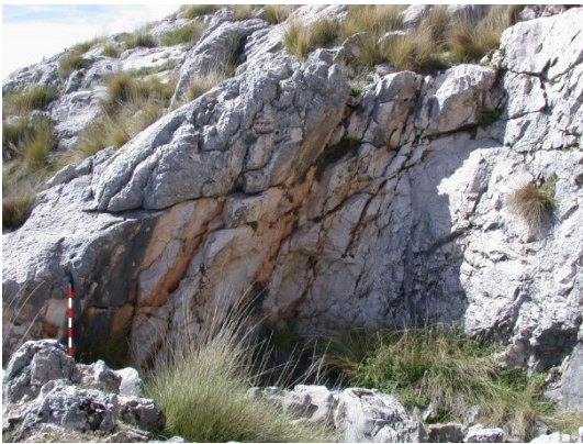
fig. 192.- Desmonte del terreno rocoso para la construcción del albergue contra artillería de la posición rebelde "Cruz de Cogollos". Fidel Baena.
