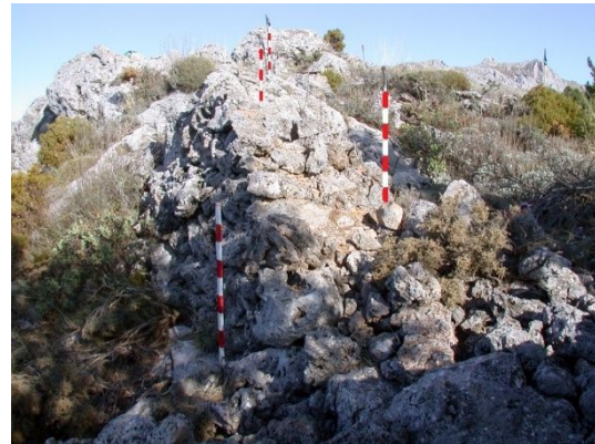
fig. 674.- Muro parapeto Noroeste, posición republicana El Reducto. Fidel Baena.
