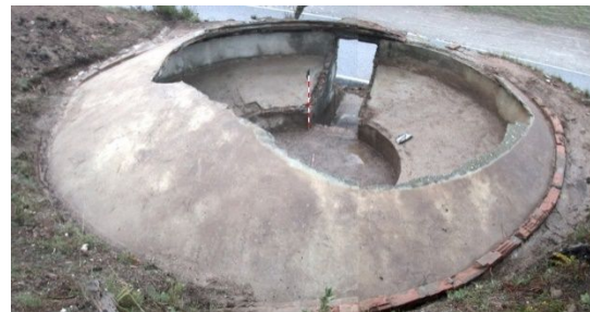
fig. 162.- Cúpula de uno de los albergues del campamento rebelde “Cuartel de José Antonio”, construida tabicada con doble hoja de ladrillo de hueco sencillo. Fidel Baena.
