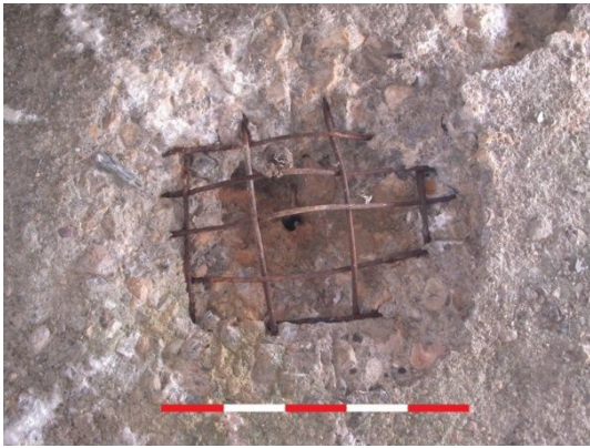
fig. 154.- Techo del nido de ametralladora de la posición rebelde "Puerto Lobo", donde se puede observar la armadura tejida de acero liso de 10 mm de diámetro. Fidel Baena.
