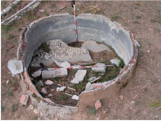
fig. 97.- Depósito de agua construido con rasilla zunchada, en el campamento rebelde "Cuartel de José Antonio". Fidel Baena.
