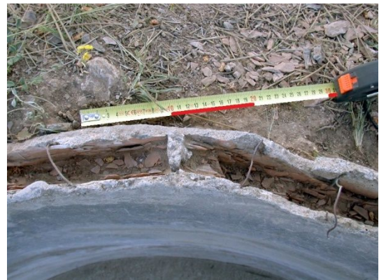
fig. 164.- Depósito de agua del campamento rebelde “Cuartel de José Antonio”, detalle constructivo de las paredes del depósito aparejadas con ladrillo de hueco sencillo a panderete zunchado con alambre. Fidel Baena.
