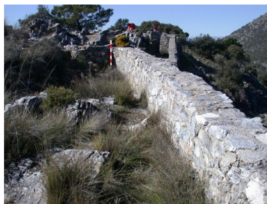
fig. 397.- Muro parapeto restaurado en la posición rebelde Maullo “T1”. Fidel Baena.
