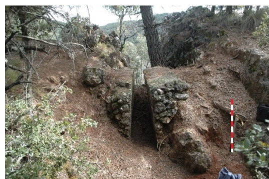
fig. 331.- Trinchera de acceso a la posición rebelde “Alonso” 26, con el forrado interior volcado por empuje del terreno. Fidel Baena.
