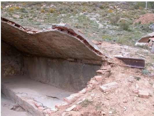
fig. 369.- Rail de ferrocarril como apoyo de la cúpula del albergue de mando del campamento rebelde “Cuartel de José Antonio”, durante la fase de limpieza en la intervención de 2019. Fidel Baena.
