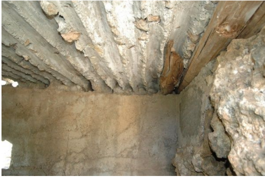
fig. 157.- Restos de la capa de rollizos que soportaban la cubierta del nido de ametralladora de la posición rebelde “Derecha del Pino”. Fidel Baena.
