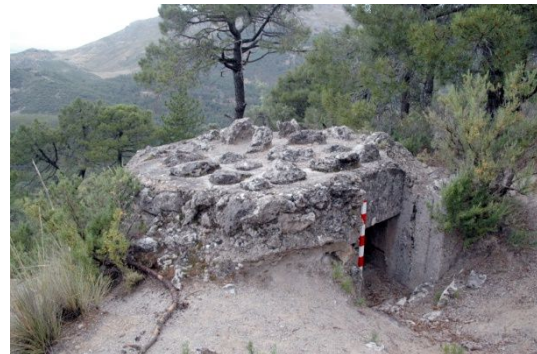
fig. 160.- Cubierta del nido de ametralladora de la posición rebelde “Los Pocicos”, con rocas incrustadas en el hormigón como método de camuflaje. Fidel Baena.
