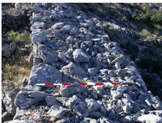
fig. 122.- Muro parapeto de mampostería en seco, posición republicana Cerro de los Conejos. Fidel Baena.
