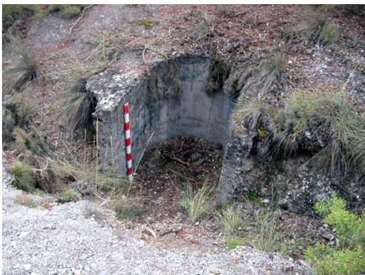
fig. 334.- Puesto individual de tiro, a caponera, posición rebelde "Alonso" 27. Fidel Baena.
