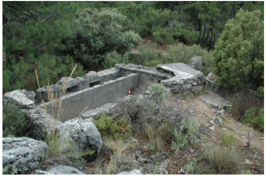
fig. 79.- Estructura mixta de uso habitacional y de combate, de construcción emergente, en la posición rebelde “Los Pocicos”. Fidel Baena.
