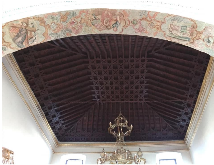
Fig. 174. Charpente carrée à entrelacs de la chapelle de l'église Santo Domingo à Potosí (1625). Photo : Javier Colmenares, 2021.
