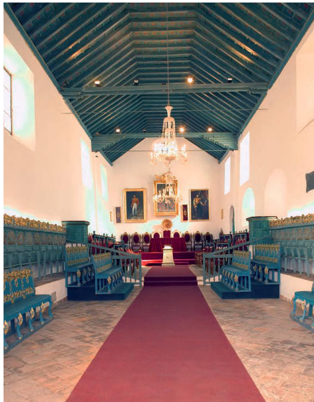
Fig. 157. Charpente par-nudillo de la salle d'actes de la Casa de la Libertad (Début du XVII e siècle). María Dolores Gil et José Rodríguez, éd., Sucre : Bolivia, Chuquisaca. Guía de arquitectura y paisaje (Sevilla, Sucre : Dirección General de Rehabilitación y Arquitectura Concejo Municipal de Sucre, 2012), 105.
