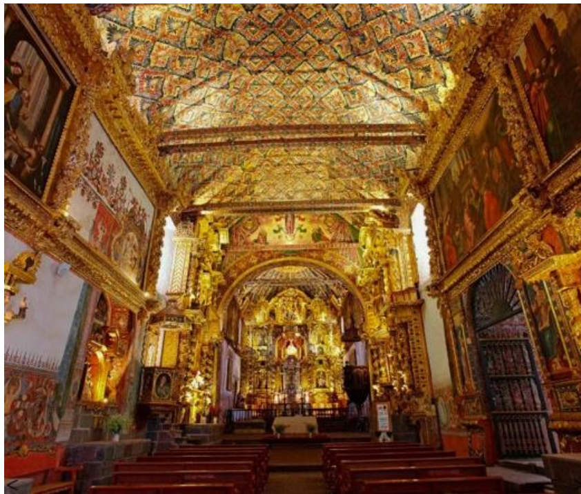
Fig. 137. Charpente par-nudillo de l'église San Pedro à Andahuaylillas (Fin XVI e siècle). Notez l'arc triomphal séparant les charpentes sur le chœur et la nef. Photo : Bernhard Huber, 2017, CC BY-NC-ND-2.0, https://flic.kr/p/RuTujz .
