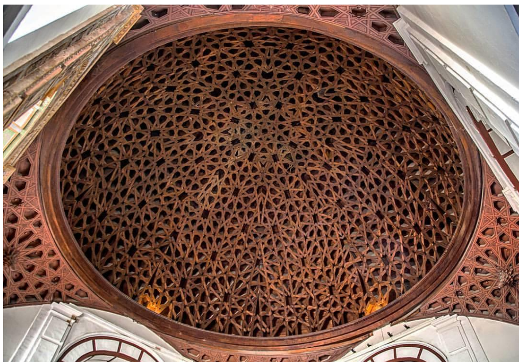
Fig. 33. Coupole en bois sur l'escalier du couvent San Francisco à Lima au Pérou (1625 ; Reconstruction en 1725 et 1973). Photo : Juan Pablo El Sous, 2019.
