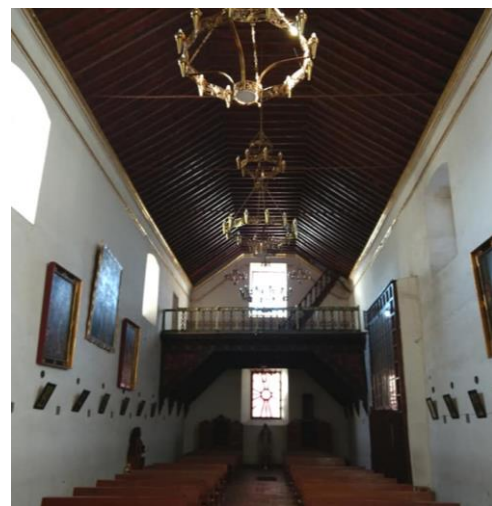
Fig. 175. Charpentes lisses, sans entrelacs, d'une chapelle (à gauche) et de la nef de l'église Santo Domingo à Potosí (ca. 1625). Photo : Javier Colmenares, 2021.
