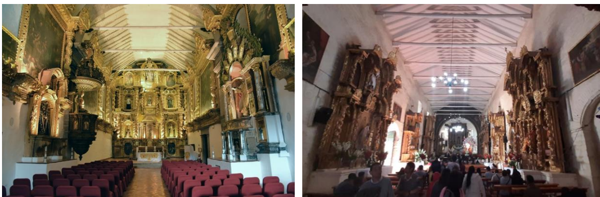
Fig. 136. Charpentes par-nudillo restaurées : San Antonio Abad en 1965 (à gauche) et San Jerónimo en 2014 (à droite). Photos : Harvey Barrison, 2018, CC BY-NC-SA 2.0 https://flic.kr/p/26vvVJ7 ; Señor Cuatavo de Ayabaca, Facebook, 2019, https://cutt.ly/nJ614Aj .
