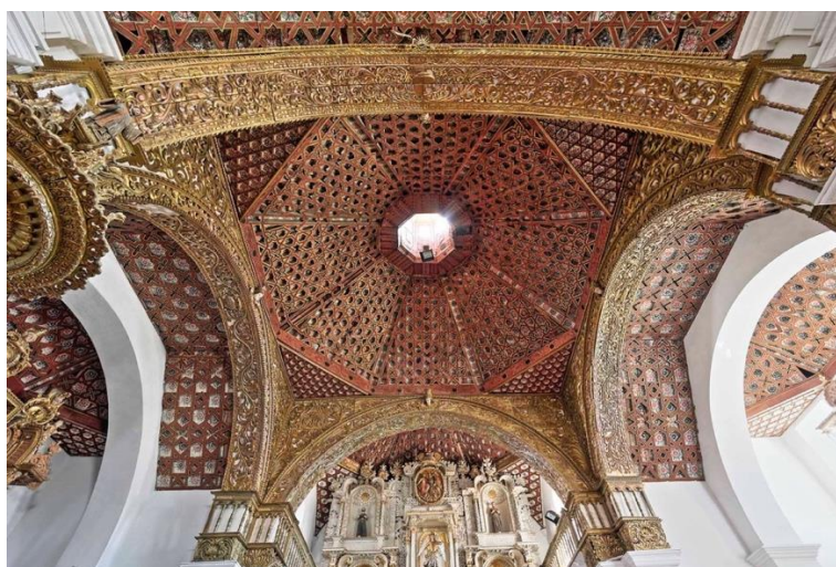
Fig. 154. Charpente à entrelacs du transept de l'église San Miguel à La Plata (Début du XVII e siècle). Photo : SoySucre, s/d, https://www.soy sucre.info/es/templo-de-san-miguel-arcangel/ .
