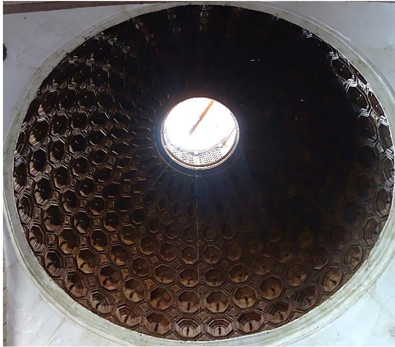
Fig. 171. Coupole à caissons sur le transept de l'église Nuestra Señora de Copacabana à Potosí (ca.1685). Photo : Javier Colmenares, 2021.
