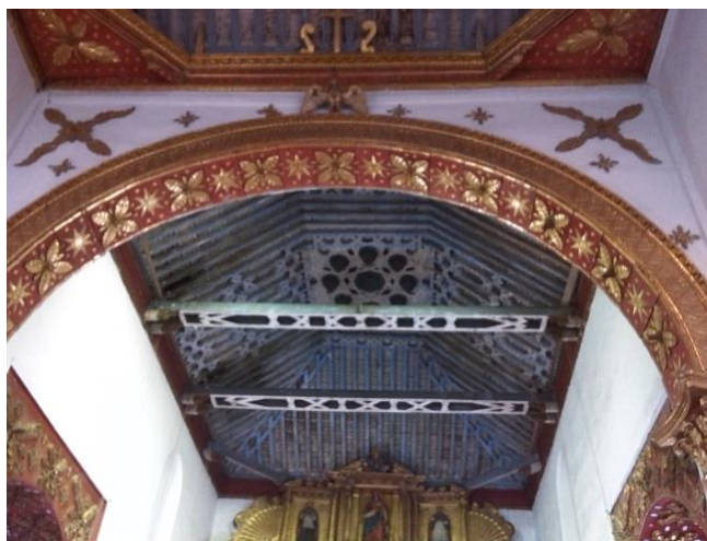
Fig. 97. Charpente sur le chœur de l'église San Francisco à Tunja (ca. 1595). Photo : Simon Secreto, 2020. CC BY-SA 4.0.
