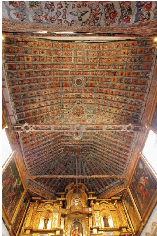
Fig. 139. Charpente structurelle du chœur de l'église San Juan Bautista à Huaru (Fin du XVI e siècle). Photo : CD Ruta del Barroco Andino, 2015.
