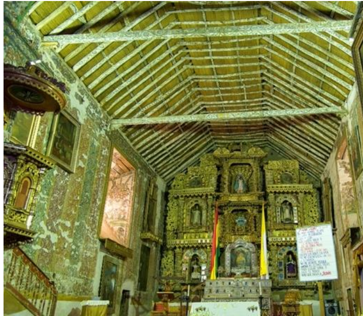
Fig. 188. Charpente de l'église Bartolomé à Carabuco (Début du XVII e siècle). Photo : Norbert Leroy, 2014 https://flic.kr/p/Nqbz2G .
