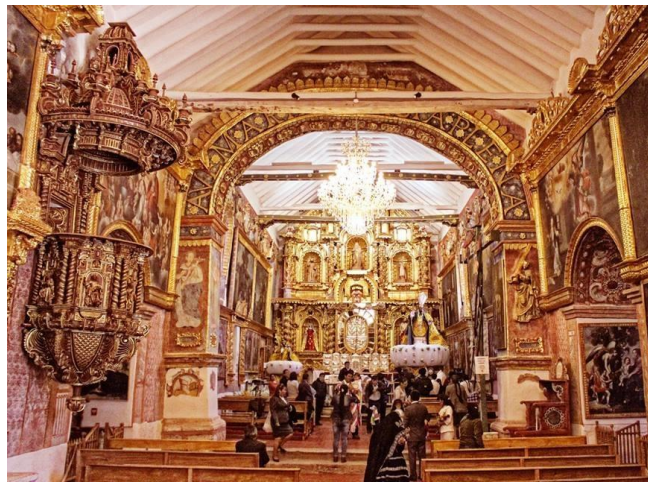
Fig. 144. Charpentes restaurées du chœur et de la nef de l'église San Bartolomé à Tinta (Début du XVII e siècle). Photo : Perú Barroco (Tradiciones Cusqueñas), 2020, https://cutt.ly/MKtEa7i .
