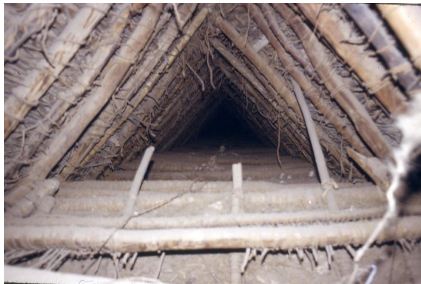
Fig. 27. Vue de l'intérieur de la charpente de l'église Santiago Apóstol de Curaguara de Carangas en Bolivie (1587-1608). Notez que chaque paire de chevrons a son propre entrait retroussé et qu'au sommet de la charpente, le croisement des chevrons est légèrement visible. (Photo : Carlos Rúa Landa, 2021).
