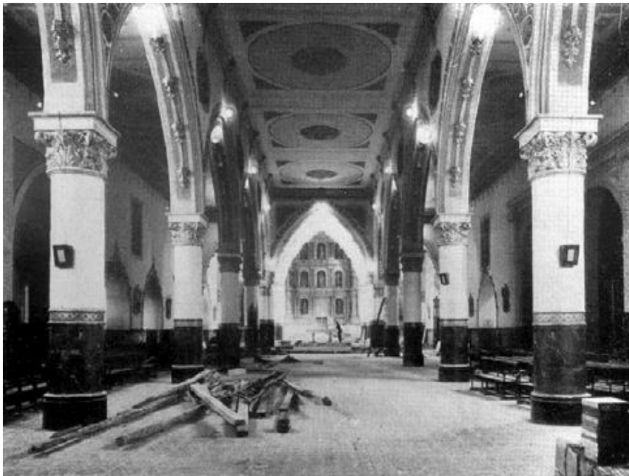
Fig. 96. Faux plafond sur la nef et les collatéraux de la cathédrale Santiago Apóstol à Tunja, avant la restauration de 1965. Carlos Arbeláez, « La Catedral de Tunja », Anales del Instituto de Arte Americano e Investigaciones Estéticas , n° 18 (1965): 18.
