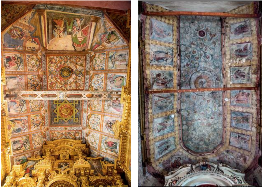
Fig. 141. Charpentes recouvertes de boue sur le chœur : Virgen Inmaculada de Checacupe (1687) (à gauche) et San Pablo de Cacha (Début du XVII e siècle) (à droite). Dans le cas de Checacupe, sur l'intrados, une toile tendue est collée à la structure sur laquelle est peint le décor. Photos : Raul Montero Quispe, 2016, https://mavcor.yale.edu/material-objects/painted-ceiling-scene-annunciation-and-portraits-saints ; Ananda Cohen-Suárez, « Las pinturas murales de la iglesia de San Pablo de Cacha (Canchis, Perú) », Allpanchis 43, n° 77/78 (2011) : 39.
