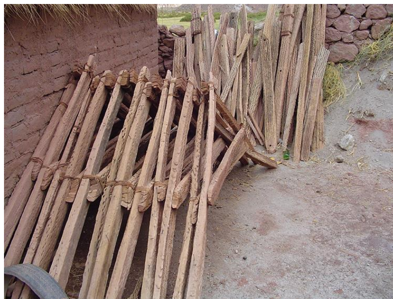
Fig. 59. Tijerales et poutres de cardón dans une maison à Susques (Argentine). María Florencia Barbarich et Jorge Tomasi, « Los cardones en los tijerales. El uso de la madera de cactus columnares en el patrimonio arquitectónico de la Puna de Atacama (Susques, Jujuy, Argentina) », Apuntes: Revista de estudios sobre patrimonio cultural 33 (2020) : 10.
