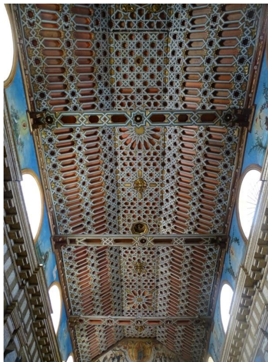
Fig. 125. Charpente à entrelacs sur la nef de l'église Santo Domingo à Quito (ca.1610). Photo : Francisco Mamani, 2018.
