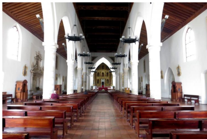
Fig. 15. Charpentes monopente sur les collatéraux de la cathédrale de Tunja (Début du XVII e siècle ; Restauration en 1950) (Photo : Archivo alcaldía mayor de Tunja © 2013).
