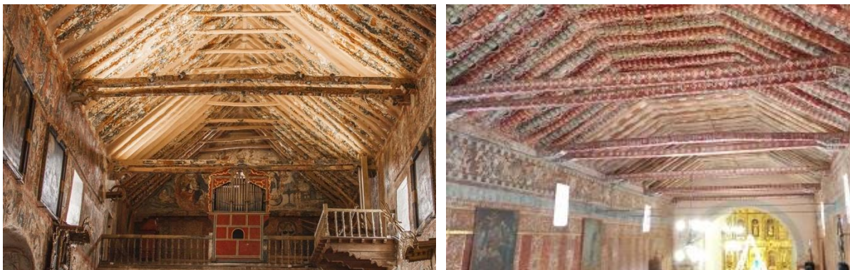
Fig. 143. Charpentes par-nudillo sur la nef : San Juan Bautista d'Huaro (Fin du XVI e siècle) (à gauche) ; Santiago Apóstol de Caicay (1581-1608) (à droite). Photo : Caja Municipal del Cusco, Por la Ruta del Barroco Cusqueño (Cusco : Carlotan, 2013), 45 ; MapsUs.net, s/d, https://mapsus.net/PE/templo-santiago-apostol-de-caicay-71527 .
