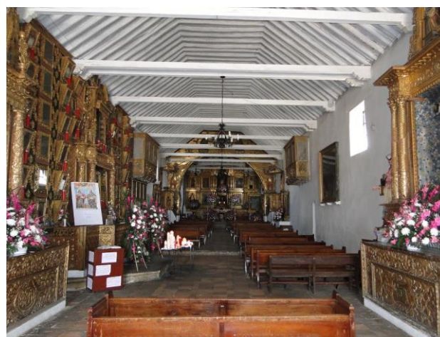
Fig. 108. Charpente de l'église de Tópoga (Début du XVII e siècle). Photo : Sans auteur, ni date, https://mapio.net/pic/p-82058516/
