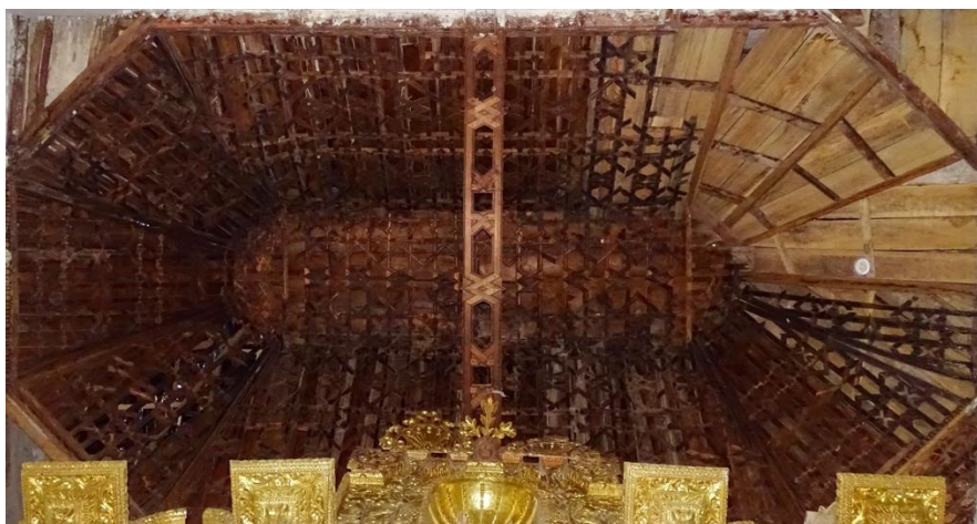
Fig. 162. Charpente à entrelacs de la chapelle à droite de l'église La Merced à La Plata (ca.1573). Photo : Francisco Mamani, 2018.
