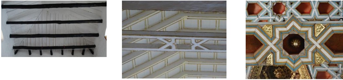
Fig. 56. Types de tirants : tirant rustiques fabriqué de rondins de bois dans l'église La Merced à Cali en Colombie (Deuxième partie du XVII e siècle) (à gauche); Tirants doublés ornées à entrelacs dans l'église du couvent Santa Teresa à Sucre en Bolivie (Deuxième parti e du XVII e siècle) (au centre) ; Tirants doubles finement ornés à entrelacs avec une étoile à huit branches, il y a l'intérieure de l'étoile une pomme de pin dorée, dans l'église Santo Domingo à Quito en Équateur (Début du XVII e siècle). Photos : Francisco Mamani 2018.
