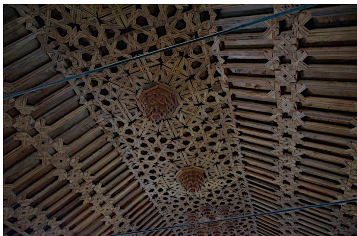
Fig. 22. Charpente par-nudillo de l'église La Merced à Potosí en Bolivie (Début du XVIIIe siècle). Notez les chevrons de chaque pans reposant sur l'entrait retroussé. L'ensemble de tous les entrails retroussés configure l' almizate dans le plan horizontal de la charpente (Photo : Jelbo64, 2018 © Flickr).
