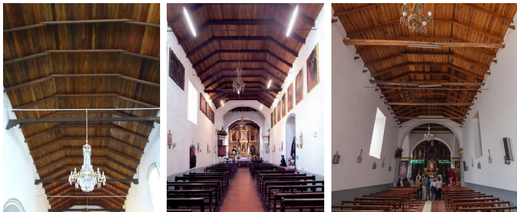
Fig. 166. Charpentes restaurées des églises San Lázaro (à gauche) ; San Sebastián (au centre) ; San Roque (à droite). Photos : Francisco Mamani, 2018 ; Marc Anthony Torres, 2019, https://www.facebook.com/photo.php?fbid=1211287879054376&set=a.1211286089054555&type=3 .
