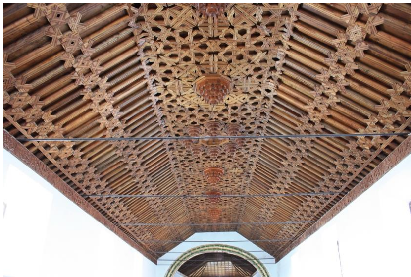
Fig. 168. Charpente à entrelacs sur la nef de l'église La Merced à Potosí (1620). Photo : Fotografía y Viajes, 2020, http://www.fotografiayviajes.com/bolivia/la-villa-imperial-de-potosi/ .
