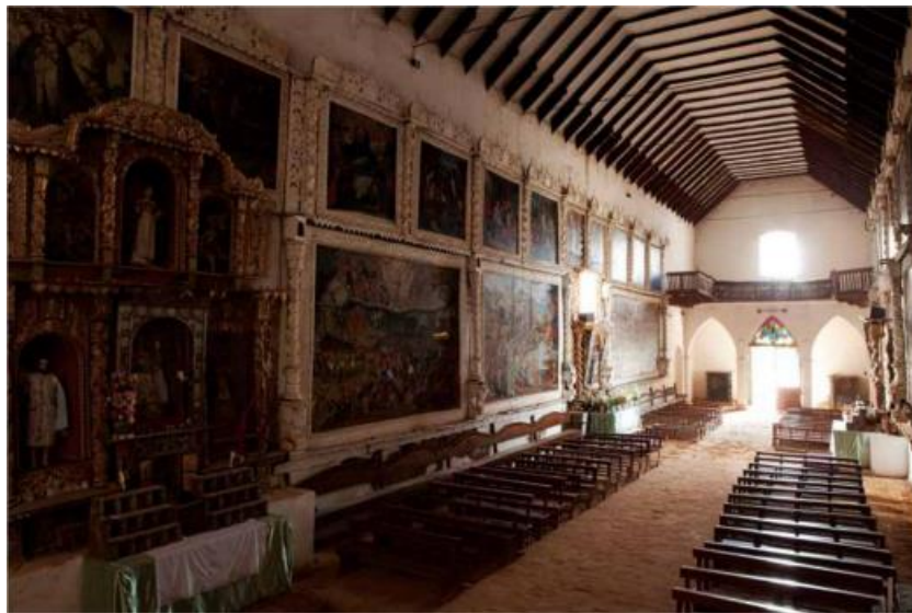
Fig. 190. Charpente de l'église San Antonio à Caquiaviri (1581, restauration 1988-1991). Max Donoso, Iglesias de la antigua Ruta de la Plata (Santiago : Max Donoso, 2011), 191.
