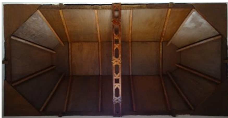
Fig. 163. Charpente fourrée de la chapelle à gauche de l'église La Merced à La Plata (Date inconnu). Photo : Francisco Mamani, 2018.
