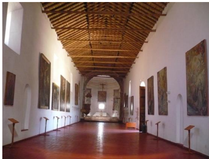
Fig. 151. État actuel de la charpente d'église La Asunción à Juli (1602). La structure est complètement nouvelle, ne gardant aucune trace de l'ancienne. Photo : Museo Cultura Peru, s/d, https://museos.cultura.pe/museos/templo-museo-nuestra-se%C3%B1ora-de-la-asunci%C3%B3n .
