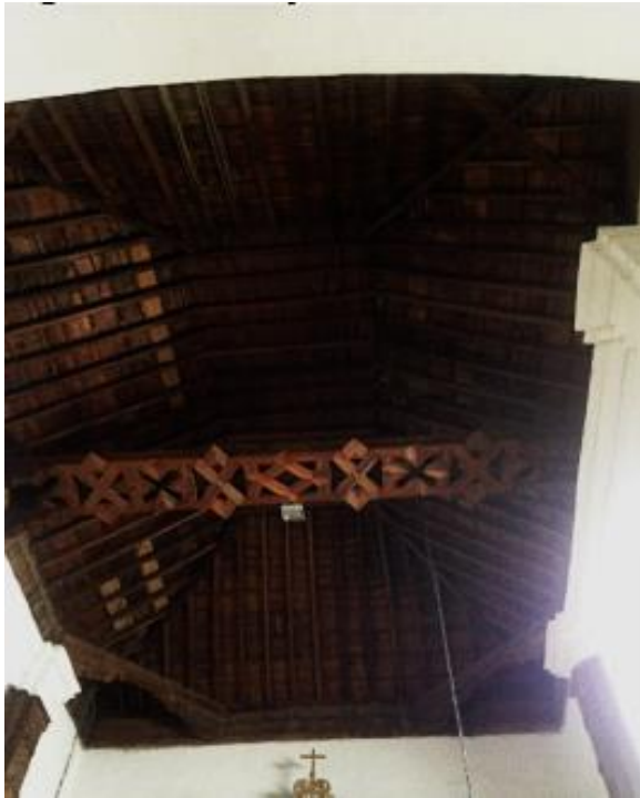
Fig. 104. Charpente sur le chœur de l'église Ecce Homo à la Villa de Leyva (1660). Juan David Flórez et Juan Carlos Ortíz, Antiguo convento del Santo Ecce Homo. Caracterización y propuesta de cambio de uso (Bucaramanga : Universidad Santo Tomás, 2015), 56.
