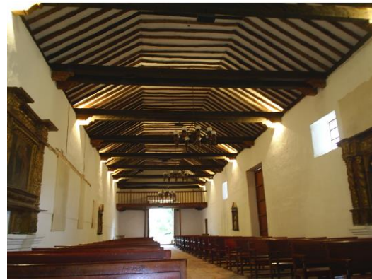
Fig. 110. Charpentes de l'église de doctrine de Suesca (Début du XVII e siècle). Notez la quantité de tirants : 5 dans le chœur et plus de 7 dans la nef. Photos : Guadalupe Romero Sánchez, Los pueblos de indios en Nueva Granada: las trazas urbanas e iglesias doctrineras (Thèse de doctorat. Granada, Universidad de Granada, 2008), 1356, 1359.
