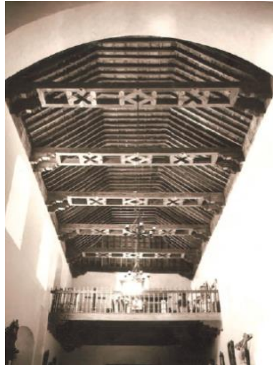
Fig. 105. Charpente sur la nef de l'église Ecce Homo à la Villa de Leyva (1661). Alberto Corradine, El monasterio de Santo Ecce-Homo. El florecimiento del arte mudéjar-toscano en la Nueva Granada , (Santa Sofía : Provincia de San Luis Bertrán de Colombia, 2020), 20.
