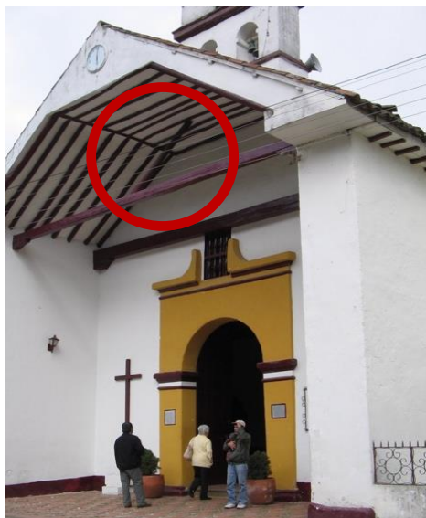
Fig. 109. Charpente de l'église de Zipacón (Début du XVIIe siècle) : le tornapunta en cercle rouge. Photo : Sans auteur, sans date, https://mapio.net/pic/p-18686243/ .
