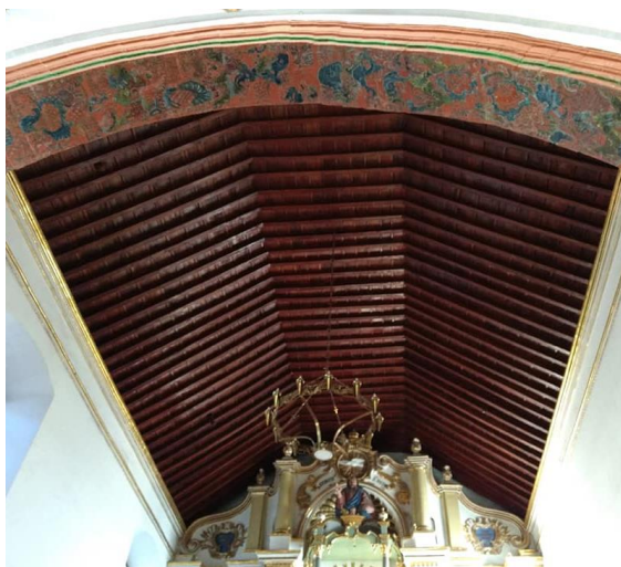
Fig. 175. Charpentes lisses, sans entrelacs, d'une chapelle (à gauche) et de la nef de l'église Santo Domingo à Potosí (ca. 1625). Photo : Javier Colmenares, 2021.
