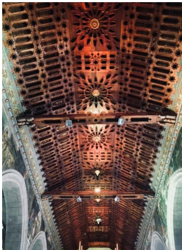
Fig. 114. Charpente actuelle de la cathédrale de Quito (1962). (Photo : Francisco Mamani, 2018)
