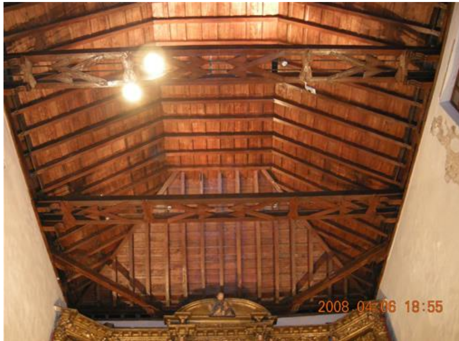
Fig. 91. Charpente sur le chœur de l'église Nuestra Señora de las Aguas à Bogotá (1690). Photo : Juan Guillermo Moncada, 2012. https://www.moncadamejia.com/images/joyas_arquitectonicas/iglesia_las_aguas/h05.jpg
