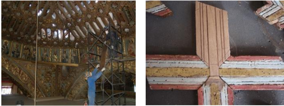
Fig. 119. Entretien de la charpente de la croisée du transept à San Francisco en 2016. À gauche, le changements des planches du fond de la charpente ; à droite, une section restaurée des entrelacs. Photo : Ramiro Pauta, in Vicente Cajas, « Análisis de las intervenciones patrimoniales en Quito (Ecuador). Los casos de las Iglesias de San Francisco y de la Compañía de Jesús » (Mémoire de master, Barcelona, Universitat Politècnica de Catalunya), 2016, 71 et 73.
