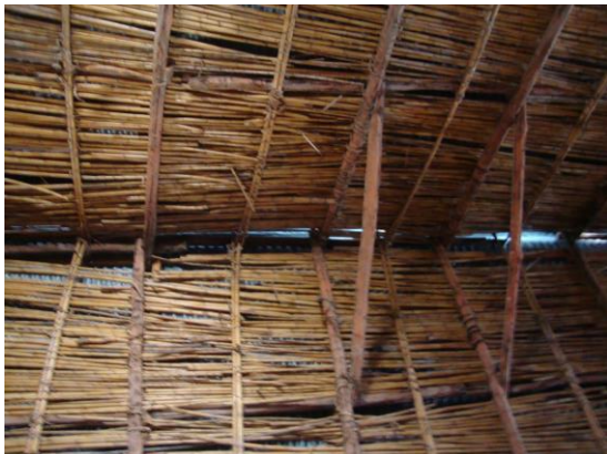
Fig. 196. Charpentes restaurées couvertes de planches en calamina (alliage de zinc, de plomb et d'étain) : église San Bartolomé à Livilcar (1723 ; restauration fin XX e siècle) (à gauche) ; église La Asunción de la Virgen à Putre (1689 ; restauration fin XX e siècle). Magdalena Pereira Campos, Arte y devoción en la ruta de la plata de Potosí, iglesias Andinas (S. XVII-XIX) , (Thèse de doctorat, Seville, Universidad de Sevilla, 2019), 261, 468.
