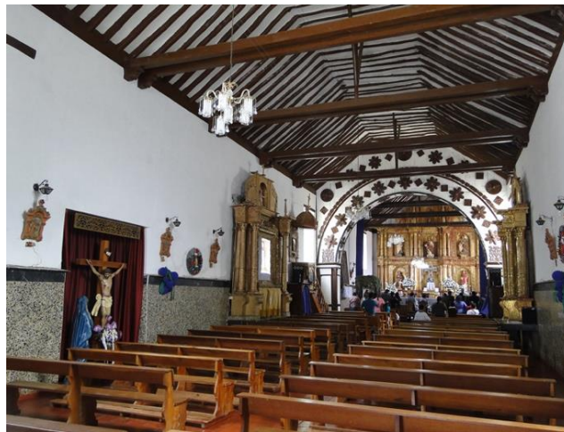
Fig. 107. Charpente par-nudillo de l'église de Sachicá (XVII e siècle). Photo : German Vallejo, 2015. https://www.viajarenverano.com/sachica-boyaca/ .
