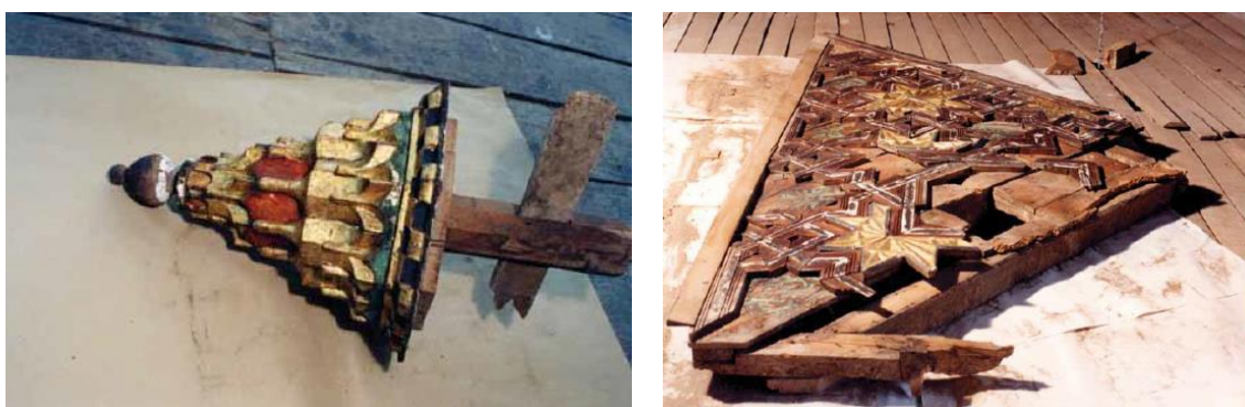
Fig. 118. État de la charpente de la tribune avant la restauration de 1995. Notez le fleuron à muqarnas polychromé, après la restauration, il a été repeint en doré (à gauche) ; à droite, une section du pan de la charpente assez endommagée. José Mercé et José Gallegos, éd., Iglesia y convento de San Francisco : una historia para el futuro (Quito : INPC, 2011), 275 et 278.
