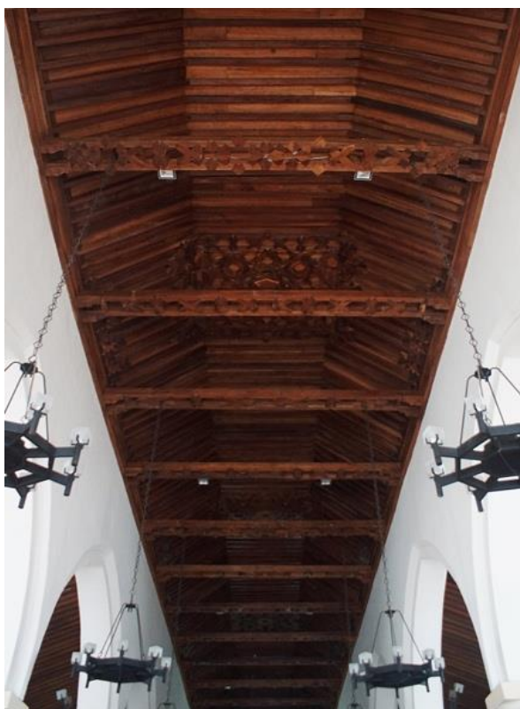
Fig. 95. Charpente sur la nef de la cathédrale Santiago Apóstol à Tunja (1575). Photo : Percival Tirapeli, 2017. http://acervodigital.unesp.br/handle/unesp/378689
