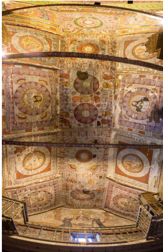
Fig. 142. Charpente recouverte de boue sur la nef de l'église San Francisco de Asis de Marcapata (Fin du XVI e siècle). Raul Moreno Quispe, 2018, https://mavcor.yale.edu/material-objects/giga-project/marcapata-ceiling-zoom .
