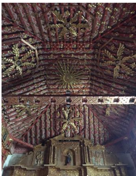
Fig. 101. Charpente fourrée sur le chœur de l'église Santa Clara à Tunja (XVII e siècle). Photo : Alfonso P, 2016.
