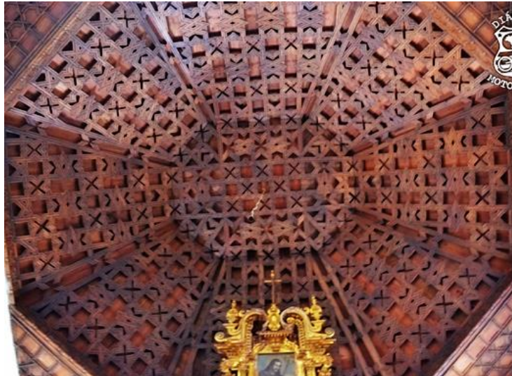
Fig. 161. Charpente octogonale de la chapelle de l'église San Francisco à La Plata (1610). Photo : Guga Dias e Elda, 2011, https://flic.kr/p/aEZ5tG .
