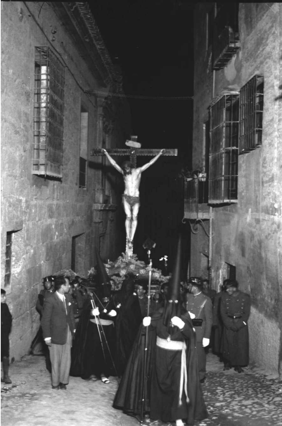
Cristo de la Misericordia a su paso por la calle de la Cárcel Alta (1945). Archivo de Manuel Lirola García.
