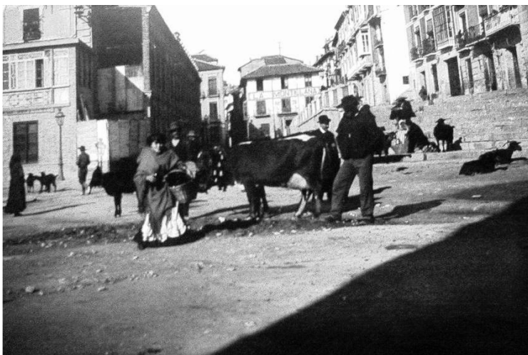
El vacío originado tras las demoliciones previas a la construcción de la calle Ganivet.
