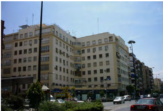
Vista actual de la esquina del camino de Ronda con Recogidas
