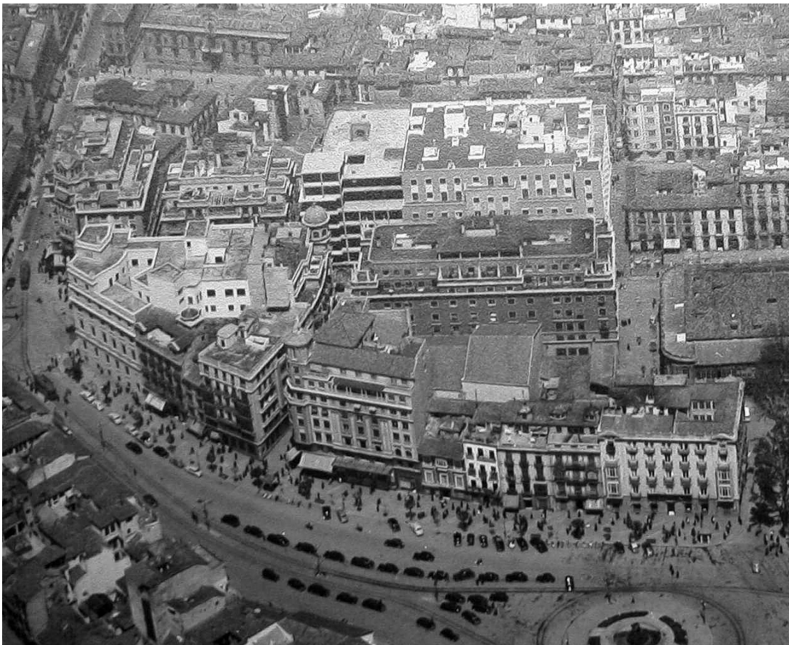
Ensanche interior tras la remodelación de la Manigua. Foto de 1953
