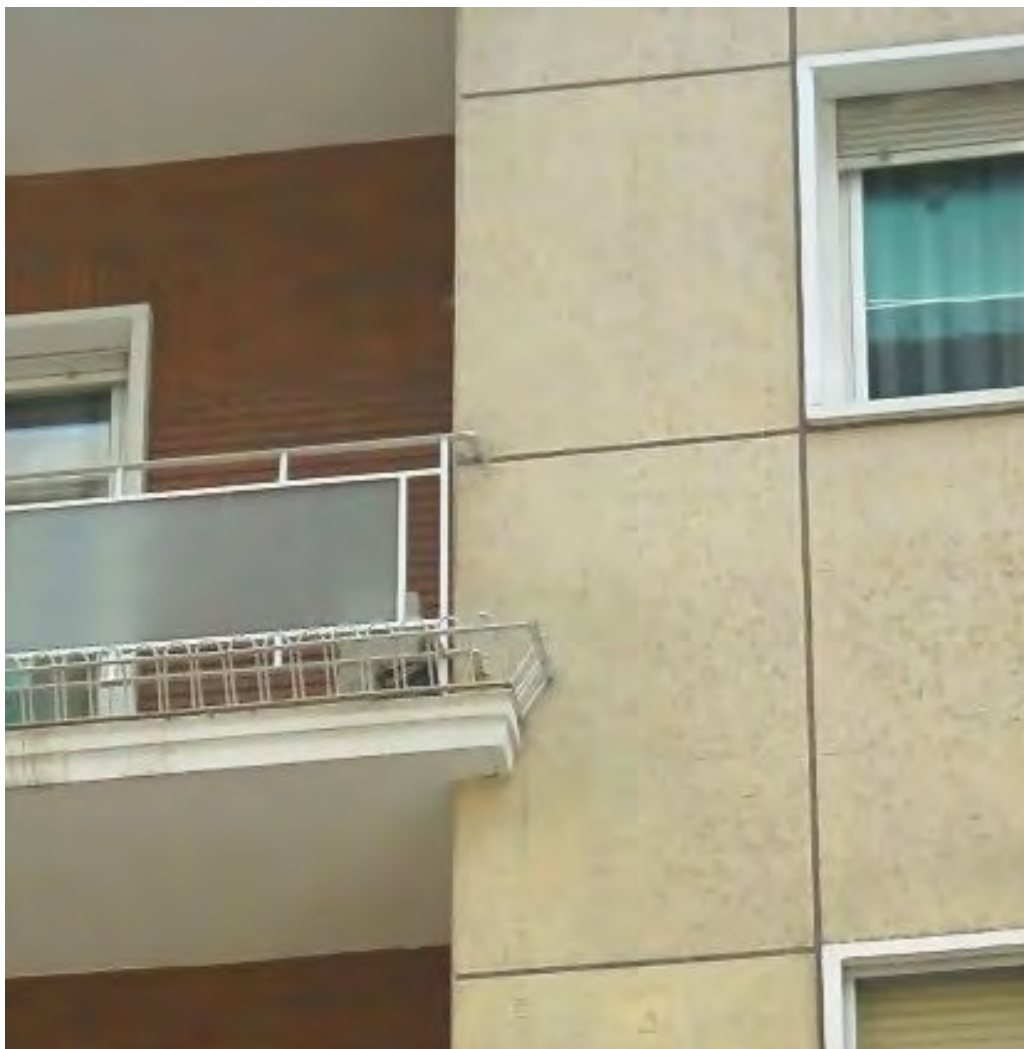
En el número 39 de la calle Recogidas se alternan revestimiento de gresite y de plaqueta cerámica.
