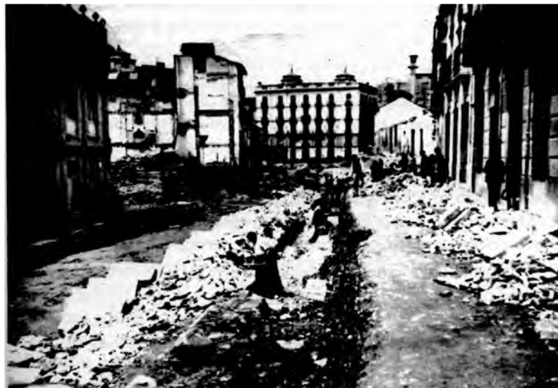
El vacío sin edificar dejado con la demolición de la Manigua.
