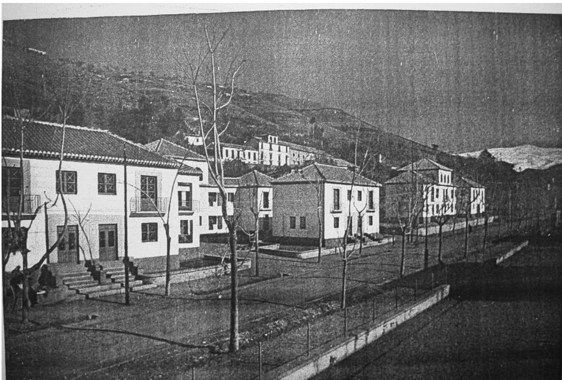
Grupo de casas de la carretera de la Sierra, cuyo proyecto lo firman Castillo Moreno, Prieto-Moreno y Wilhelmi Manzano.
