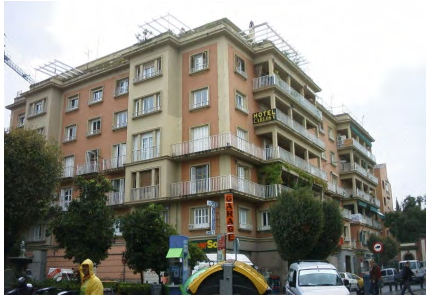
Fotografía actual del edificio de la plaza de los Campos
