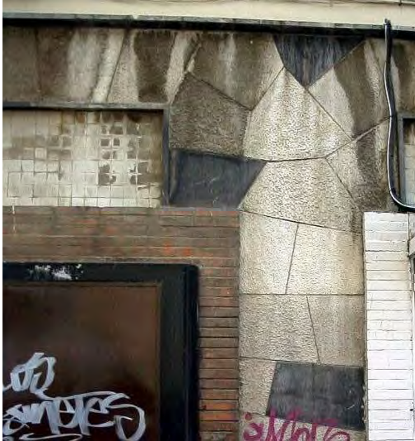
Aplacado de piedra blanca y negra con distintas texturas abujardada y lisa, y formas, en concierto irregular, en la Calle Cetti Meriem.
