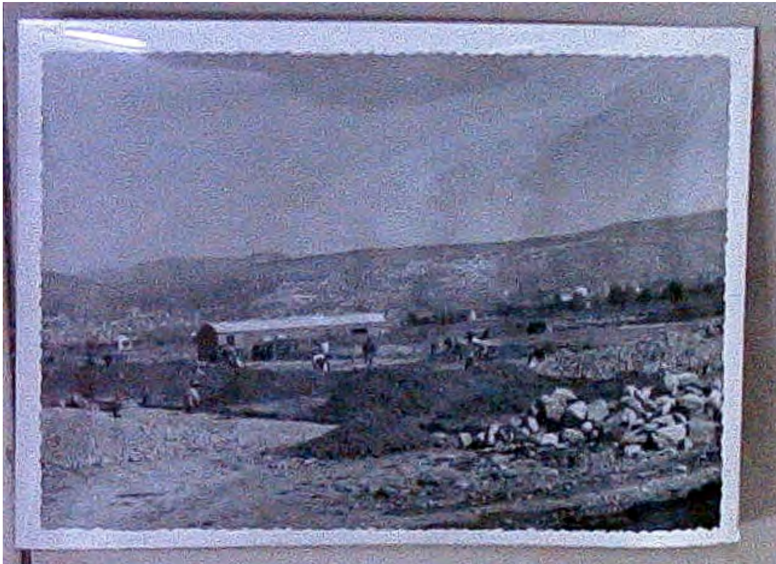
Vista del Pago Seco del Zaidín en los inicios de las obras de la primera fase de la barriada del Generalísimo, al fondo, a lo lejos, al pie de la ladera se divisa Granada
