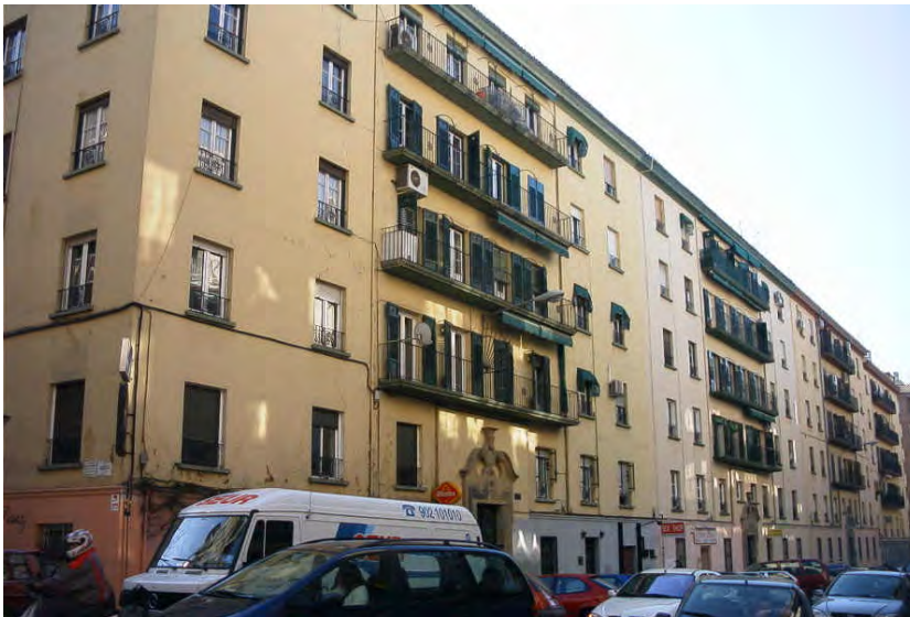
Vista actual del edificio
