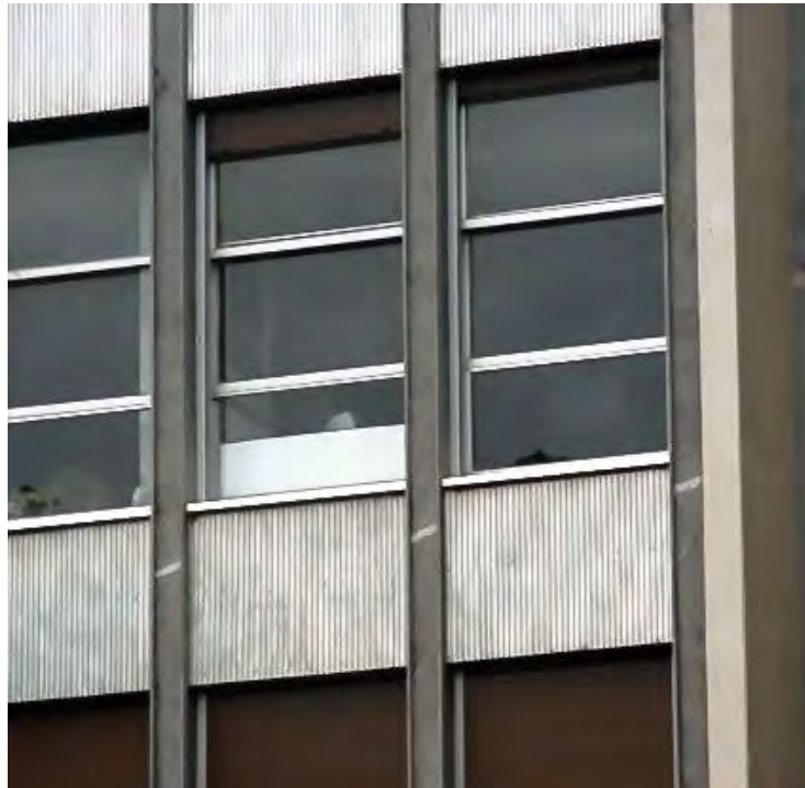
Revestimiento de duelas de aluminio anodizado en la
