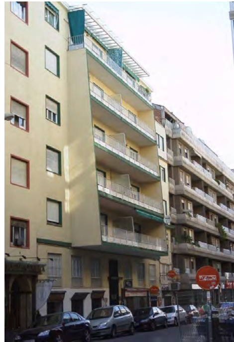
Fachada del edificio de P.A. de Alarcón
