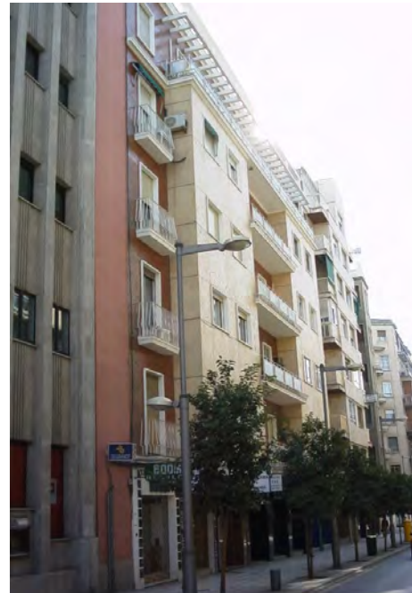
Aspecto exterior del edificio de la calle Recogidas
