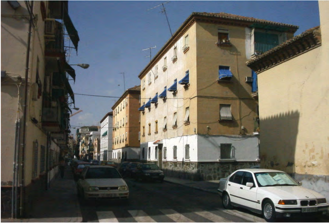
Los edificios de Wilhelmi Manzano
