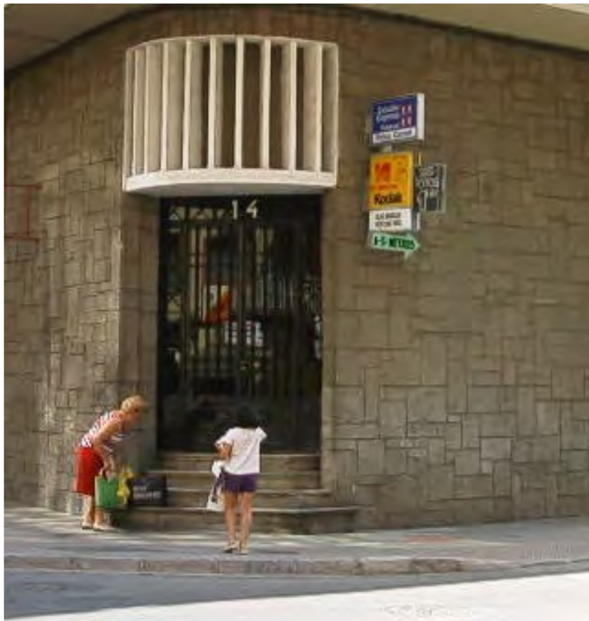
Aplacado de piedra de Sierra Elvira de piezas de distintos tamaños en la calle Pedro Antonio de Alarcón.
