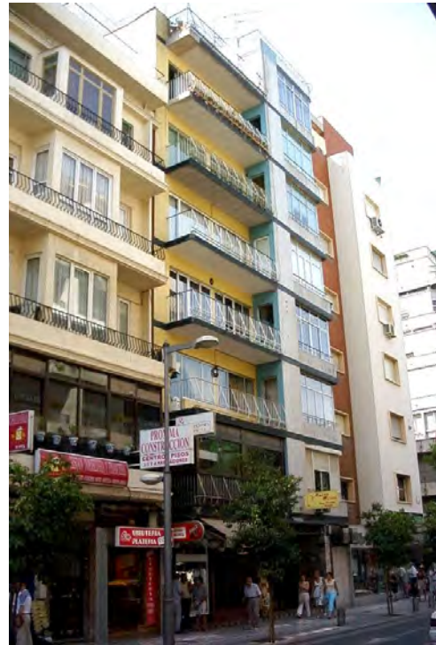
Vista actual del edificio de la calle Recogidas
