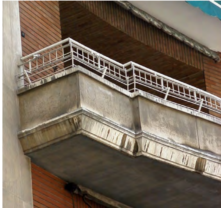
Balconada en el número cuarenta y tres de la calle Recogidas
