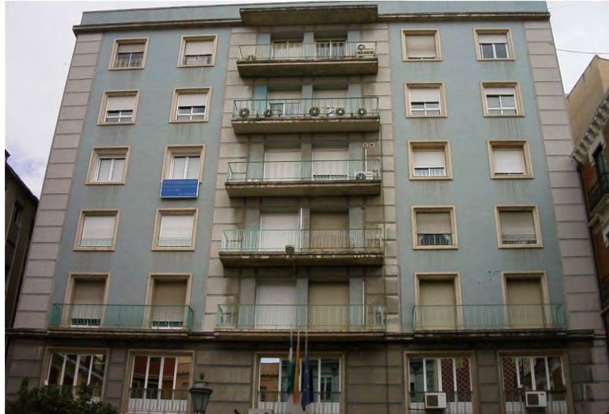
Fachada principal del edificio de la plaza de Campo Verde, de 1958
