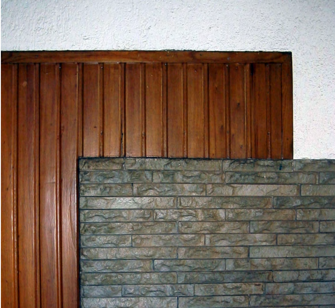
Superposición de duelas de madera y piedra de Sierra Elvira en canto, mostrando el trabajo de los alicates
