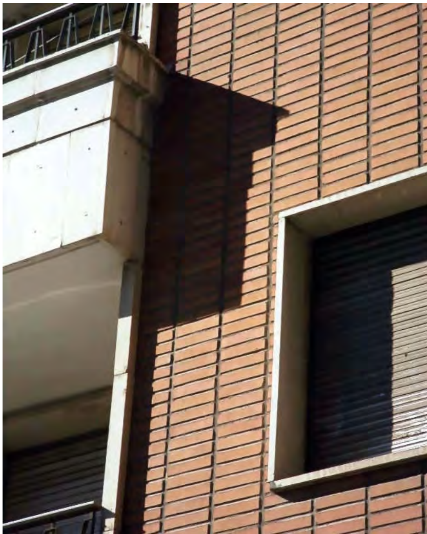
Un revestimiento de plaqueta cerámica dispuesta en damero, magníficamente ejecutado en la calle Fray Leopoldo, de 1958.
