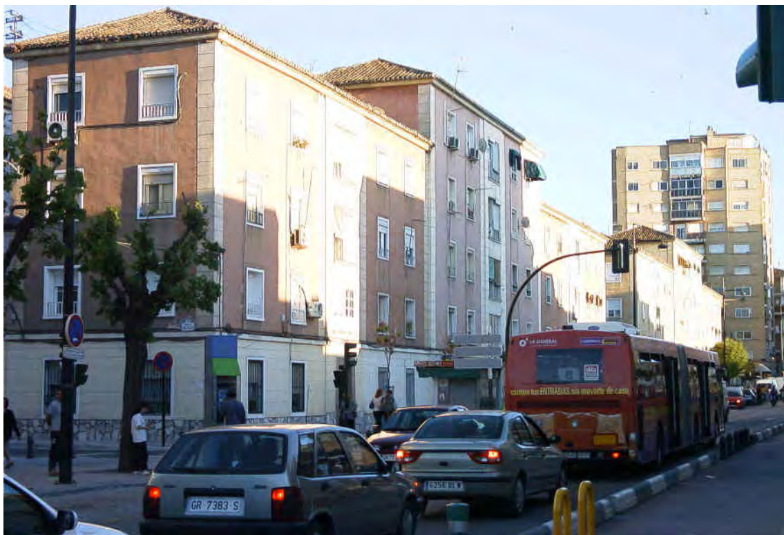
Los edificios de Fernández-Figares dando fachada a la avenida de Dílar
