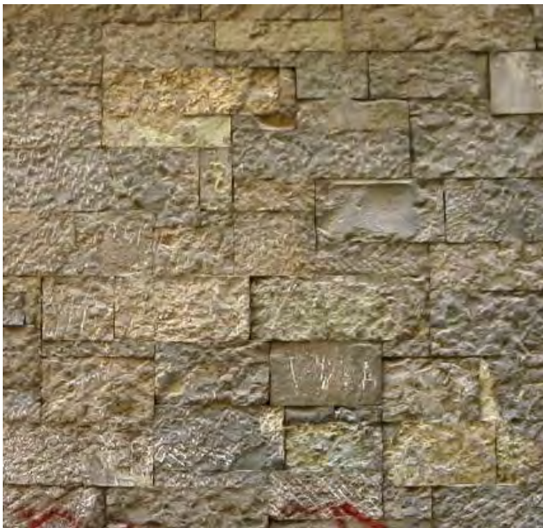
Aplacado concertado de piedra toscamente labrada, de 1963
