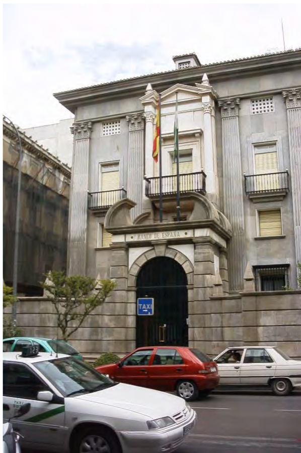
Acceso principal del Banco de España al frente a la Gran Vía
