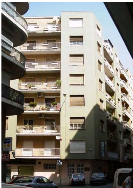
Estado actual de la fachada
