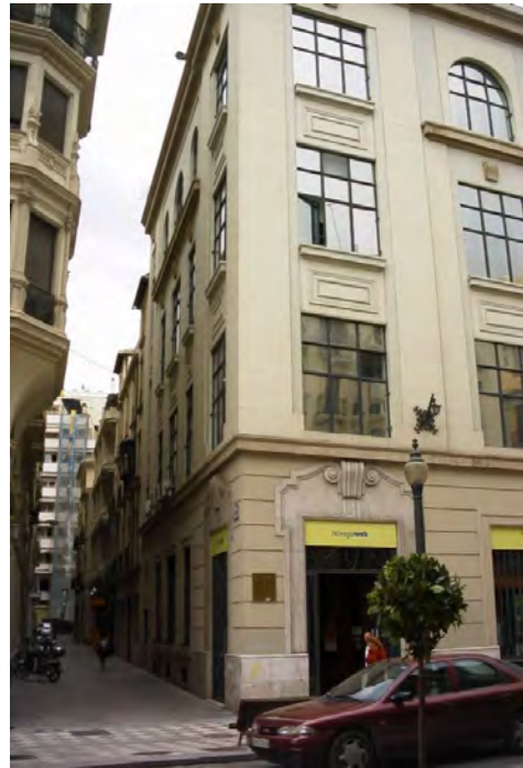
Vista exterior del edificio de la CNE en la calle Reyes Católicos, construido en 1928
