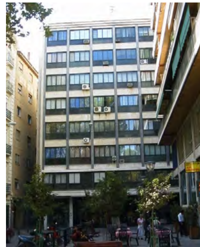
Vista actual del edificio Macià
