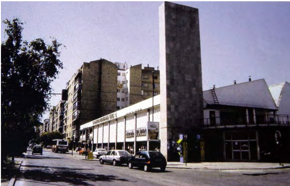
Fachada principal de la estación de autobuses
