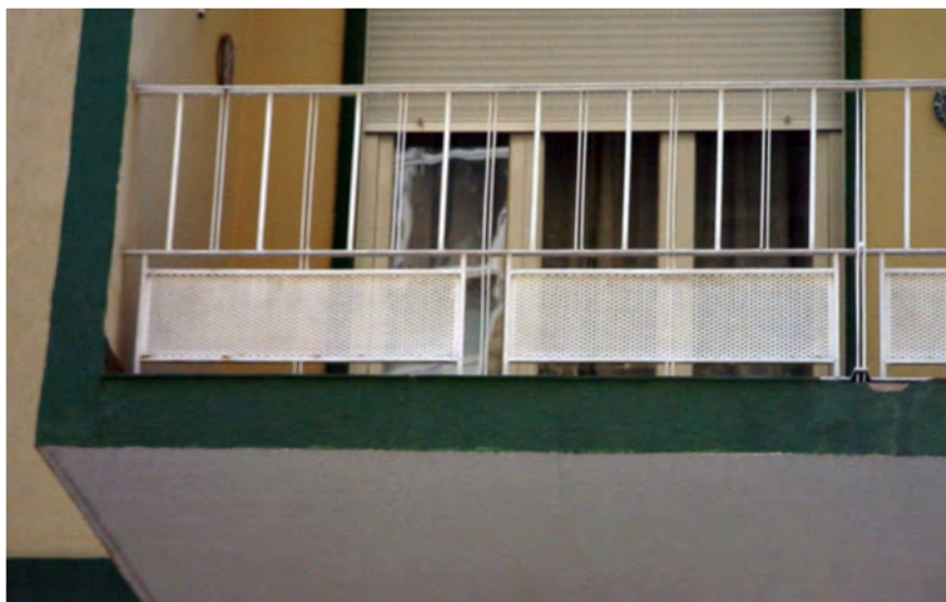
Barandilla de 1954 totalmente geométrica en Pedro Antonio de Alarcón
