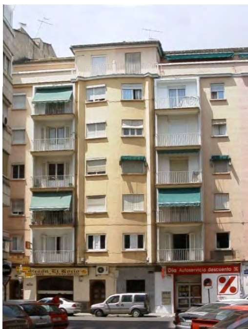
Vista actual de uno de los edificios iguales
