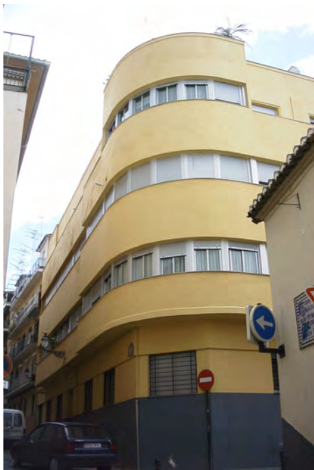
Fotografía actual del edificio
