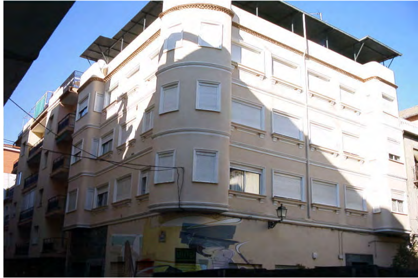
Exterior del edificio de viviendas en la calle Buensuceso,
