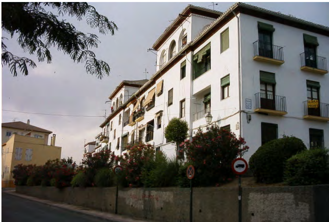
Grupo Pizarro Cenjor en la carretera de Pulianas, proyectadas por Castillo Moreno, Prieto-Moreno y Wilhelmi Manzano;
