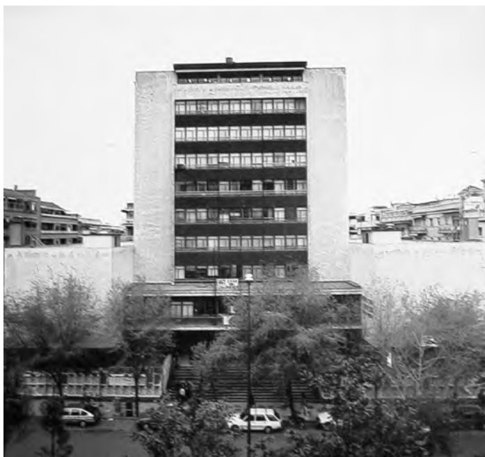
Vista actual de la fachada principal
