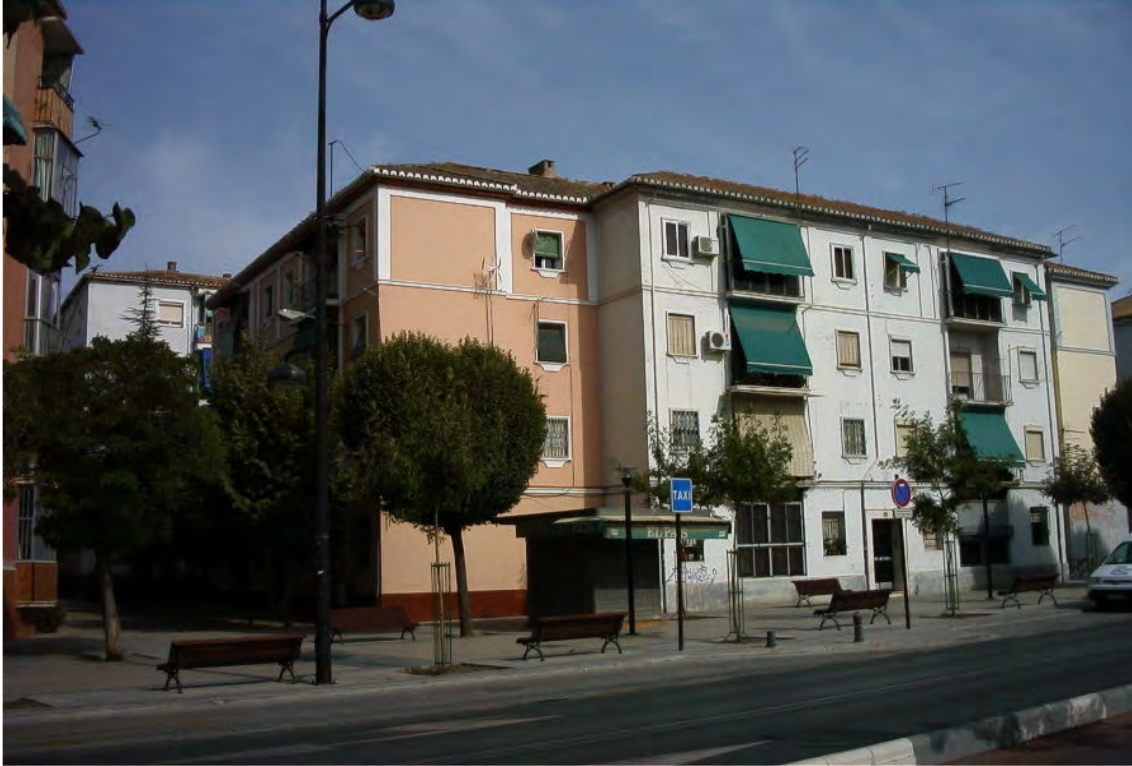
Edificio "compuesto" de Castillo Moreno
