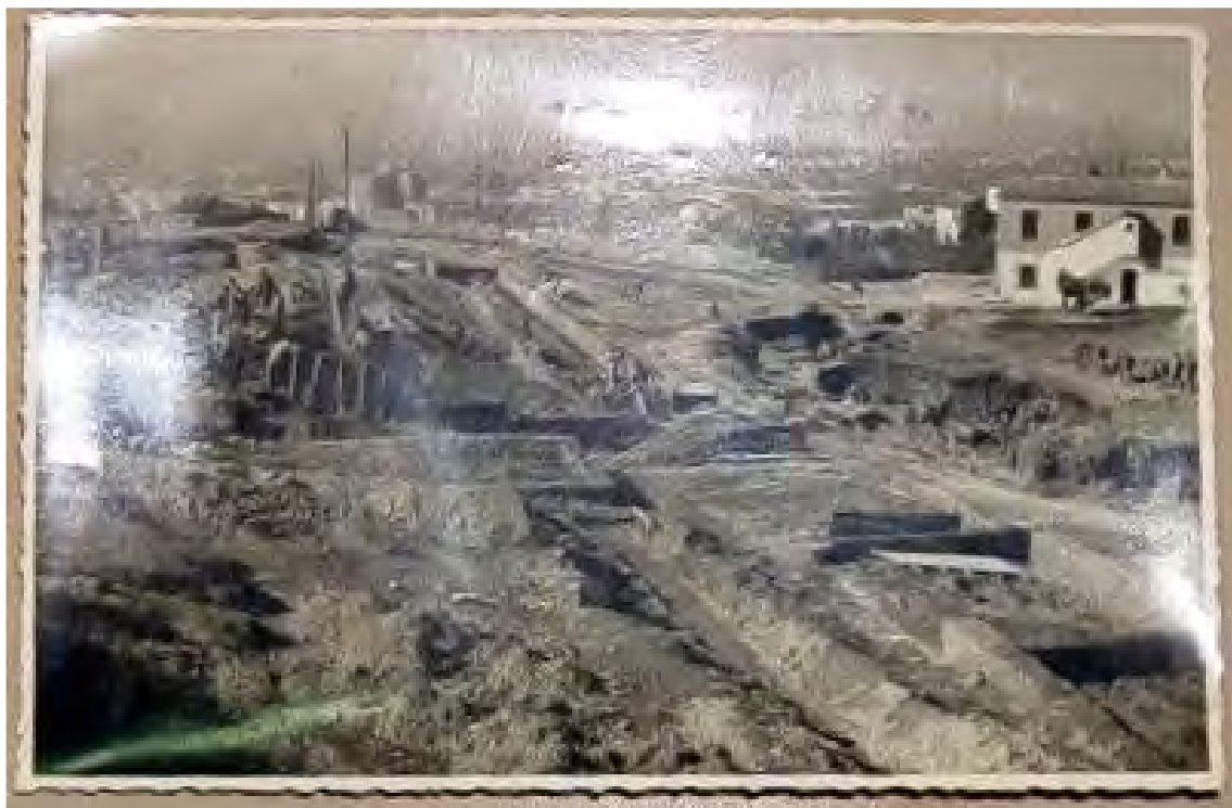
La finca elevada en la que se ubica la barriada, en la foto ya iniciados los movimientos de tierras.
