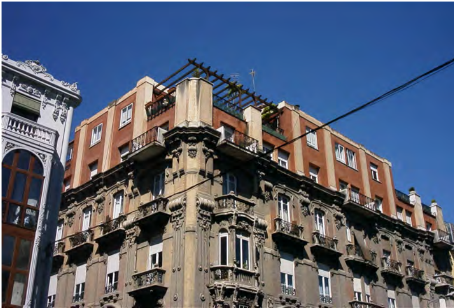
Ampliación de volumen concedida genéricamente a la Gran Vía ejemplificado en el número veinticinco de dicha vía
