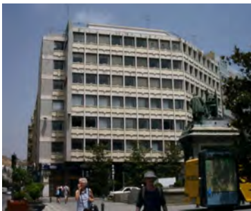
Estado actual del edificio
