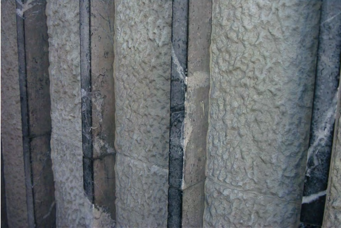
Abujardado grueso de Sierra Elvira encintado con baquetones verticales de mármol negro, en la Gran Vía
