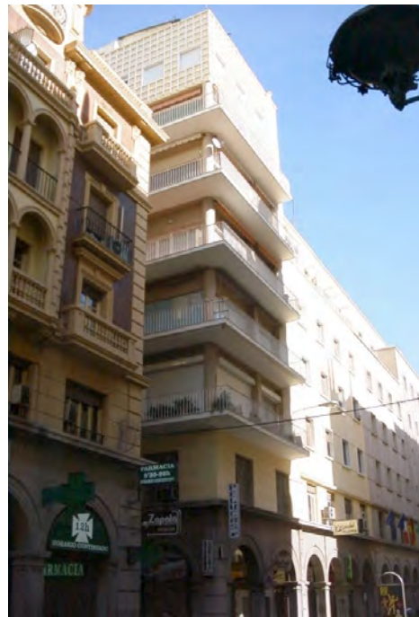
vista actual del edificio
