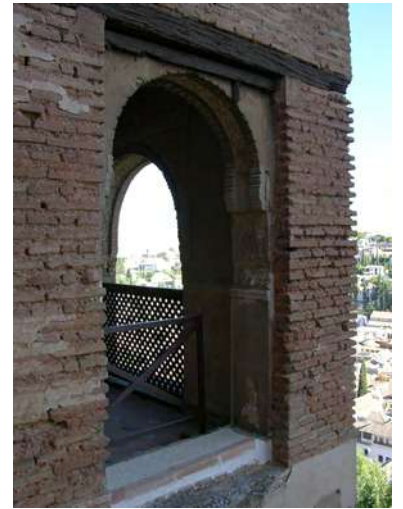
[Fig. 9] Exterior del hueco oriental del Mirador de la Victoria con restos de celosía en la parte superior. Fotografía de la autora, 2017.
