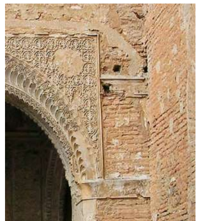
[Fig. 1] Qubba de la crujía norte. Detalle de friso y alero interrumpidos por el arco mudéjar ampliado. Fotografías de la autora, 2017.
