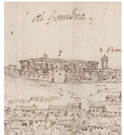
[Fig. 1] El Palacio de Carlos V en construcción, visto desde el sur. El centro del lienzo oeste figura aún sin cerrar, mientras que en el meridional destaca el balcón serliano ya construido. En el tramo de muralla delantero existía un mirador cubierto aludido por las fuentes escritas. A la derecha, la parroquia de Santa María de la Alhambra (antigua Mezquita Mayor) con su alminar convertido en campanario, que se rotula erróneamente como "San Francisco" en probable referencia al cercano convento (curiosamente, Vico en su Plataforma repetiría tal confusión). Detalle de la vista de Granada desde el sur por Anton van den Wyngaerde, 1567. Dibujo incluido en la obra Villes d'Espagne . ÖNB, Cod. Min. 41, 55.
