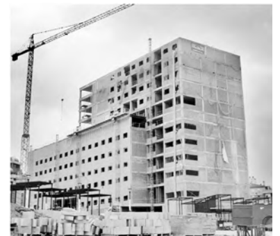
[Fig. 2] El hotel en construcción. IDEAL, 13 de septiembre de 2004.
