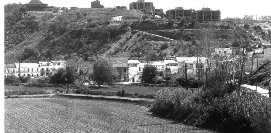
[Fig. 7] Vista de la urbanización El Serrallo en construcción desde la ribera del Genil. A la izquierda, el restaurante de la actual Real Sociedad de Tenis con su cubierta piramidal. A la derecha, los primeros bloques edificados en la parte interior de la colina. Hemeroteca IDEAL, 1978.
