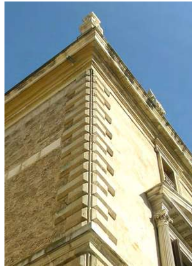
[Fig. 6] Diferencia de tratamiento material entre la fachada principal y los testeros laterales. Fotografía de la autora, 2019.
