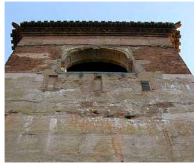
[Fig. 7] Exterior del hueco norte del Mirador de la Victoria con restos de las cajas de vigas que sostenían el ajimez. Fotografía de la autora, 2017.
