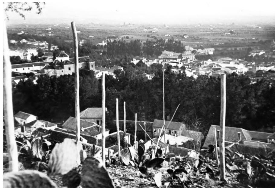
[Fig. 4] Vistas desde el extremo oriental del terreno adquirido por el pintor, al inicio de los trabajos. Al fondo, el Campo del Príncipe densamente arbolado, el Penal de Belén y la vega meridional. ca. 1918. AFRA.
