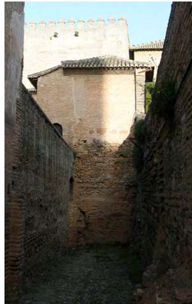
[Fig. 4] Camino de ronda bloqueado por la construcción del pórtico norte del Patio de Machuca. Fotografía de la autora, 2017.
