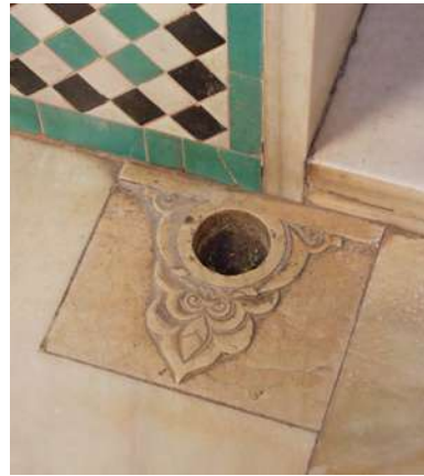
[Fig. 4] Quicialera de mármol ante el vano central de acceso al Cuarto Dorado. Fotografía de la autora, 2018.
