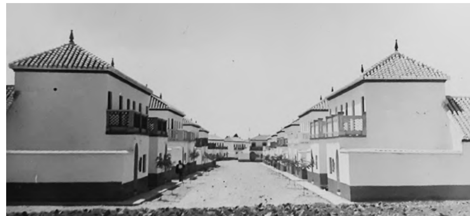
[Fig. 5] Fase 2 de Santa Adela al término de su construcción. La fotografía comprende las casas extremas de dos series de manzanas contiguas. Estas viviendas de remate de manzana cuentan con dos plantas y patios laterales. ASGG.
