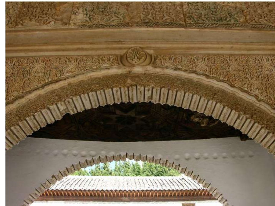
[Fig. 6] Diferencias entre los arcos interno y externo del acceso al Mirador: desalineamiento de claves. Obsérvense también las marcas en la cara interna del arco de comunicación con el patio, posiblemente relacionadas con los clavos de la primitiva puerta. Fotografía de la autora, 2021.
