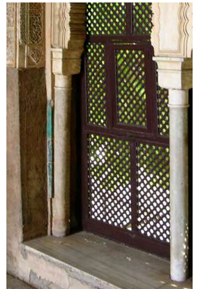
[Fig. 4] Detalle de jamba con piezas verdes vidriadas. Fotografía de la autora, 2017.
