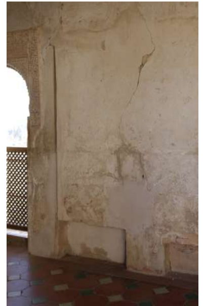
[Fig. 6] Testigos de los anteriores balcones en el interior del Salón Regio. Fotografía de la autora, 2021.
