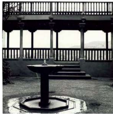
[Fig. 8] La Galería desde el Patio de la Rreja. APAG, Colección de Fotografías, F-017841.
