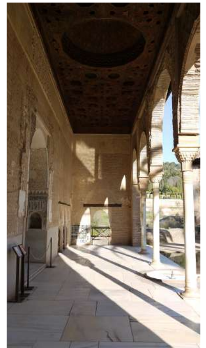
[Fig. 1] Pórtico del Partal. Fotografía de la autora, 2021.
