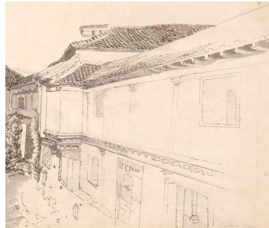
[Fig. 3] La Galería del Patio de la Reja con el cerramiento exterior macizado. Obsérvese también, hacia la izquierda, el voladizo de comunicación con los aposentos imperiales. Apunte de William Gell, 1808. BM, número de registro 1853.0307.678.
