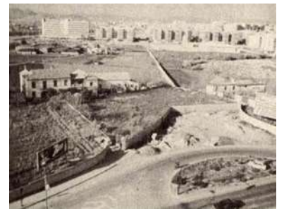
[Fig. 1] Terrenos donde se habría de construir la sede central CajaGranada hacia 1992. Fotografía del Plan Parcial Cruz de Lagos incluida en la documentación del concurso para la nueva sede de CajaGranada y publicada en Concurso arquitectónico para el nuevo edificio de la sede central (1993), 55.
