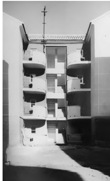
[Fig. 12] Bloques en H de Ambrosio del Valle, con escalera abierta y terrazas en cuarto de círculo. ASGG.
