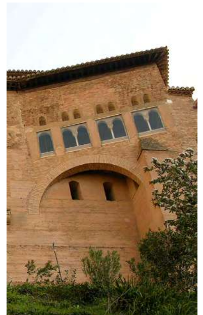
[Fig. 1] Encabalgamiento sobre la muralla del Oratorio del Mexuar. Obsérvense las almenas embebidas y el adarve cubierto a una cota inferior. Fotografía de la autora, 2017.
