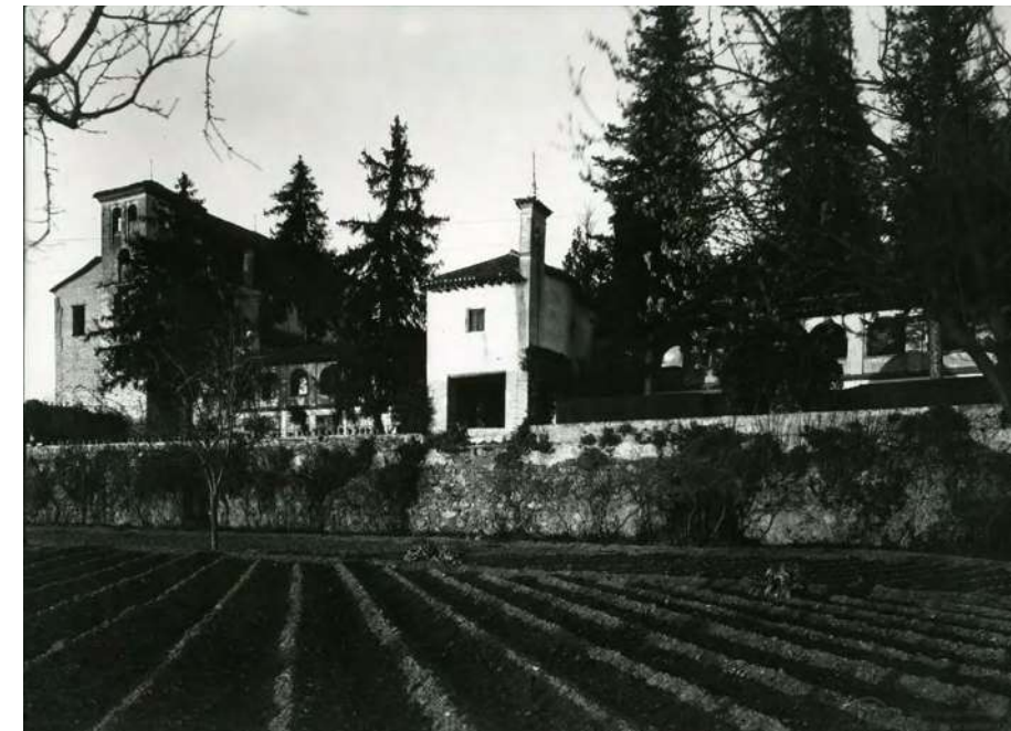
[Fig. 4] La capilla del Patio de la Acequia antes de su demolición. APAG, Colección de Fotografías, F-004095.
