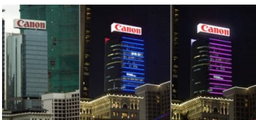
Fachada activa creada para la compañía Canon Autor instalación láser visión
