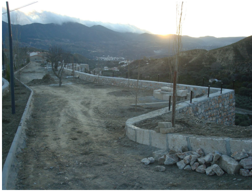
Mirador de Valle de Lecrín en construcción. Granada, 2010.
