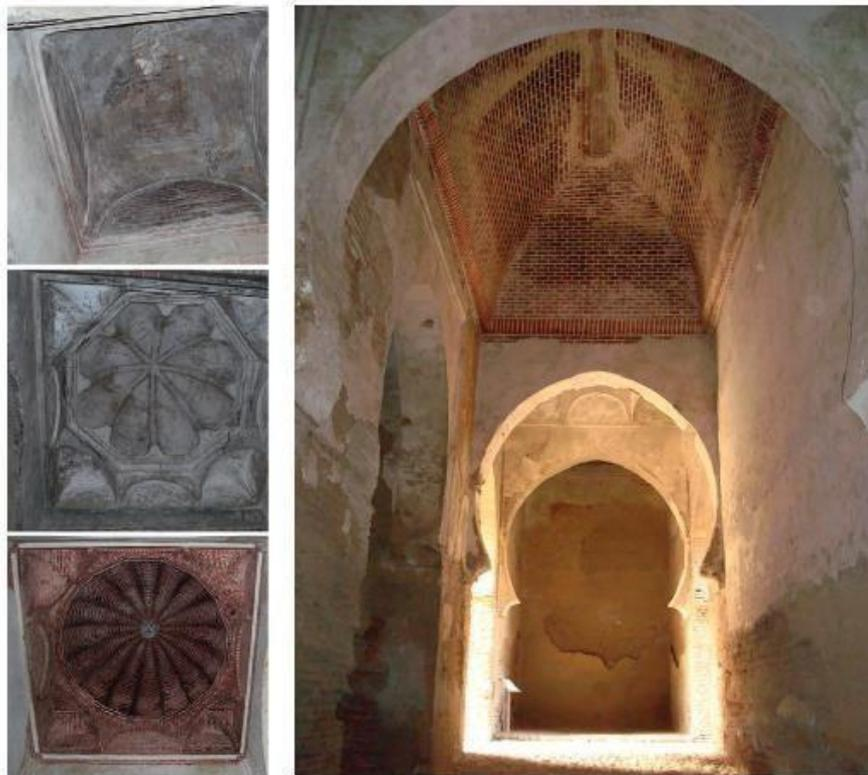
**Ilustración 47. Vistas interiores bóvedas. Bóveda vaída – bóveda de gallones – bóveda de gallones (2) – bóveda de cañón de espejo**
