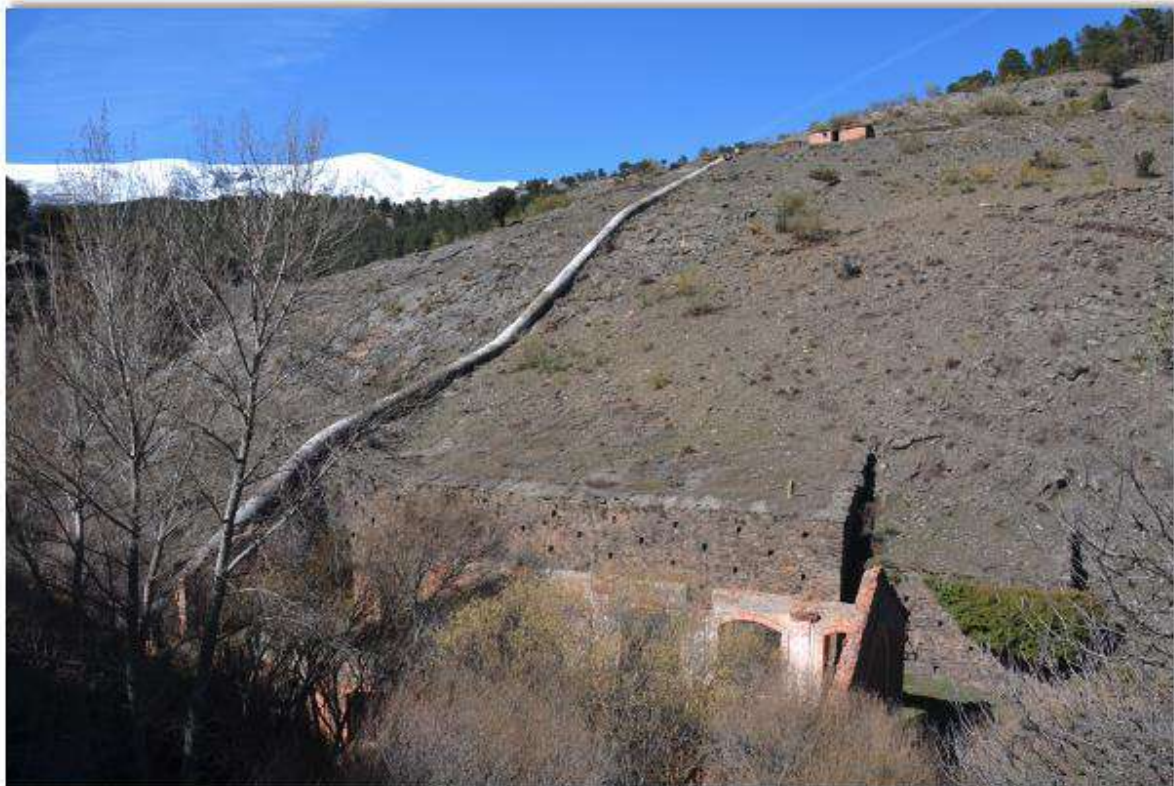
Figura 50. Tubería forzada de la central y Casa de Máquinas. Fuente: Fotografía del autor.
