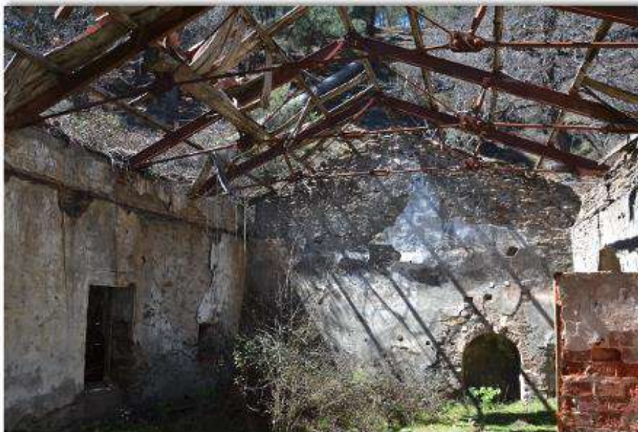
Figura 109. Estado actual del interior de la casa de máquinas. Fuente: Fotografía del autor.
