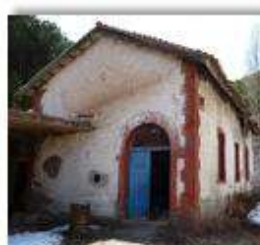
Casa de máquinas de la central hidroeléctrica Alhóri I. Imagen del autor
