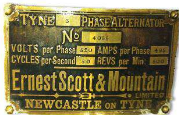
Figura 76. Placa de características del generador de la Central Hidroeléctrica Alhorí I. Fuente: Fotografía del autor.
