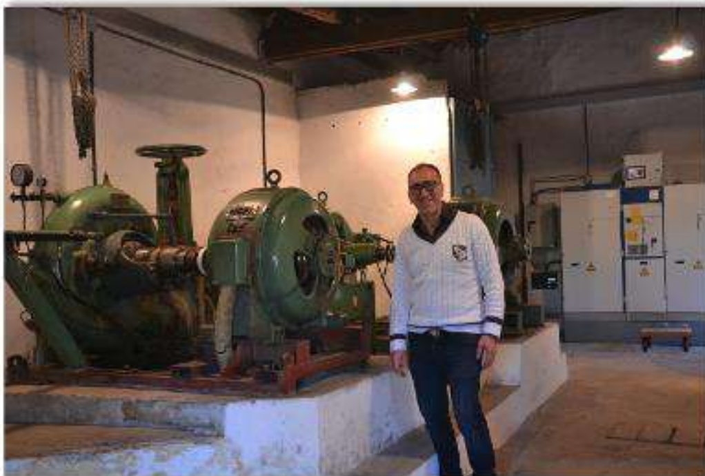
Figura 117. Visita del autor a la central.
