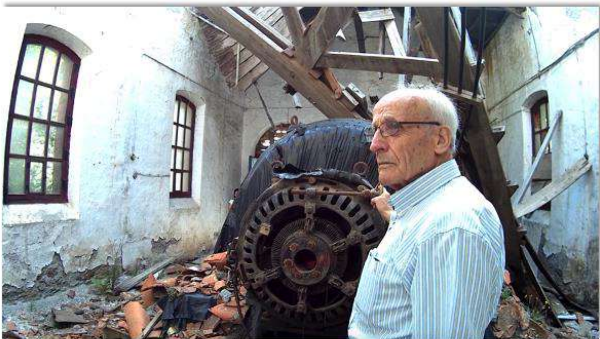
Figura 80: Juan Hidalgo "El Rubio", maquinista de la Central de Ahorí I. Regulando la antigua excitatriz del Generador Síncrono, mientras nos explica cómo funcionaba. Fuente: Fotografía del autor.
