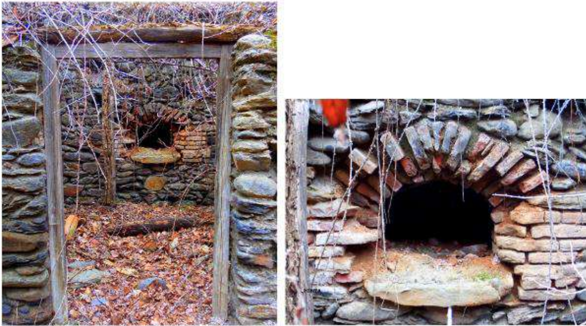
Figura 12. Horno de pan en la casilla del maquinistas del “Canal del Pérez”. Fuente: Fotografía de Pepita Estévez.
