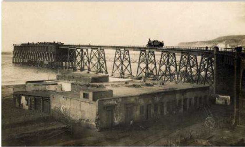
Figura 82. Cargadero de mineral de la compañía The Alquife mines en el puerto de Almería "Cable inglés" inaugurado en 1904.
