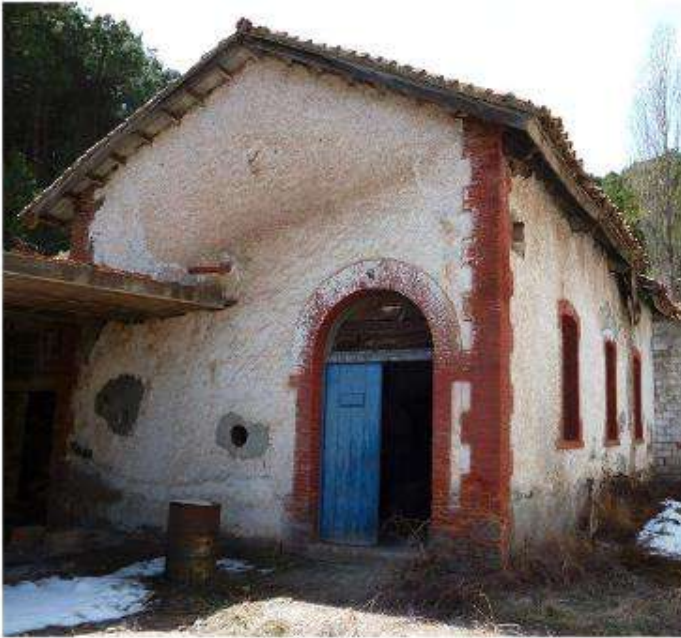
Figura 8. Casa de Máquinas. Fuente: Fotografía del autor.
