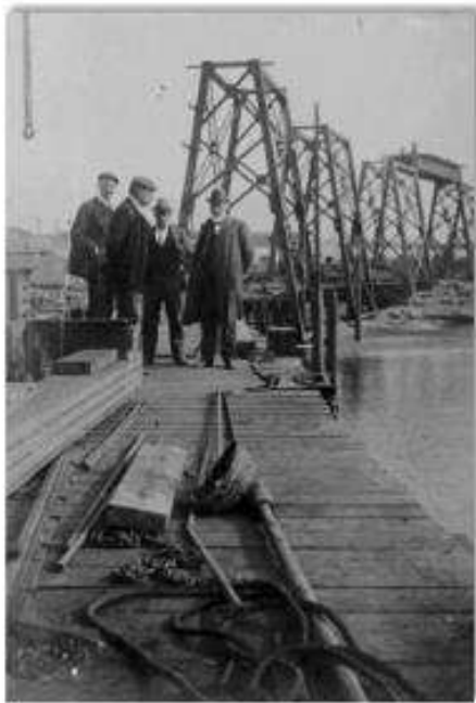
Figura 44. Construcción del embarcadero de mineral “cable inglés”.
