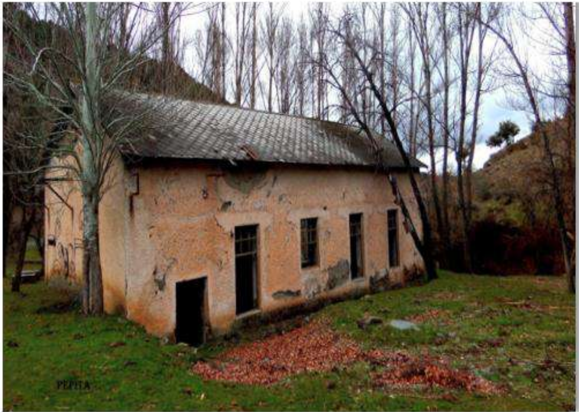
Figura 22. Casa de maquinistas de la Central del Sabinar, Canal del "Rata".
