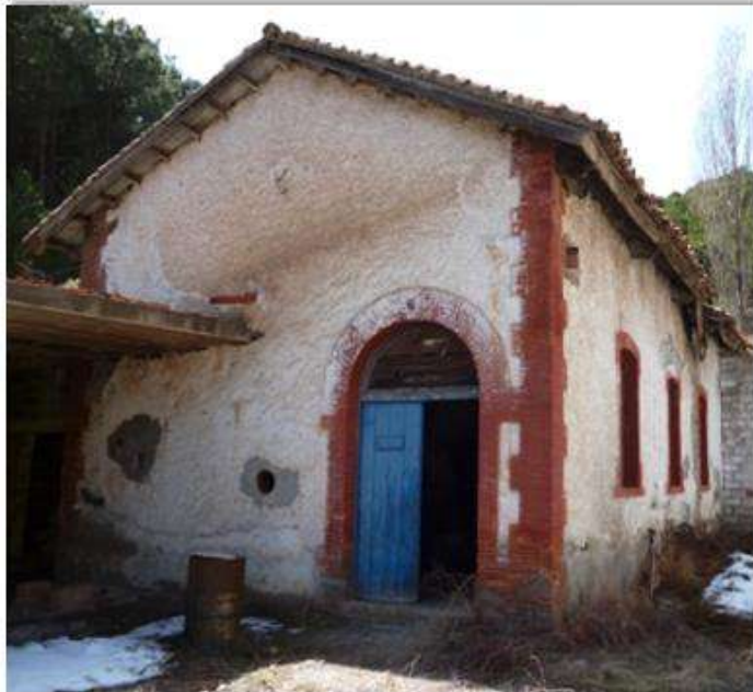
Figura 151. Centro de interpretación Alhorí I: Casa de máquinas de la central hidroeléctrica Alhorí I. Fuente: Fotografía del autor
