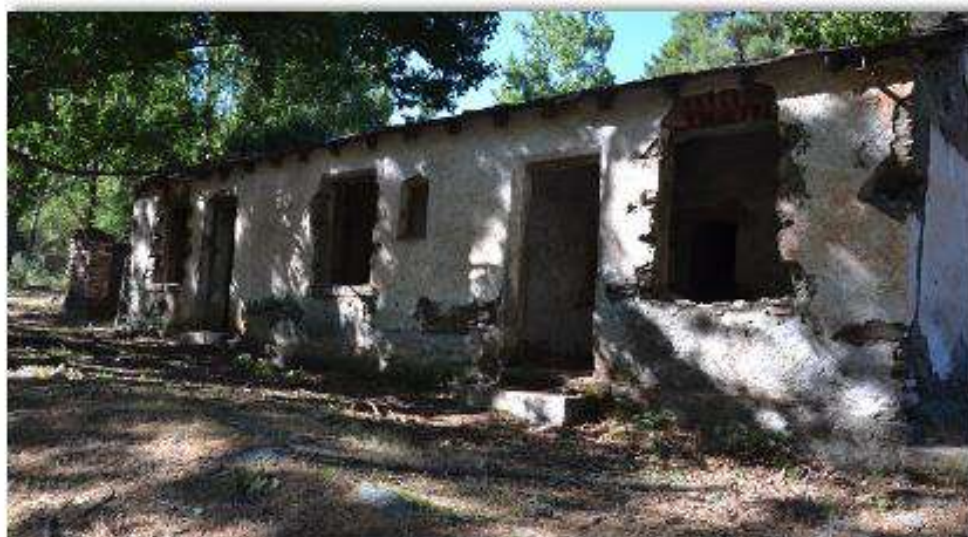
Figura 128. Casillas de los maquinistas de la Central Hidroeléctrica del Sabinar. Fuente: Fotografía del autor.
