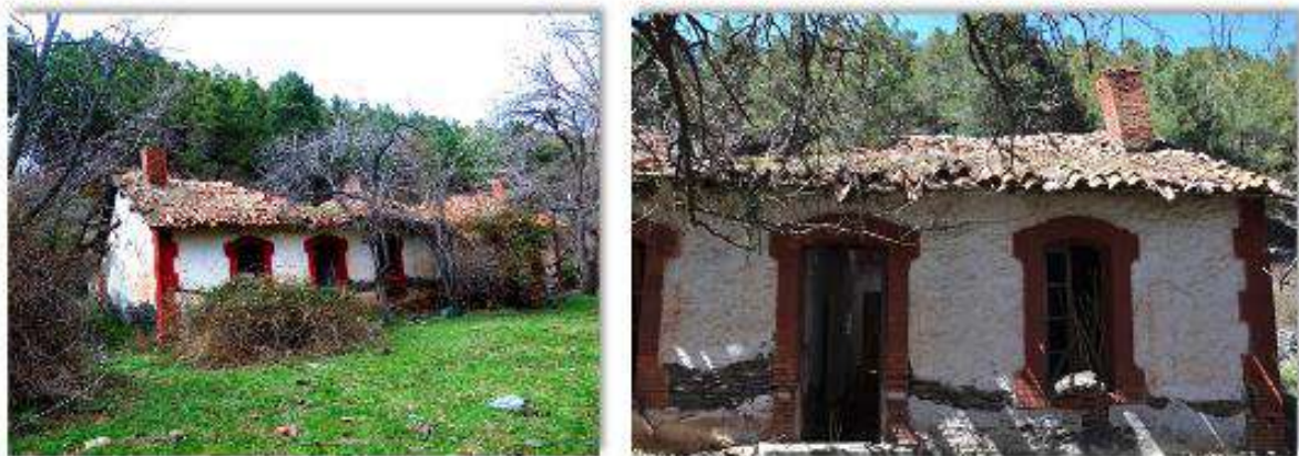
Figura 123. Casillas de los maquinistas de la Central Hidroeléctrica de Alcázar Fuente: Fotografía del autor
