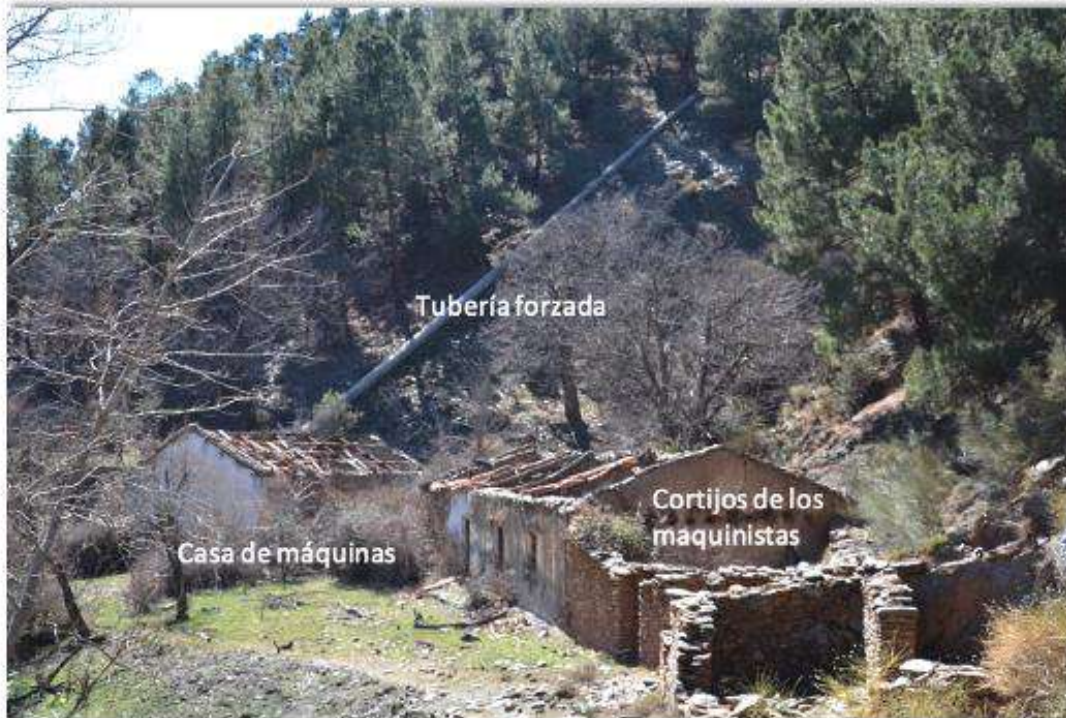
Figura 108. Central hidroeléctrica de Alcázar superior o “Canal de Evaristo” Fuente: Fotografía del autor.
