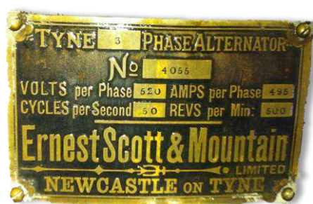
Figura 38. Placa de características del generador de la Central Hidroeléctrica Alhorí I. Fuente: Fotografía del autor.
