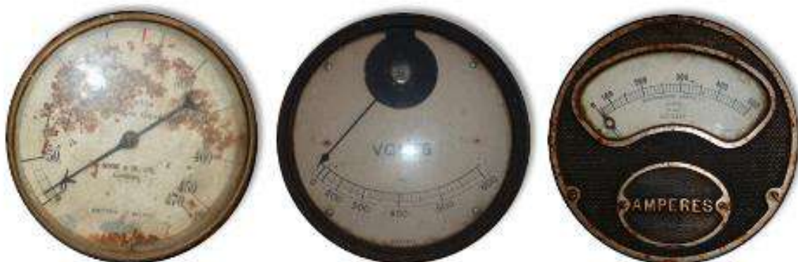
Figura 125. Central Hidroeléctrica Alhorí I. Aparatos de medida: caudalímetro, voltímetro y amperímetro. Fuente: Fotografías y montaje del autor.
