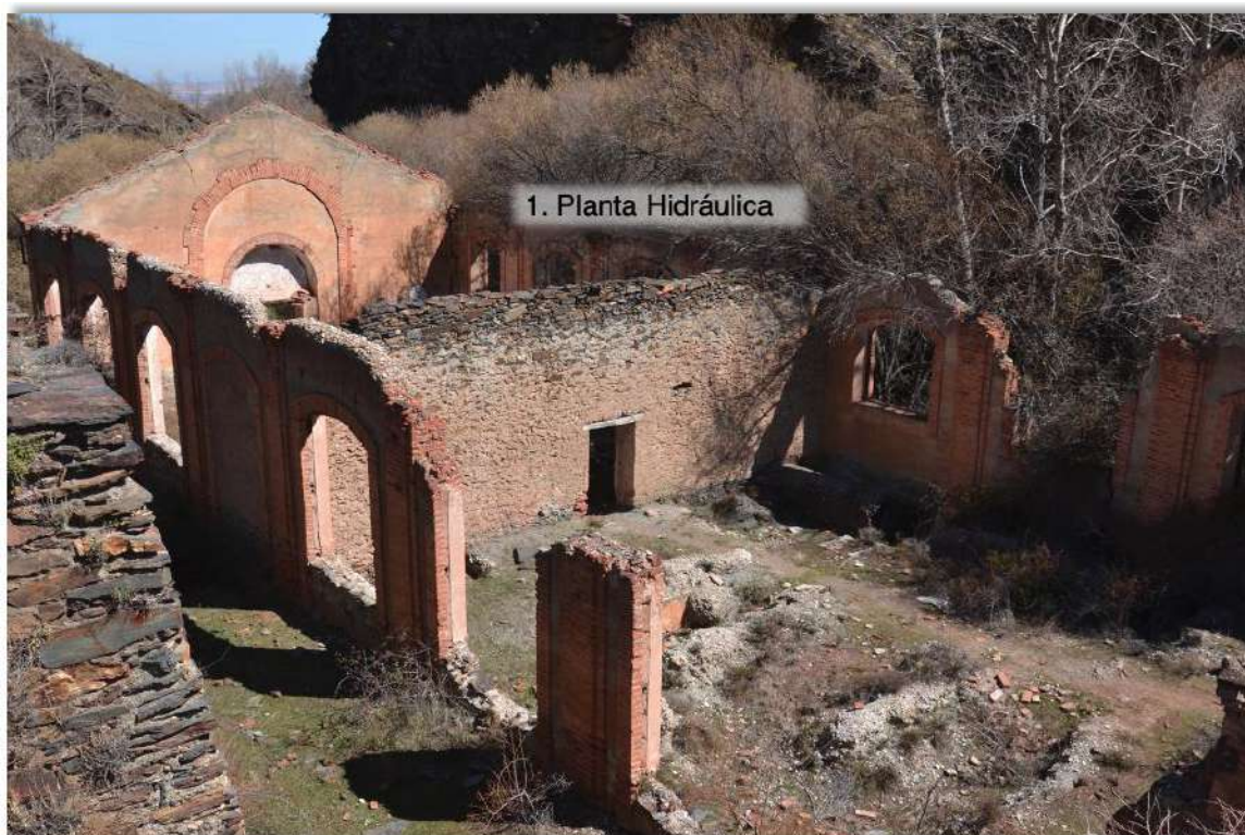
Figura 51: Estado actual en el que se encuentra la Planta Hidráulica. Fuente: Fotografía del autor, año 2017.
