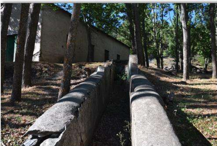
Canal de descarga de la central del Sabinar.
