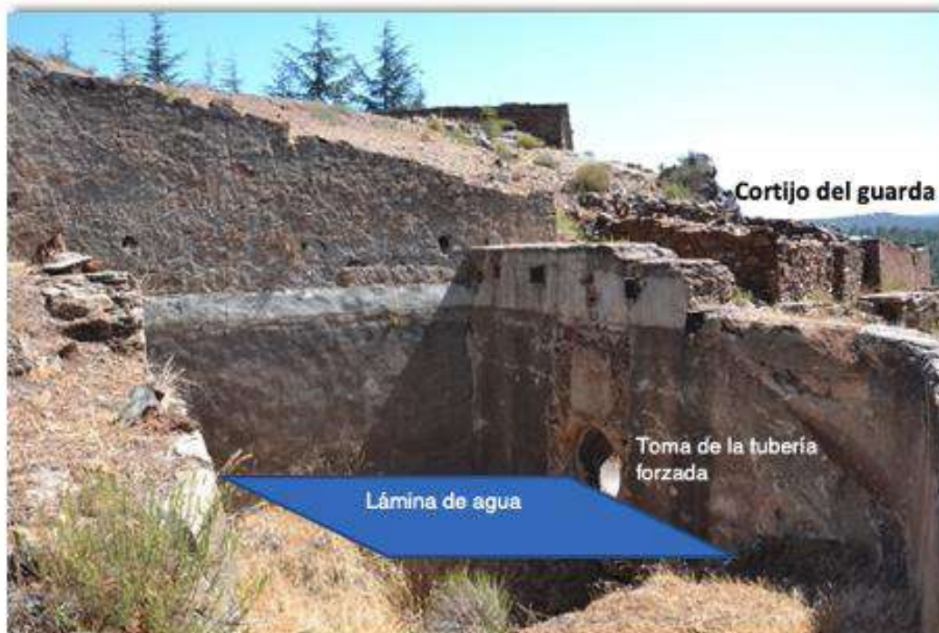
Figura 106. Cámara de carga y cortijo del guarda de la central Alhorí II. Fuente: Fotografía del autor.
