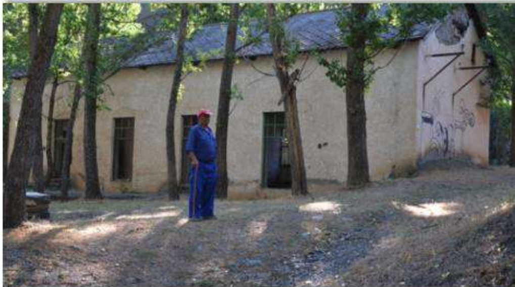
Figura 152. Centro de interpretación Sabinar: Casa de máquinas de la Central Hidroeléctrica del Sabinar. Fuente: Fotografía del autor.
