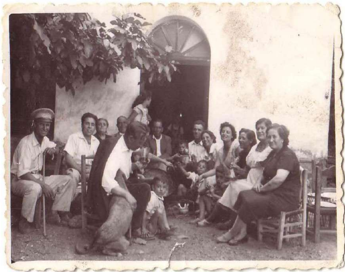
Figura 136: Familia Evaristo y amigos en la puerta de la casa de máquinas de la Central hidroeléctrica de Alcázar Superior. Fuente: Foto familiar de José Hernández Bugés.
