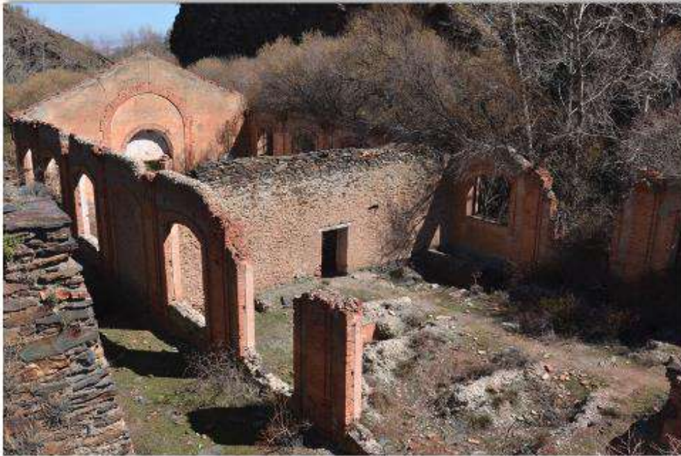
Figura 153. Planta Hidráulica minas de la Sociedad minera Jérez-Lanteira Fuente: Fotografía de los autores
