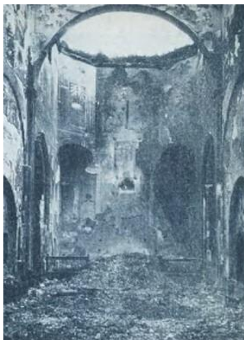
[81] Interior de la torre de la iglesia del Salvador, Granada. Foto: autor desconocido. Vértice , nº 3, junio de 1937.
