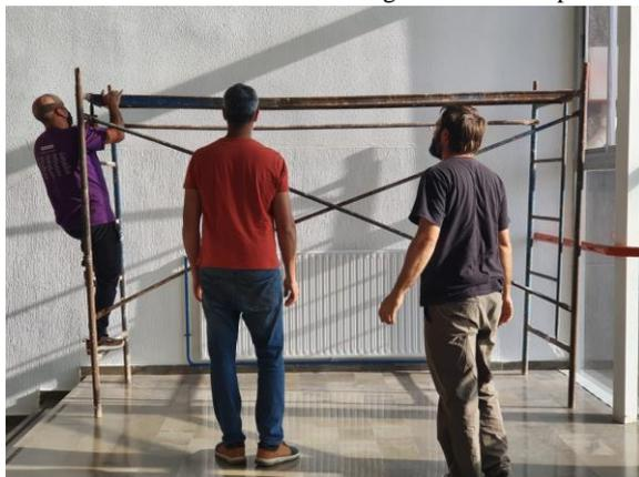
Figura 2. Montaje del andamio para la realización del mural
