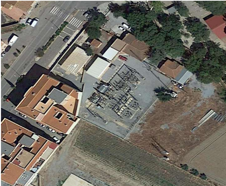
Figura 28: Imagen de satélite en Guadix (Granada), con una subestación eléctrica como infraestructura crítica.
