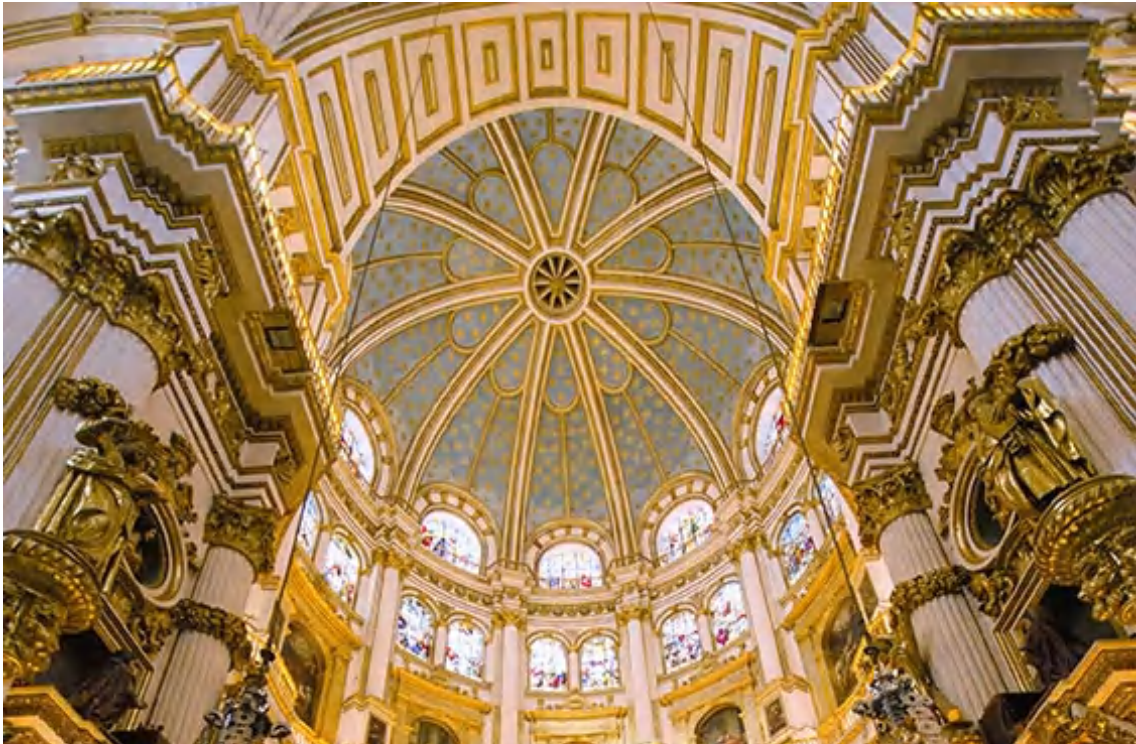
Bóveda de la Capilla mayor, Catedral de Granada
