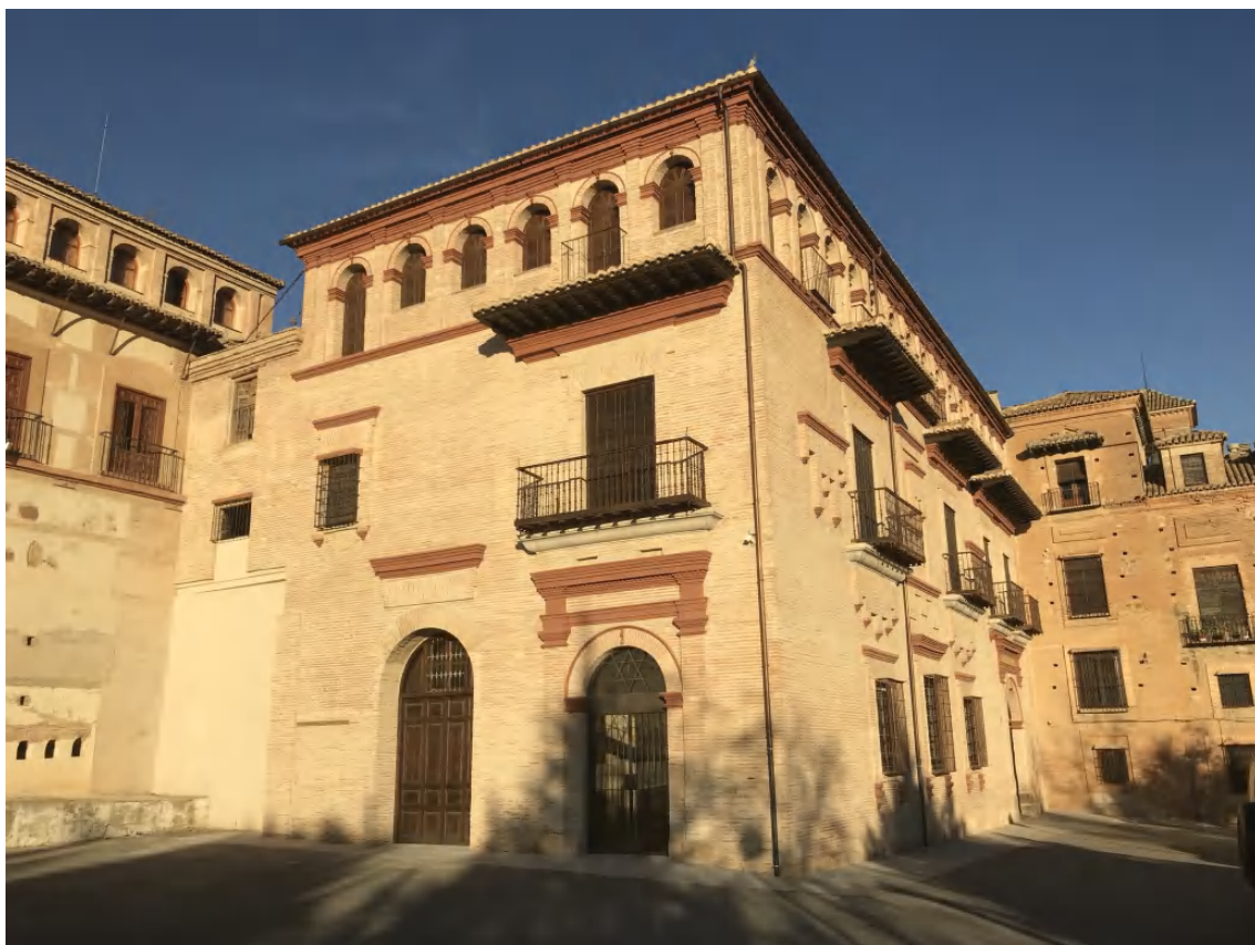
Fachada oeste del "Colegio nuevo", Abadía del Sacromonte (Granada)
