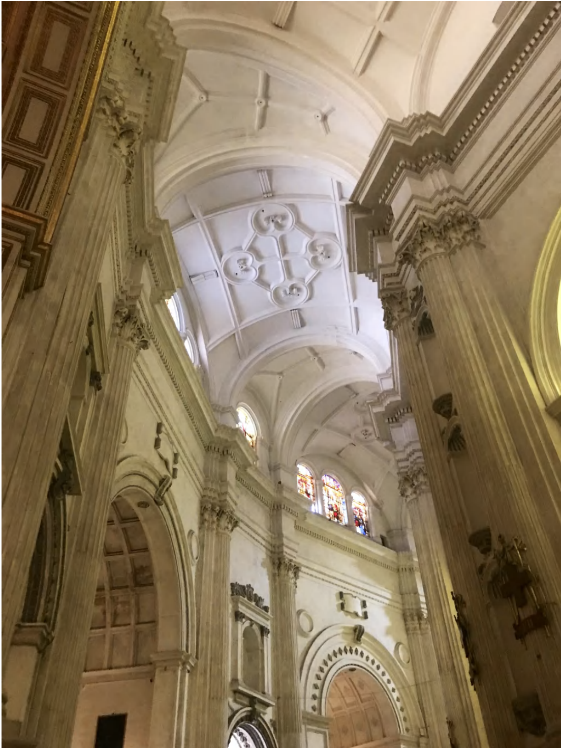
Bóvedas de la nave presbiterial próximas a la capilla de la Virgen de la Antigua , Catedral de Granada
