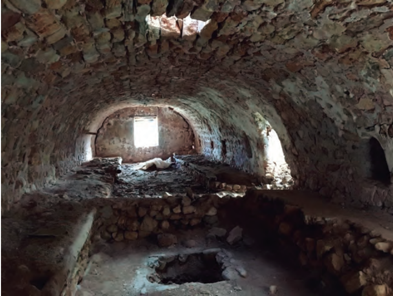
Fig. 14. Bóveda para trabajadores en Santo Antolino
