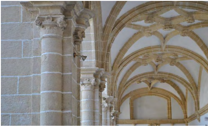
Lámina 2: Interior de la crujía contratada en 1548: pilares con semicolumnas y sistema de bóvedas de crucería.
