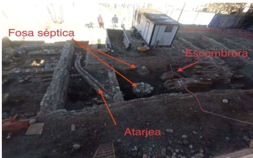
Figura 10. Vista general donde se aclaran las estructuras aparecidas.
