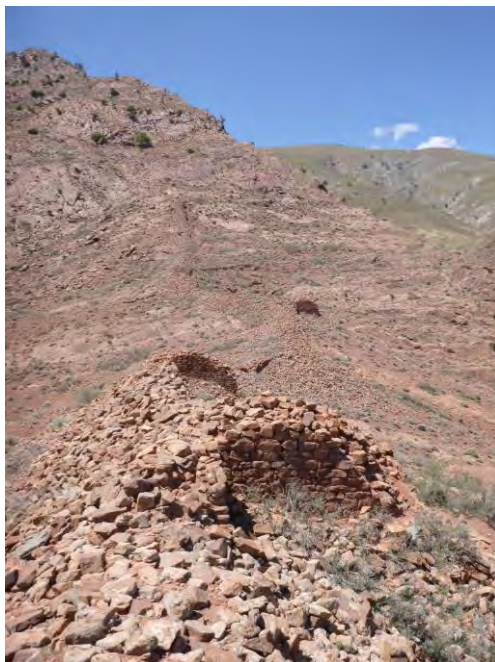
Fig. 10. Vista desde el S de la muralla de Tinmal. Tramo exclusivamente en mampostería (Sarr & Mattei, 2019)
