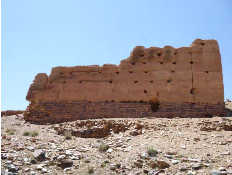
Fig. 14. Bastión de la muralla sur desde el E. Se observa su cimentación de mampostería bien concertada y el tapial
