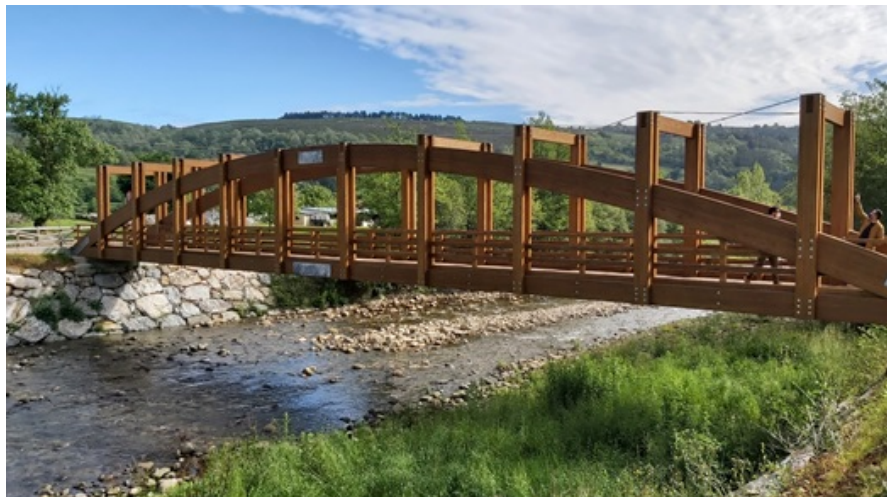
Figura 1. Pasarela peatonal construida en madera laminada en la localidad de Cieza (Cantabria).
