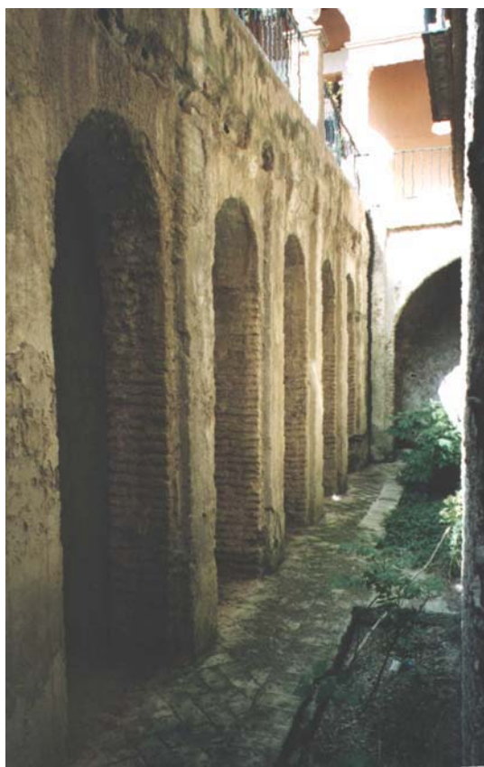
Fig. 2. Espacio liberado entre el frente inferior del pórtico islámico y el corredor del Apeadero. Se aprecian los arriates originales.
