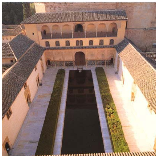
Fig. 24. El ala meridional del patio de Comares, cuya planta alta es añadida en tiempos de Muhammad V (Orihuela 1996: Fig. 44).
