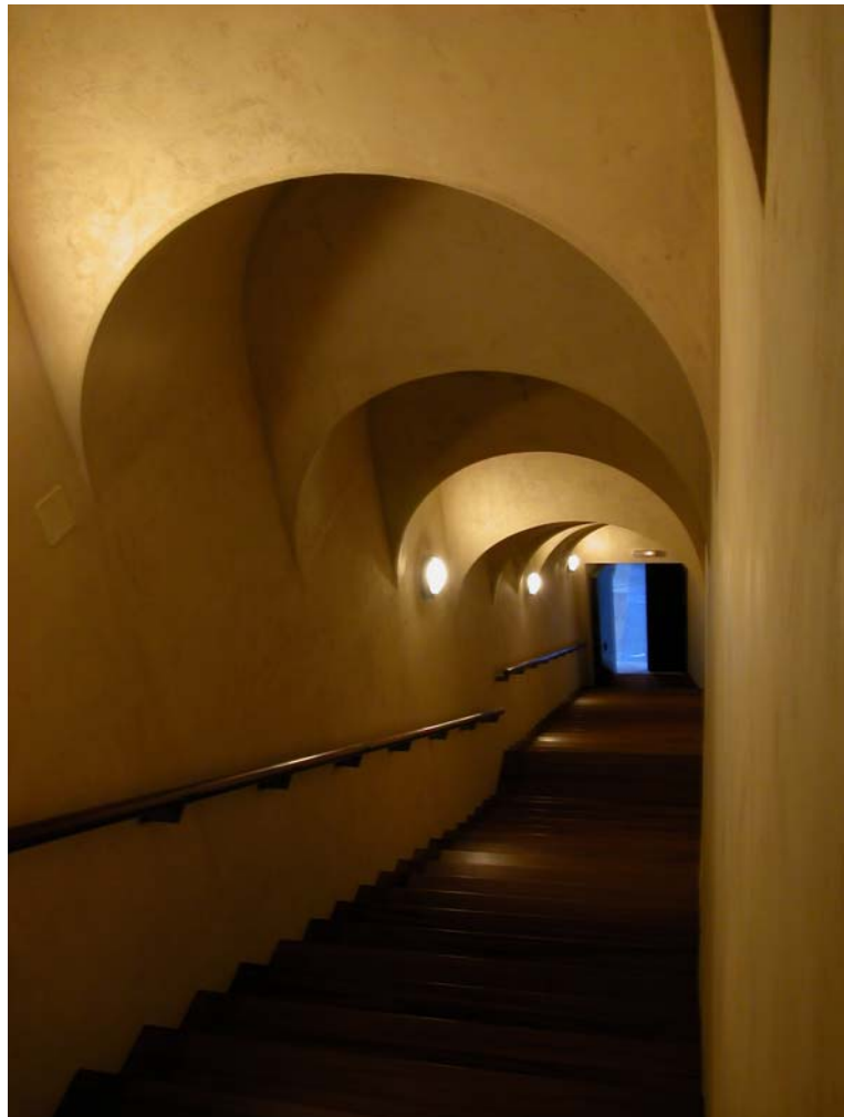
Fig. 59. Escalera de acceso a la planta alta donde se aprecian los dos tramos constructivos
