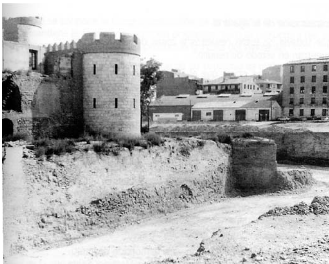
Fig. 27. Recuperación del foso y de los baluartes del siglo XVI bajo la dirección de A. Peropadre, 1982 (Sobradieil 1998a: Fig. 126)
