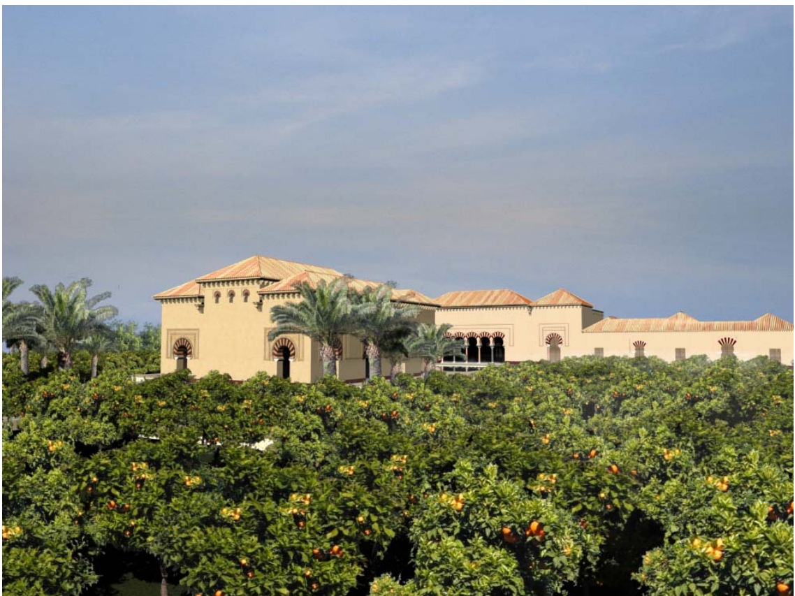
Fig. 13. El jardín superior. El Pabellón Central en contraposición al Salón Rico que sobresalen en medio del vergel
