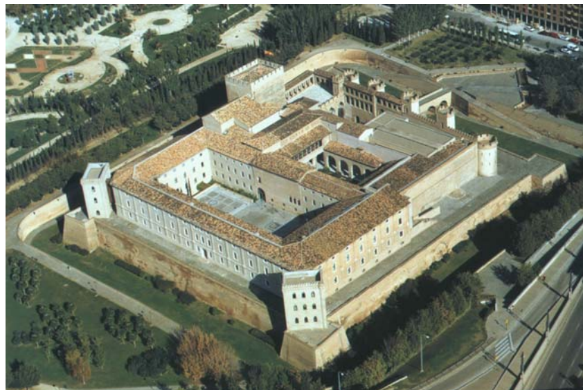
Fig. 8. Vista aérea en la actualidad de la Aljafería de Zaragoza (Paisajes Españoles)
