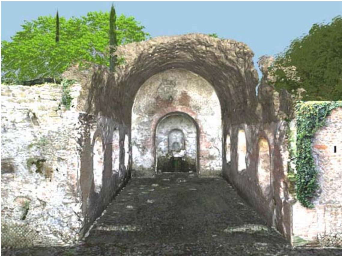
Fig. 38. Reconstrucción fotorrealística del Ninfeo de Egeria en la Caffarella, Parco dell'Appia Antica, a partir de los datos 3D obtenidos con el escáner láser Cyrax 2500. Realizado por el Virtual Heritage Lab del CNR-ITABC (Roma)
