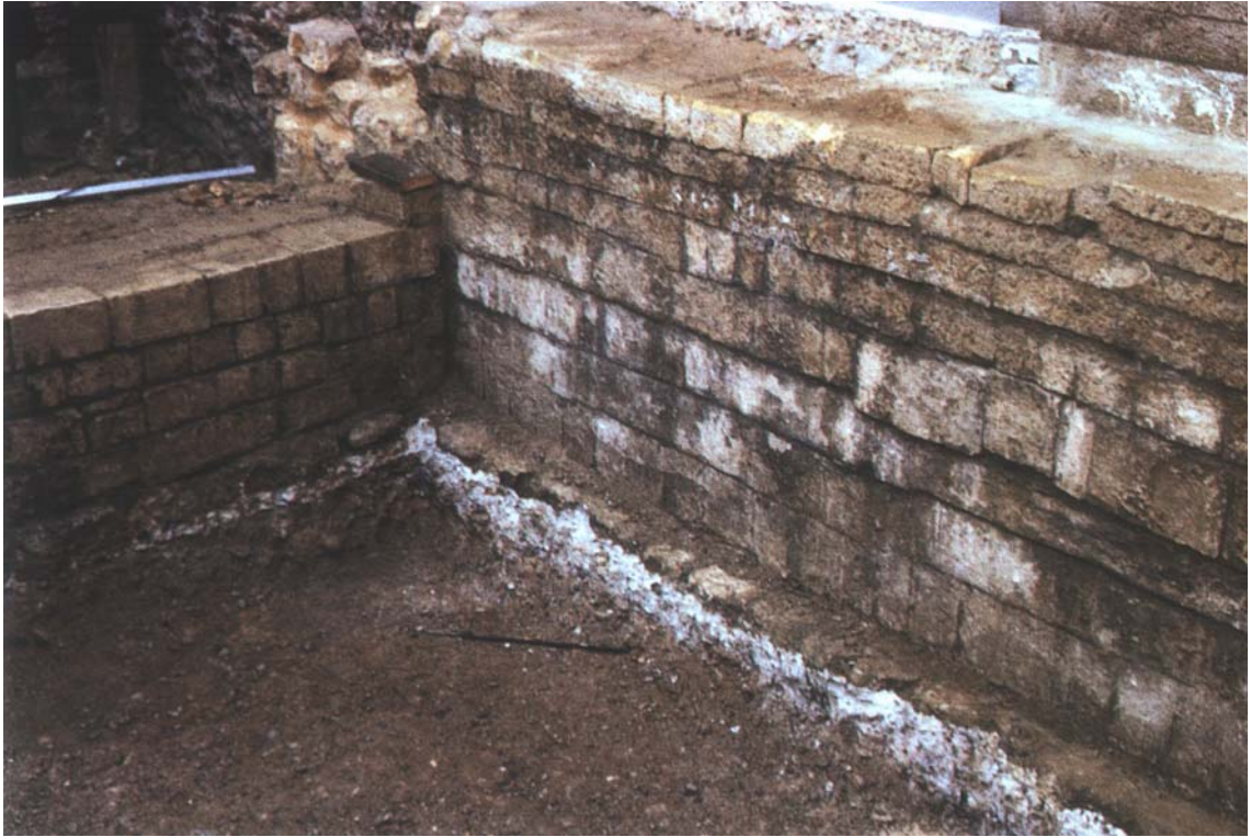
Fig. 79. Excavación de la alberca Sur donde se aprecia el desnivel entre la zona lateral y la central (Martín-Bueno y Sáenz 1998: 197)
