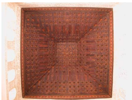
Fig. 5. Vista de la armadura que cubre el espacio de la qubba
