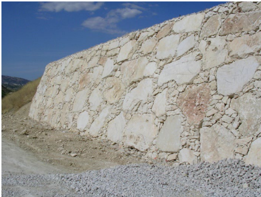
Figura 3.2. Muro de escollera en una carretera. Jaén (España)
