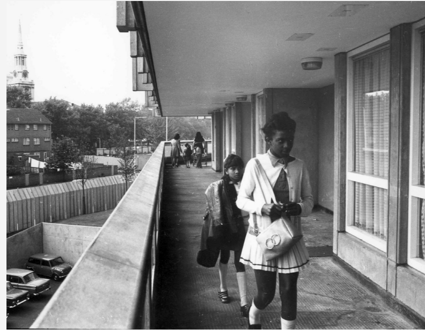
▲ Robin Hood Gardens (1972). Alison y Peter Smithson, corredor de acceso a las viviendas de Robin Hood Gardens. Fuente: Sandra Lousada, 1972 © The Smithson Family Collection vía Municipal Dreams.
