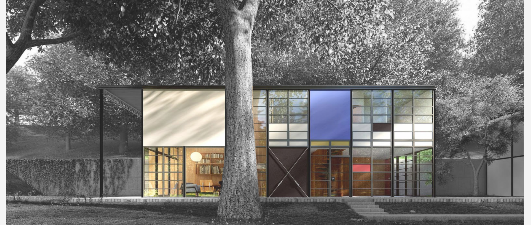
▲ Casa nº8 (1949). Charles y Ray Eames. Fachada modular a base de paneles Cemesto.
