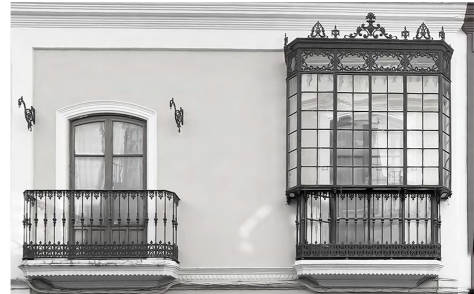
37 - Cierre metálico actual de la casa número 22 de la calle del Conde. Se observa el cierre metálico de hierro fundido, posterior a la reforma de 1884, de barras ornamentadas, característico del estilo neoclásico.
