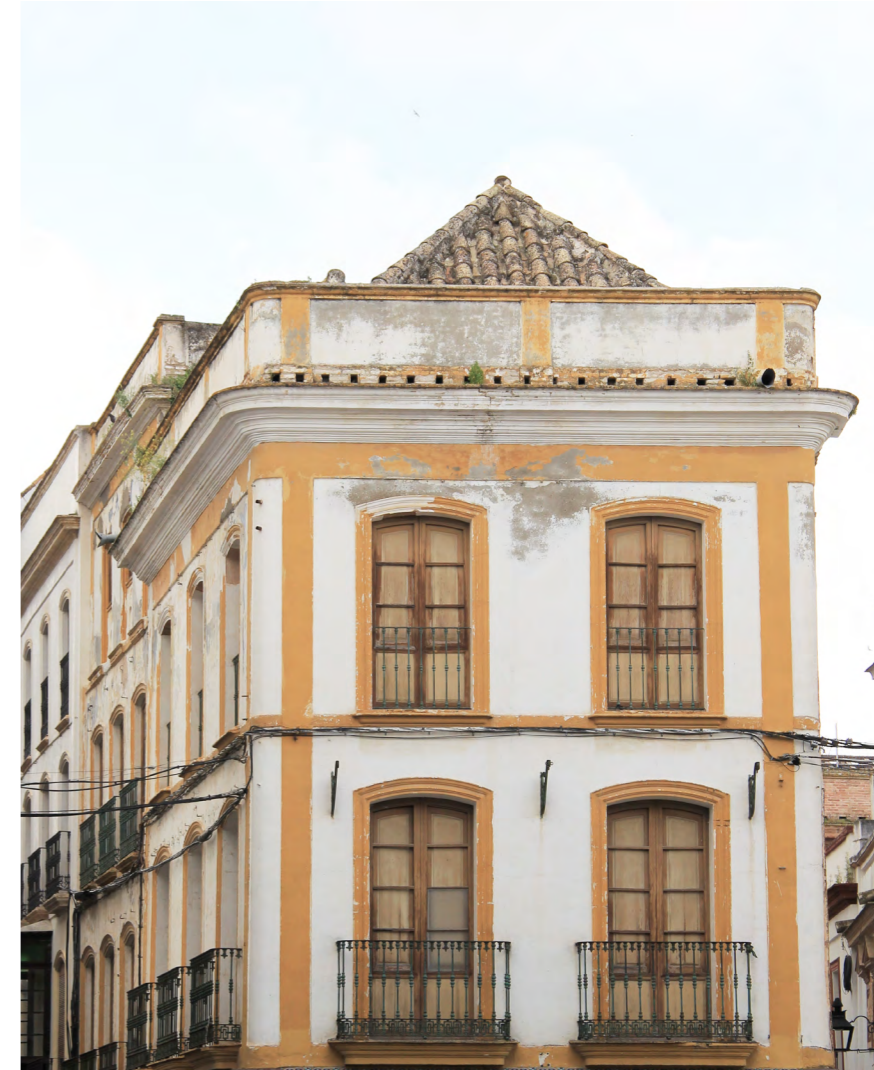
13 · Ejemplo de vivienda con cubierta inclinada oculta tras un pretil de fábrica.
