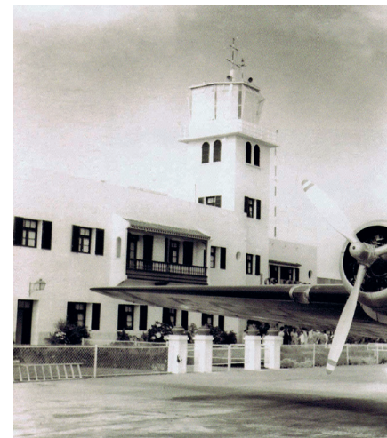
Torre de control modificada, 1950. Utrilla Navarro y Díaz Lorenzo, 2006.
