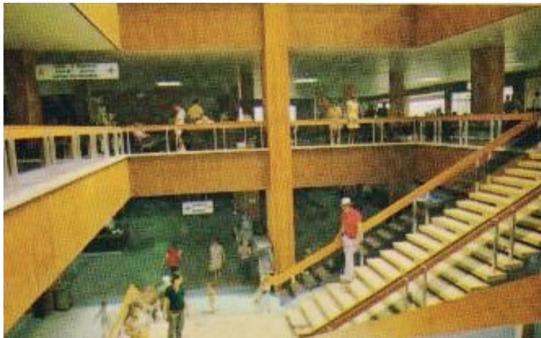
Interior de la terminal de 1968, hueco de la escalera. Archivo Todocolección.
