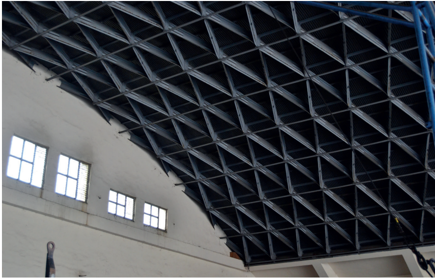
Vista interior de la cubierta del hangar. Fot.: Beatriz Delgado, 2017.
