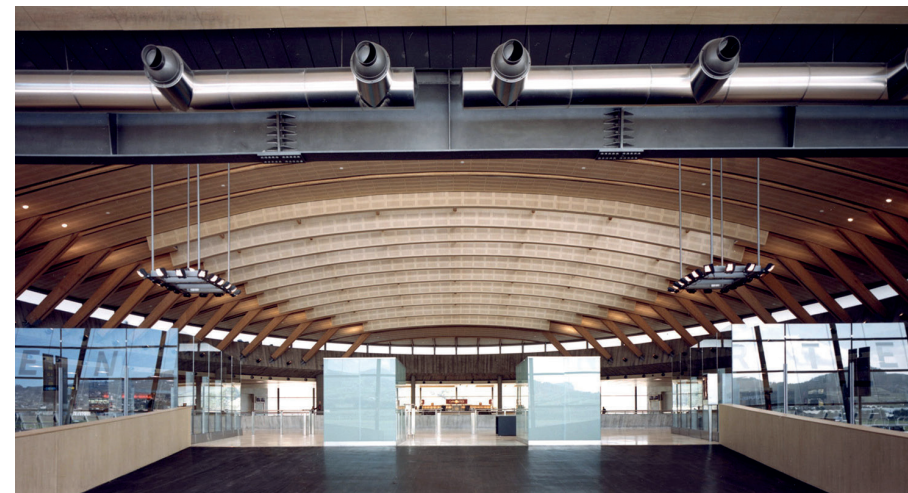
Vista del anillo superior antes de los cambios en la distribución interior, 2002. Archivo Corona-Amaral Arquitectura.
