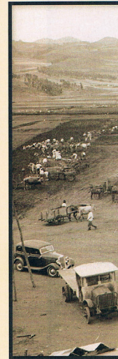
Detalle de las tareas de explanación de la pista del futuro aeropuerto de Los Rodeos. (Foto Benítez.)
