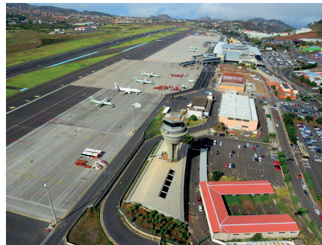
Vista aérea del Aeropuerto de Tenerife Norte. Fot.: Antonio Márquez, 2017.
