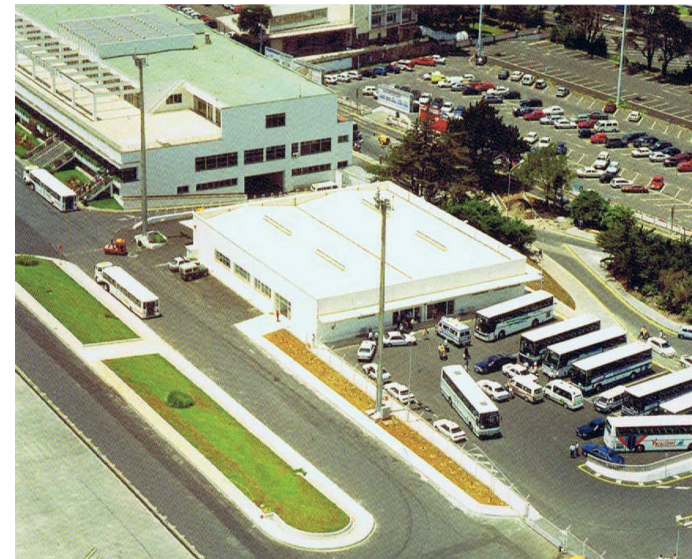
Situación previa a la construcción de la actual terminal. Terminal de 1968 y edificio de recogida de equipajes demolido, años 80. Utrilla Navarro y Díaz Lorenzo, 2006.
