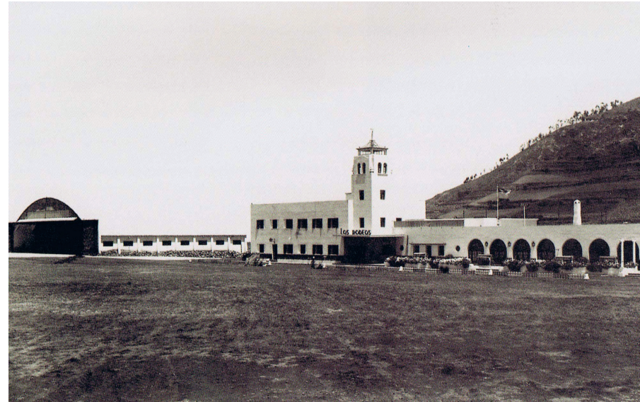
Vista exterior de la terminal y el hangar, años 40. Fot.: Adalberto Jorge Benítez Tогores. Imágenes para el Recuerdo, Portafolio de Tenerife, 1997.
