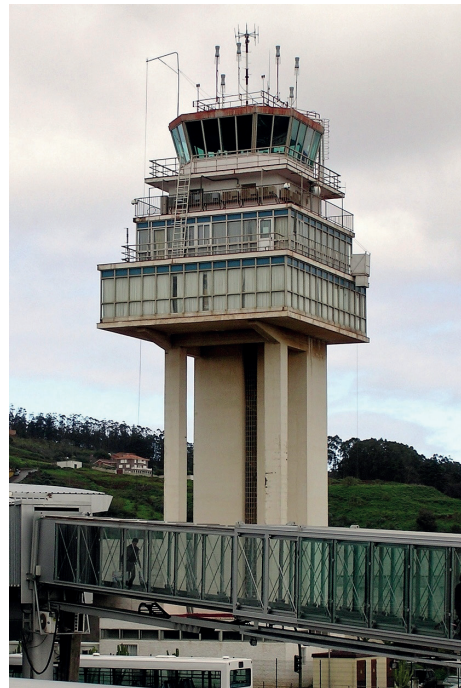
Antigua torre de control, 2004. Archivo airliners.net .
