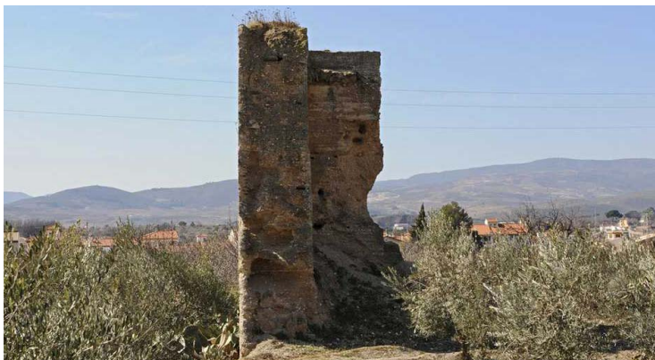
Imagen 27. Alzado del muro
