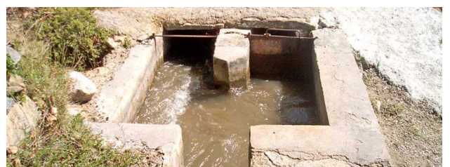
Imagen 129. Partidor de agua para los molinos de la zona
