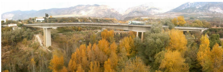
Imagen 74. Panorámica del puente
