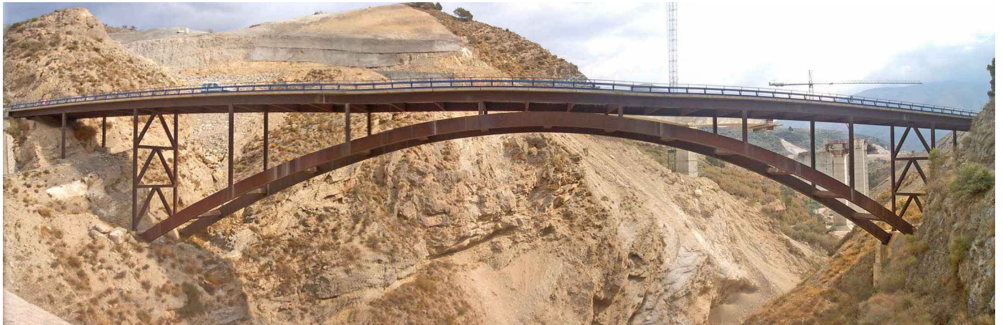
Imagen 97. Vista frontal del puente
