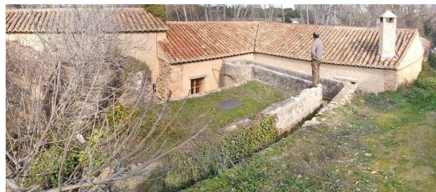
Imagen 145. Entrada de agua
