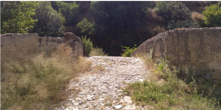
Imagen 67. Calzada del puente
