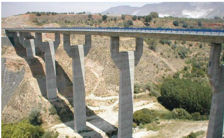
Imagen 75. Vista en escorzo del viaducto
