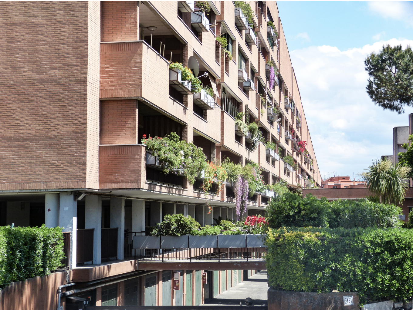
F23. Planta baja de Casilino: calle rehundida como garaje y contacto al espacio interbloque. Fotografía propia.
