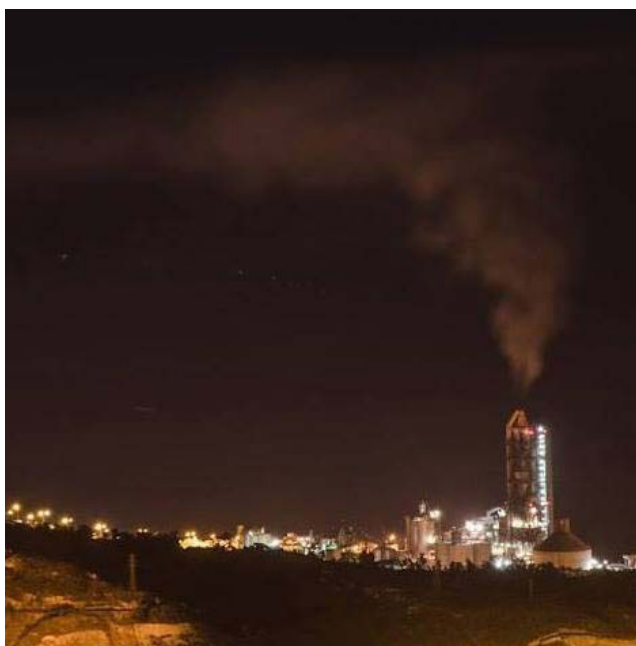
Foto de la cementera trabajando de noche._Fuente: Revista El Observador.
