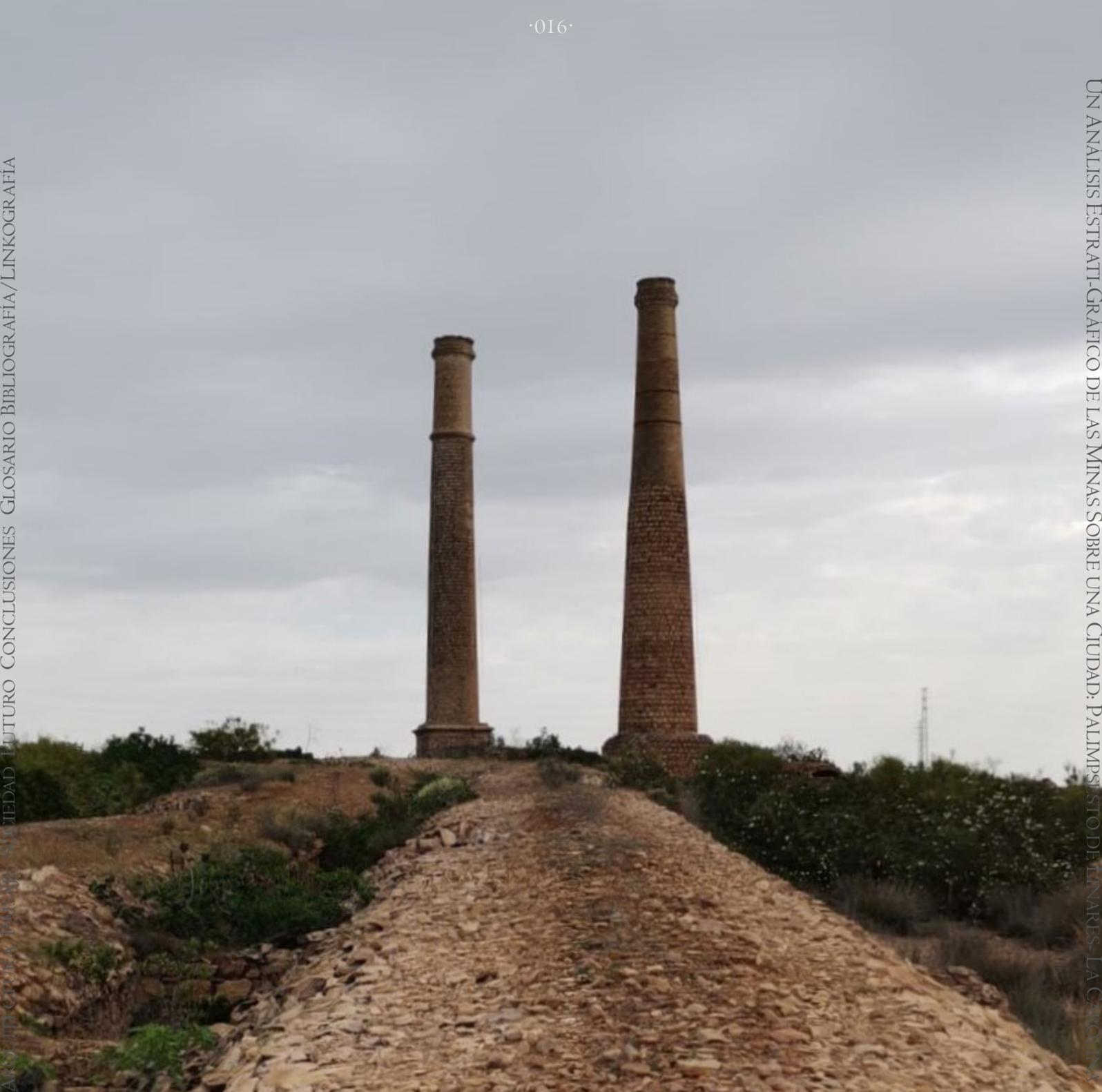
↑ Foto 3 Capturada por la autora a dos chimeneas sobre un conducto de ventilación de La Tortilla.
