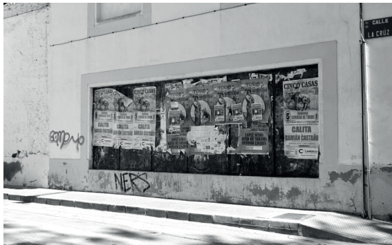
[79] Cueva-bodega Perales. Tomelloso (Ciudad Real). 1929. Piquera. Fuente propia.
