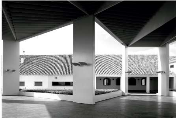
[97] Paredes Pedrosa. Bodegas Real. Valdepeñas (Ciudad Real). 2007. Fachada nueva con fachada existente. Fuente: https://www.metalocus.es/
