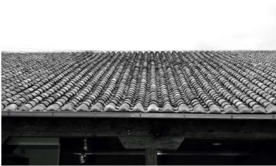
[53] La antigua Bodega de Los Llanos, Valdepeñas (Ciudad Real), 1875. Cubierta soportales. Fuente propia.
