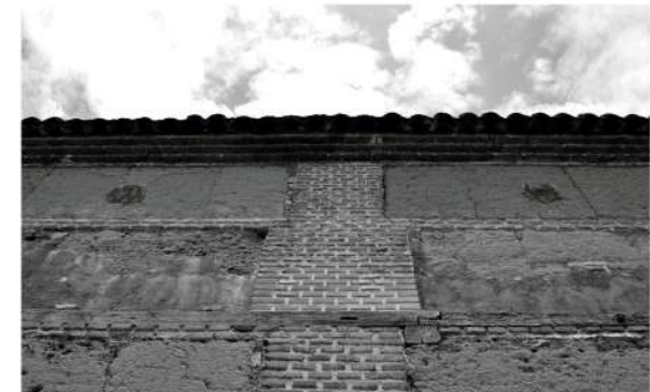
[35] Bodega Finca Loranque. Bargas (Toledo).s. XVIII. Detalle fachada tapial toledano encuentro con cubierta soportales. Fuente propia.
