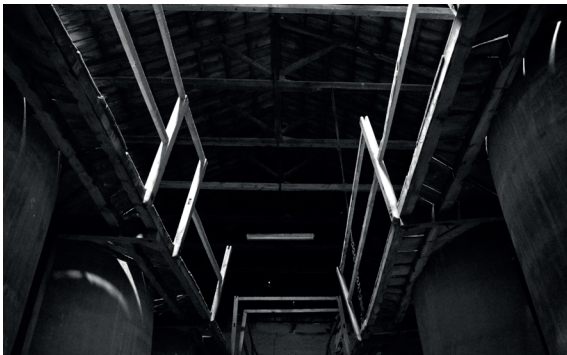
[70] Bodegas Navarro. Valdepeñas (Ciudad Real). s. XX. Cercha de cubierta junto empotres de madera. Fuente propia.
