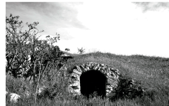
[11] Entrada a cueva-bodega. Villar de Domingo García (Cuenca). s. IX-XV. Alzado de arco de la entrada. Fuente propia.
