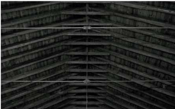
[37] Bodega Finca Loranque. Bargas (Toledo). s. XVIII. Estructura de cubierta. Fuente propia.
