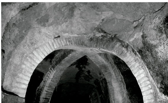
[31] Cueva-bodega Calle Era Alta 36. Camarena (Toledo). s. XVI. Bóveda de crucería. Fuente: CRESPO FRAGUAS, A., DIAZ MORENO, M.A., ISABEL LUDEÑA, S. (COTA 667), Las cuevas de Camarena , Camarena (Toledo), Ayuntamiento de Camarena y la Diputación Provincial de Toledo, 2017, documentación inédita facilitada por Cota 667.
