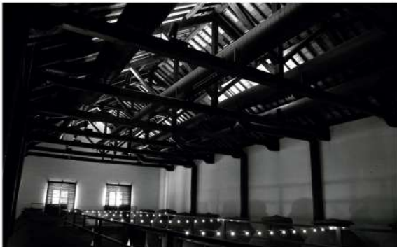
[54] La antigua Bodega de Los Llanos, Valdepeñas (Ciudad Real), 1875. Sala de fermentación. Fuente propia.
