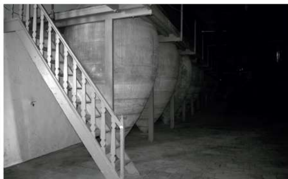
[72] La antigua bodega Peinado, Valdepeñas (Ciudad Real), 1919. Empotres de la sala de fermentación. Fuente propia.
