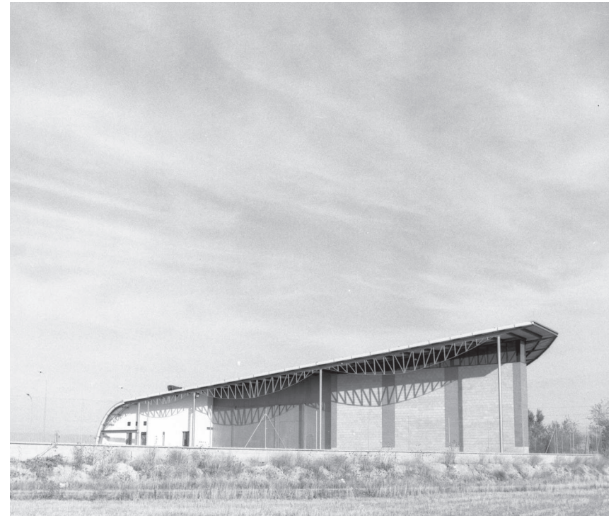
[96] Eloy Celaya. Bodegas Celaya. La Roda (Albacete). 1999. Alzado este. Fuente: Pedro López Carriches y Eloy Celaya Escribano
