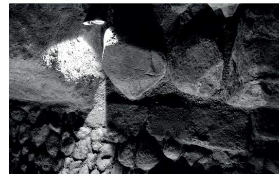
[30] Cueva-bodega. Mérida (Toledo). s. XVI. Detalle pavimentación con canalización. Fuente propia.
