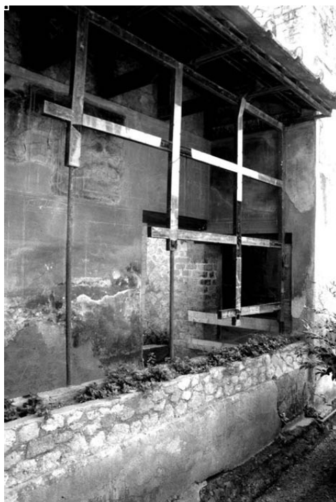
Fig. 53. Bastidor de madera del pórtico oriental del viridarium de la Casa del atrio en mosaico en Herculano (Vipard, 2009: Fig. 9).
